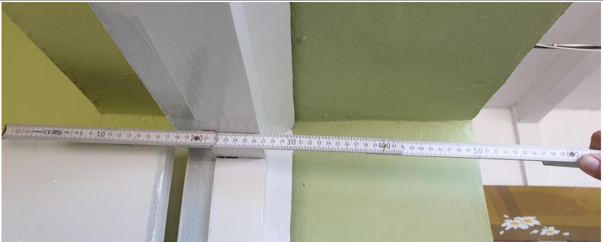
Attēls 12 Ēkas nesošās gala sienas biezums 510mm.
