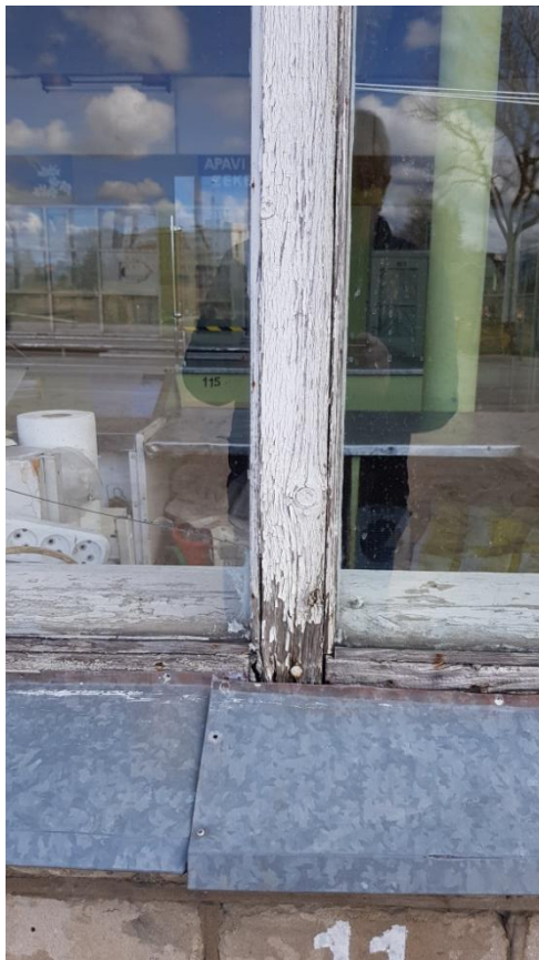
Attēls 36 Koka konstrukcija mitruma bojāta.
