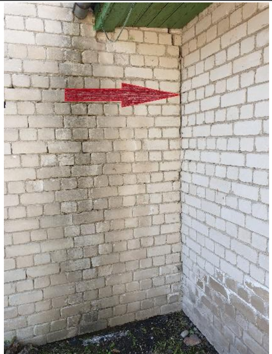
Attēls 14 Tā pati siena no ārpuses, kā redzams, iekšējā plaiza veidojusies sienu pieslēguma vietā.
