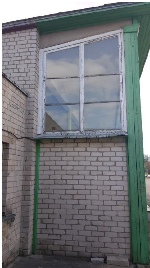
Attēls 39 Aizmūrēta durvju aile. Logs koka konstrukcijas.
