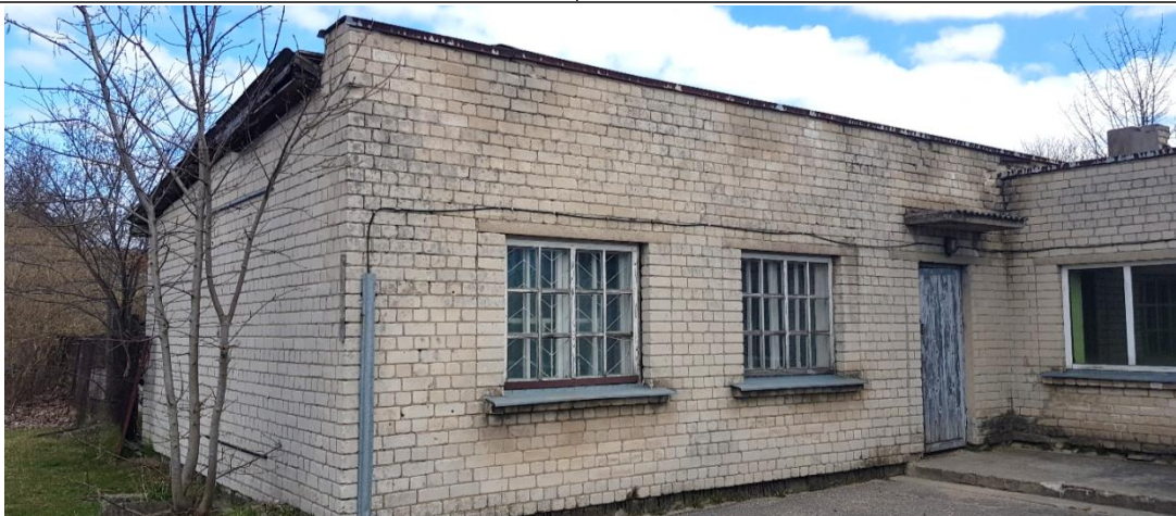
Attēls 15 Aiļu dzelzsbetona pārsedzes.
