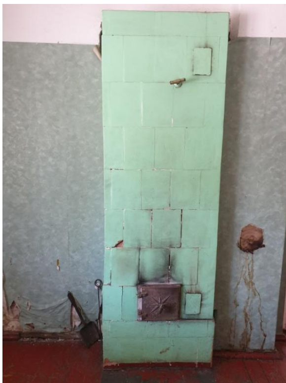
Attēls 43 Krāsns podiņi izdeguši, ekspluatācijai bīstami.
