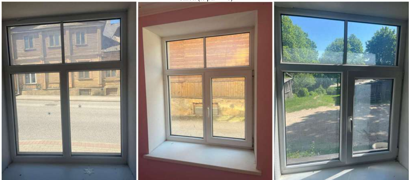
Visā dzīvoklī uzstādīti PVC logi
