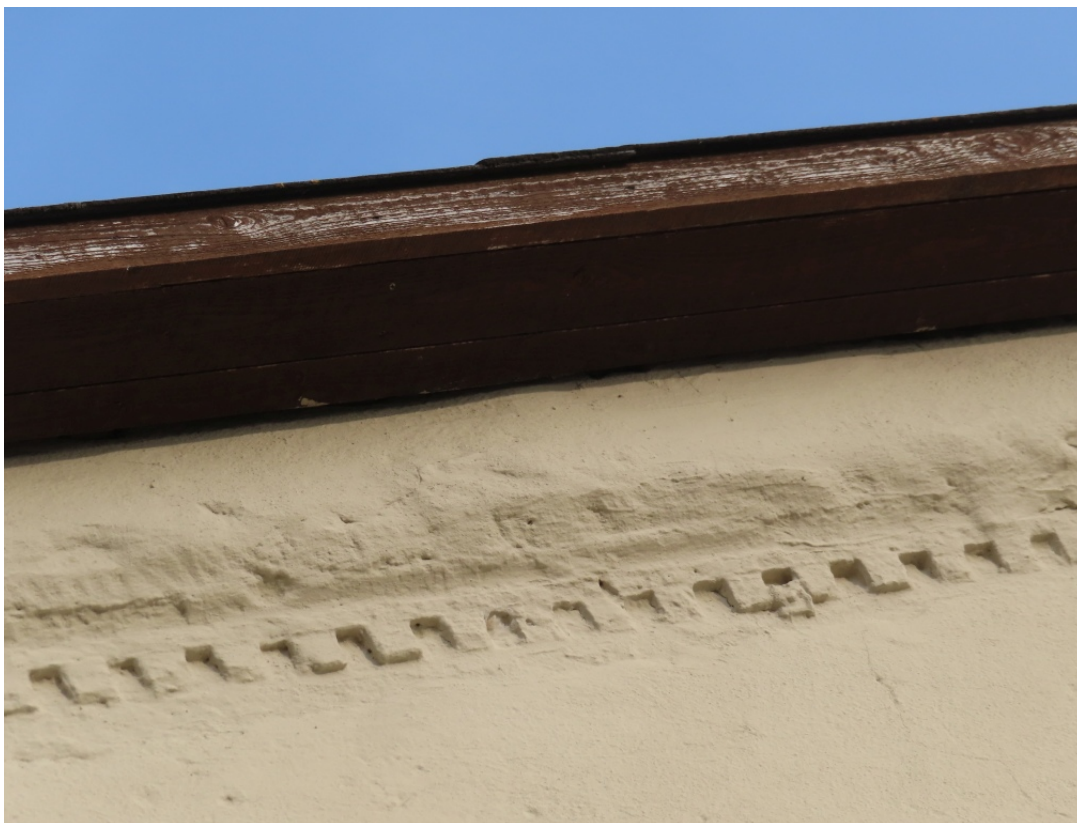
Ventspils_12_88130010002001_dzega2 Daļēji saglabājusies sākotnējā dzega mezonīna frontonā.
