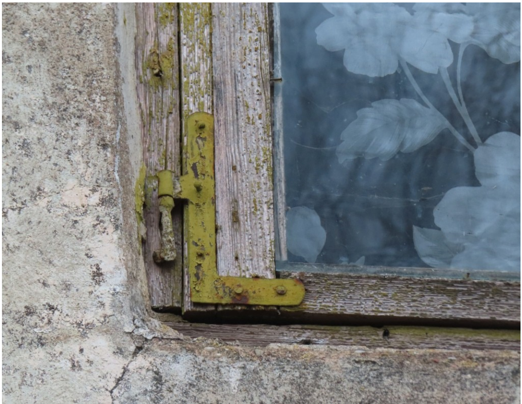
Ventspils_16_88130010091001_logs2 Sākotnēja loga kāšu vira.
