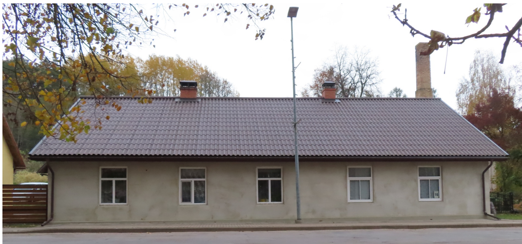
Ventspils_16_88130010091001_fasade3 Skats uz ēku no dienvidrietumiem.
