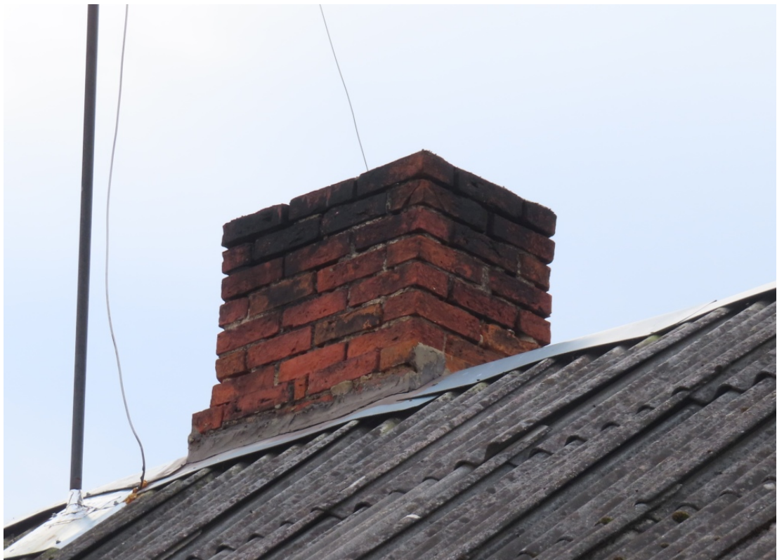
Ventspils_15_17_88130020129002_detala1 Sākotnējs skurstenis.
