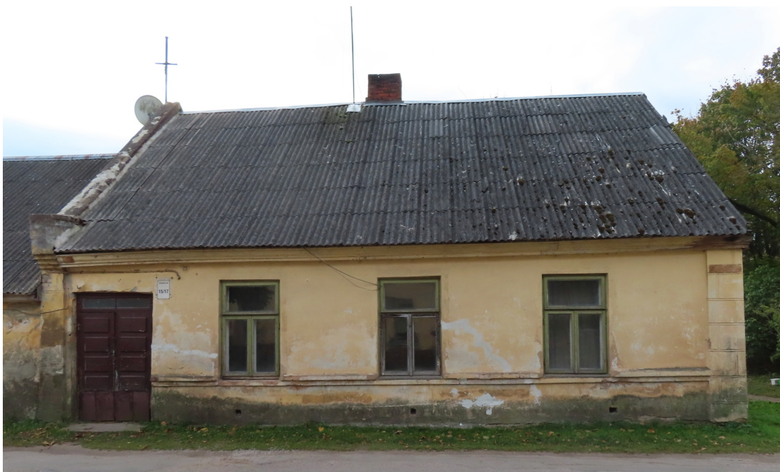
Ventspils_15_17_88130020129002_fasade2 Skats uz ēku no ziemeļaustrumiem.
