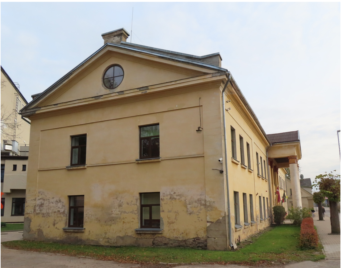
Ventspils_14_88130010045001_fasade6 Skats uz ēku no ziemeļrietumiem.
