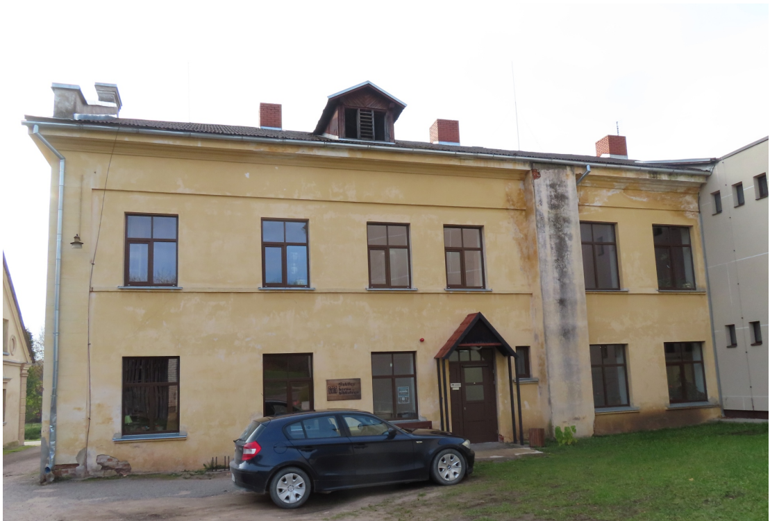
Ventspils_14_88130010045001_fasade4 Skats uz ēkas dienvidu pusi no ziemeļaustrumiem.
