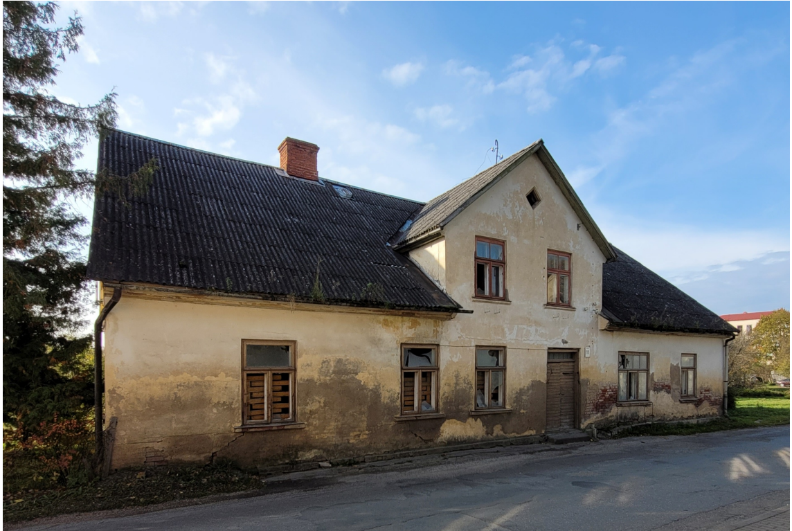
Ventspils_11_88130020019001_fasade1 Skats uz ēku no ziemeļaustrumiem.
