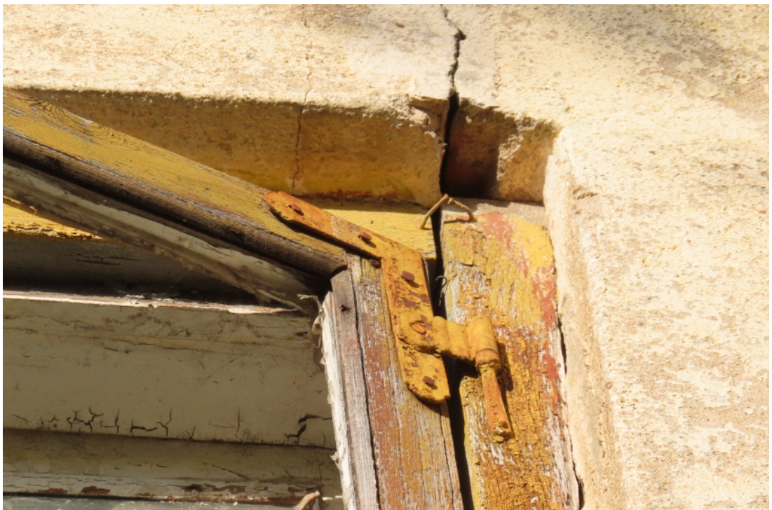
Ventspils_11_88130020019001_logs3 19.gs. beigu – 20.gs. sākuma kāšu vira (izmantota atkārtoti).
