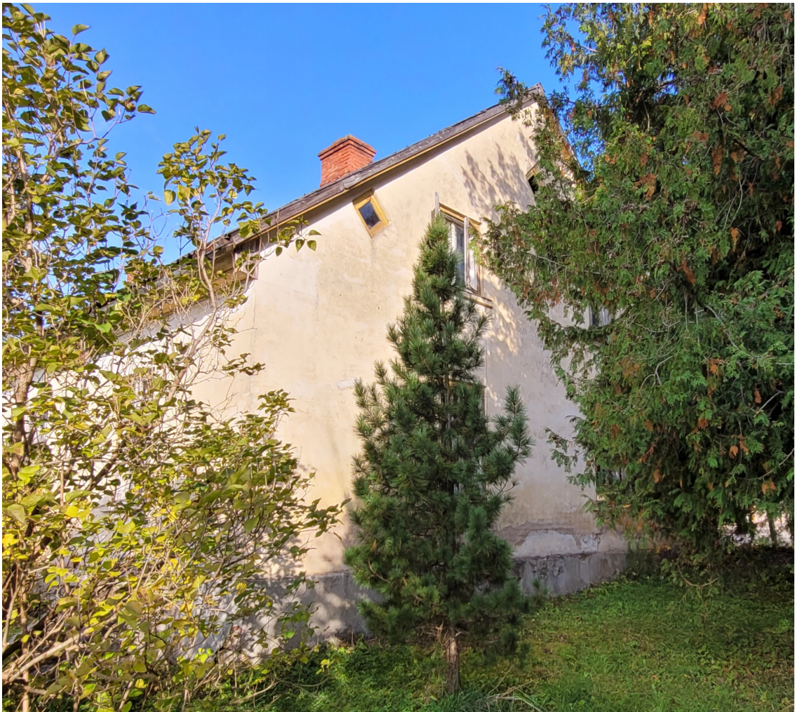
Ventspils_11_88130020019001_fasade4 Skats uz ēku no dienvidiem.
