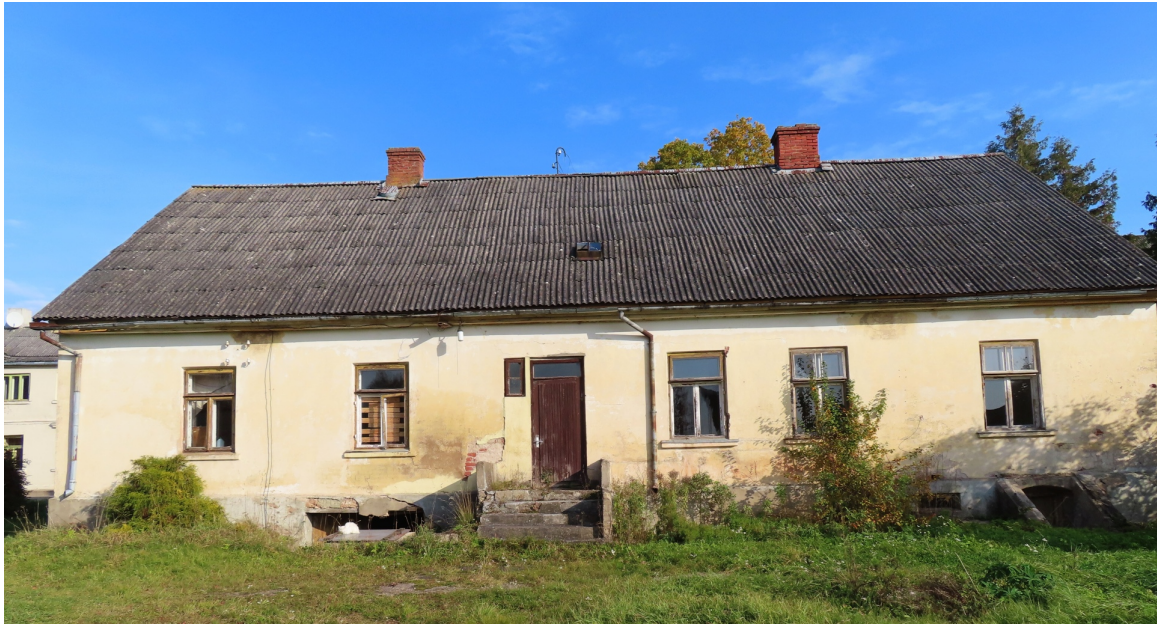
Ventspils_11_88130020019001_fasade3 Skats uz ēku no dienvidrietumiem. Fasādes vidū 1970.gados pārbūvēta sākotnējā durvju aila, kreisajā pusē sekundāra aila uz pagrabu.
