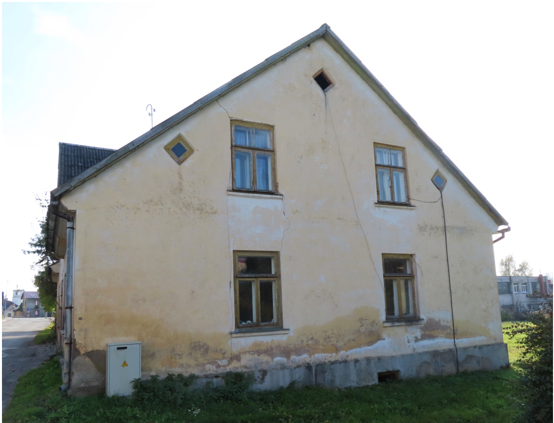
Ventspils_11_88130020019001_fasade2 Skats uz ēku no ziemeļrietumiem.
