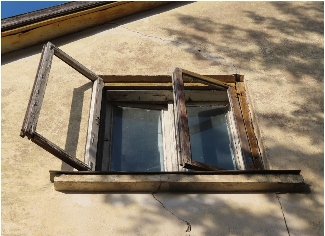
Ventspils_11_88130020019001_logs2 Jauns logs, kam atkārtoti izmantots vēsturiskais aprikojums.
