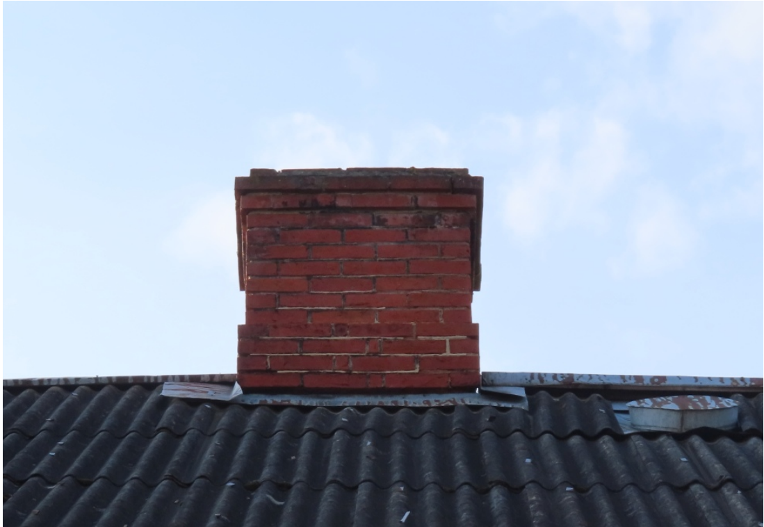
Ventspils_11_88130020019001_detala3 Sākotnējs skurstenis (ķieģeļi izšuvoti ar reljefu šuvi).
