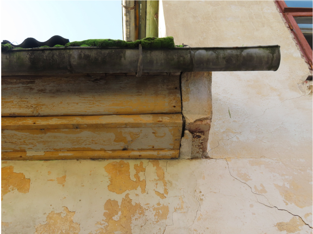
Ventspils_11_88130020019001_dzega1 Sākotnējās koka dzegas nobeiguma risinājums pie mezonīna.
