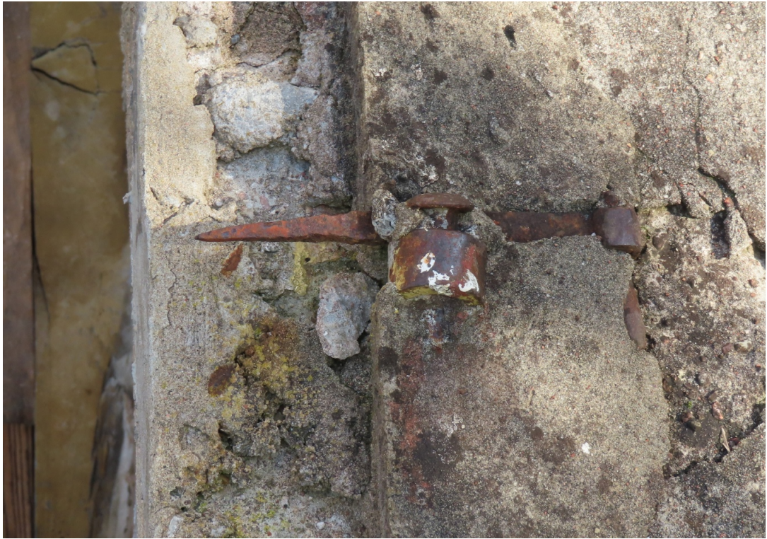
Ventspils_11_88130020019001_detala1 Vēsturiska iebetonēta pagraba noejas vērtnes vira.
