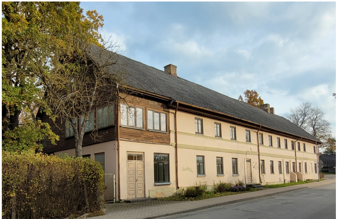
Ventspils_10_88130010048001_fasade2 Skats uz ēku no ziemeļrietumiem. Ēkas priekšējā galā sākotnēji uz pusi īsāka vienkārtīga piebūve, kas 20.gs. 30.gados pagarināta, bet 1960.gados uzbūvēts 2.stāvs.
