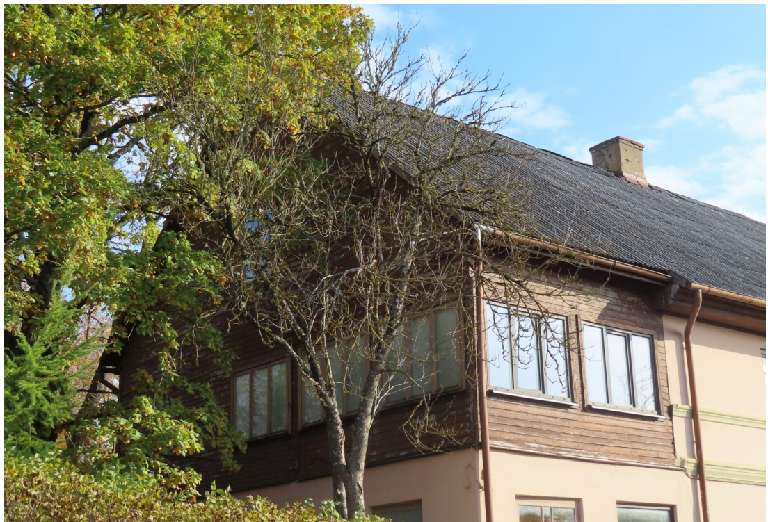
Ventspils_10_88130010048001_fragments1 Ēkas ziemeļu galā virs vēsturiskas vienstāva piebūves 1960. gados uzcelts 2.stāvs.
