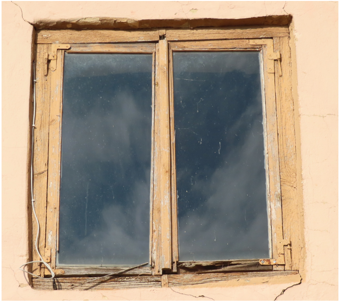
Ventspils_10_88130010048001_logs1 Sākotnēja aploda (izzāgēts statnis) ar jaunām vētrnēm un atkārtoti izmantotu 19.gs. beigu – 20.gs. sākuma aprīkojumu.
