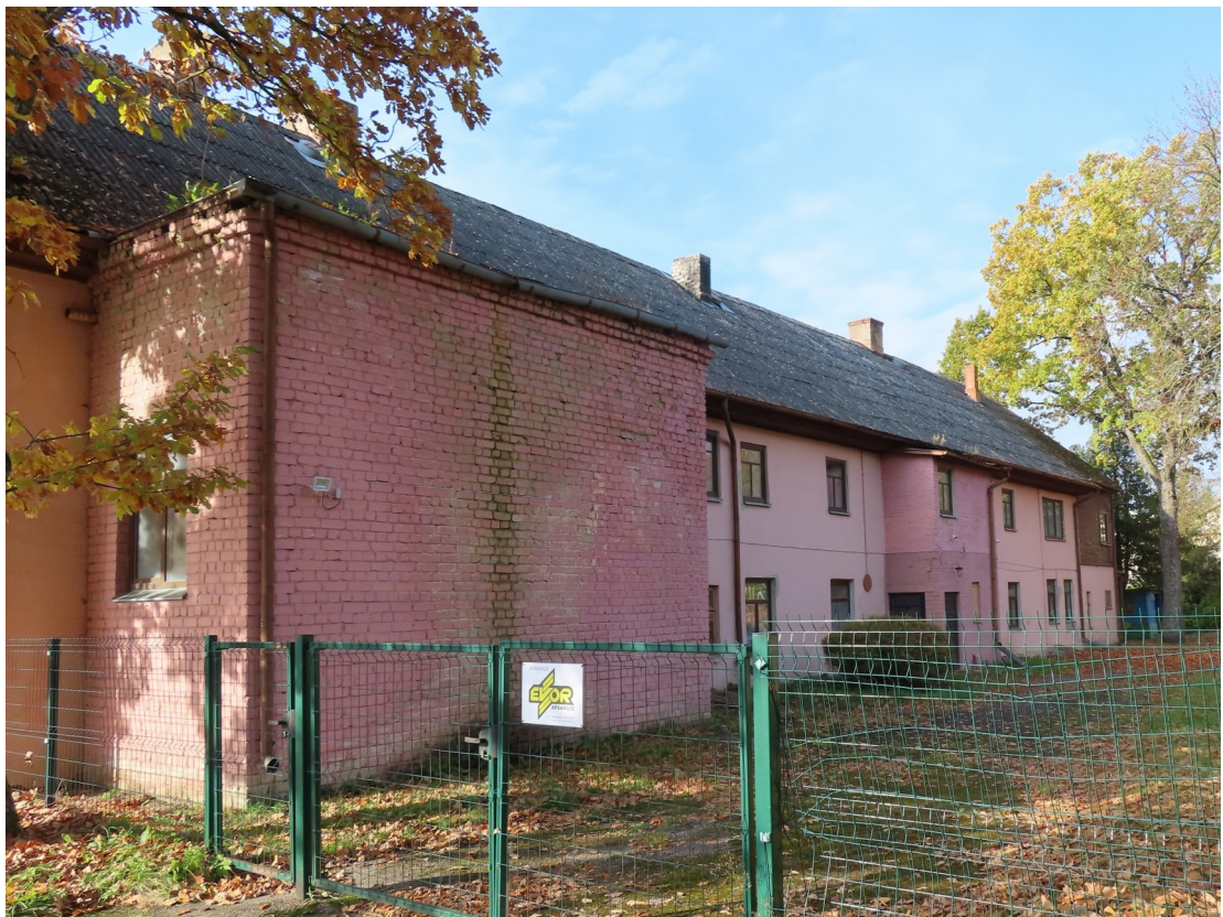
Ventspils_10_88130010048001_fasade3 Skats uz ēku no ziemeļaustrumiem. 1960. gadu piebūves.
