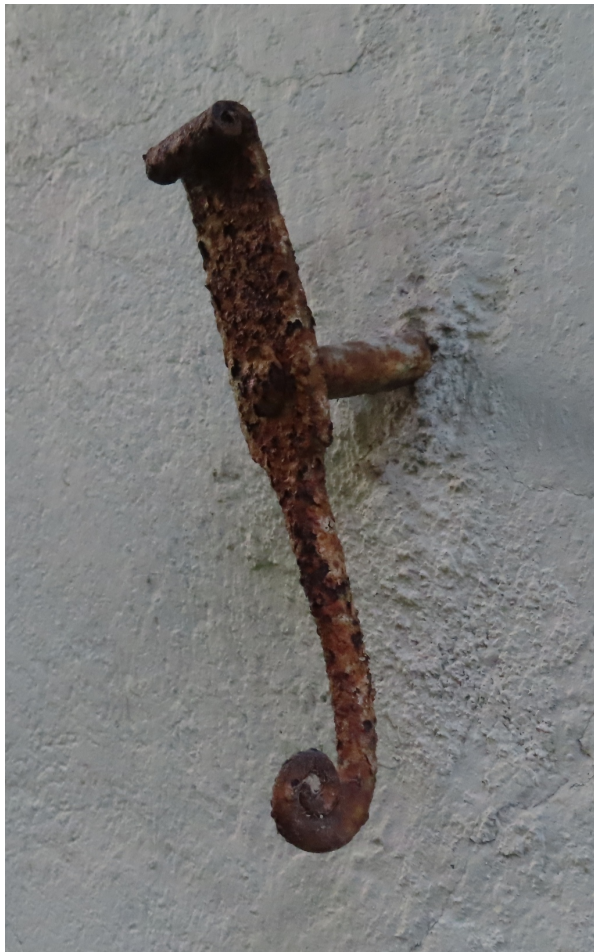
Ventspils_6_88130010049001_ slegis1 Sākotnējs slēģa atvērta stāvokļa fiksators.
