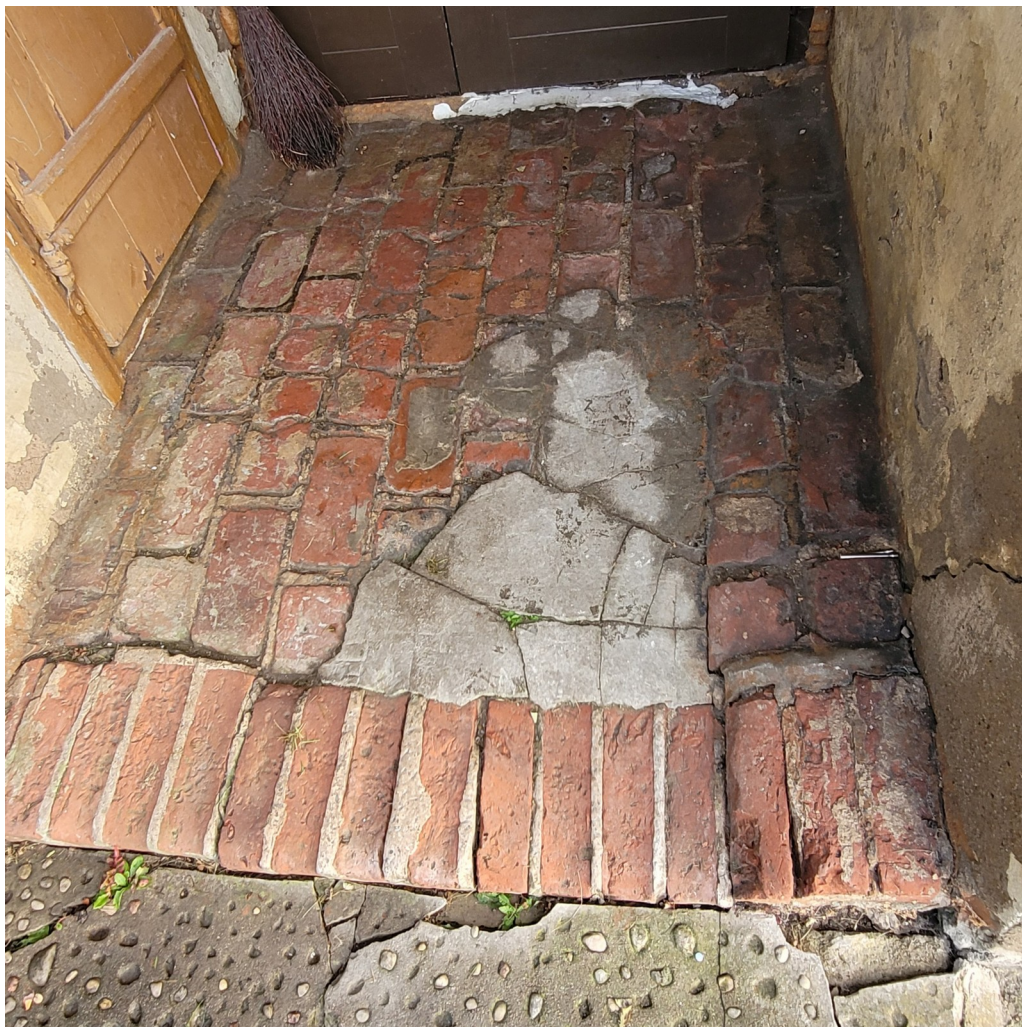
Ventspils_6_88130010049001_fragments2 Ķieģeļu klons piebūves grīdā. ~1900.g.
