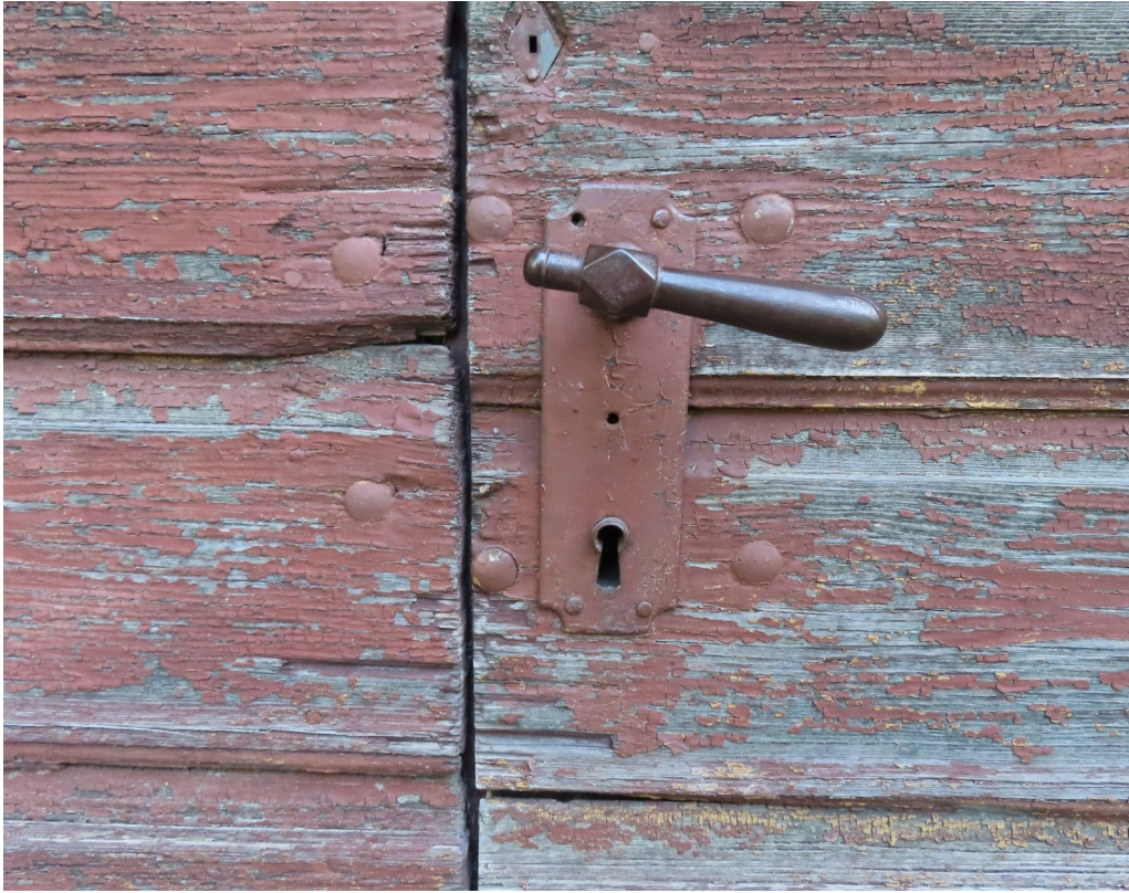
Ventspils_6_88130010049001_durvis3 Saglabājies sākotnējais rokturis un kastes slēdzenes noseGPLāksne.
