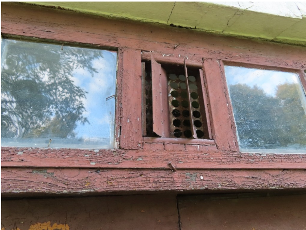
Ventspils_6_88130010049001_durvis2 Sākotnējo durvju virslogs ar sekundāru vēdināšanas konstrukciju virslogā.
