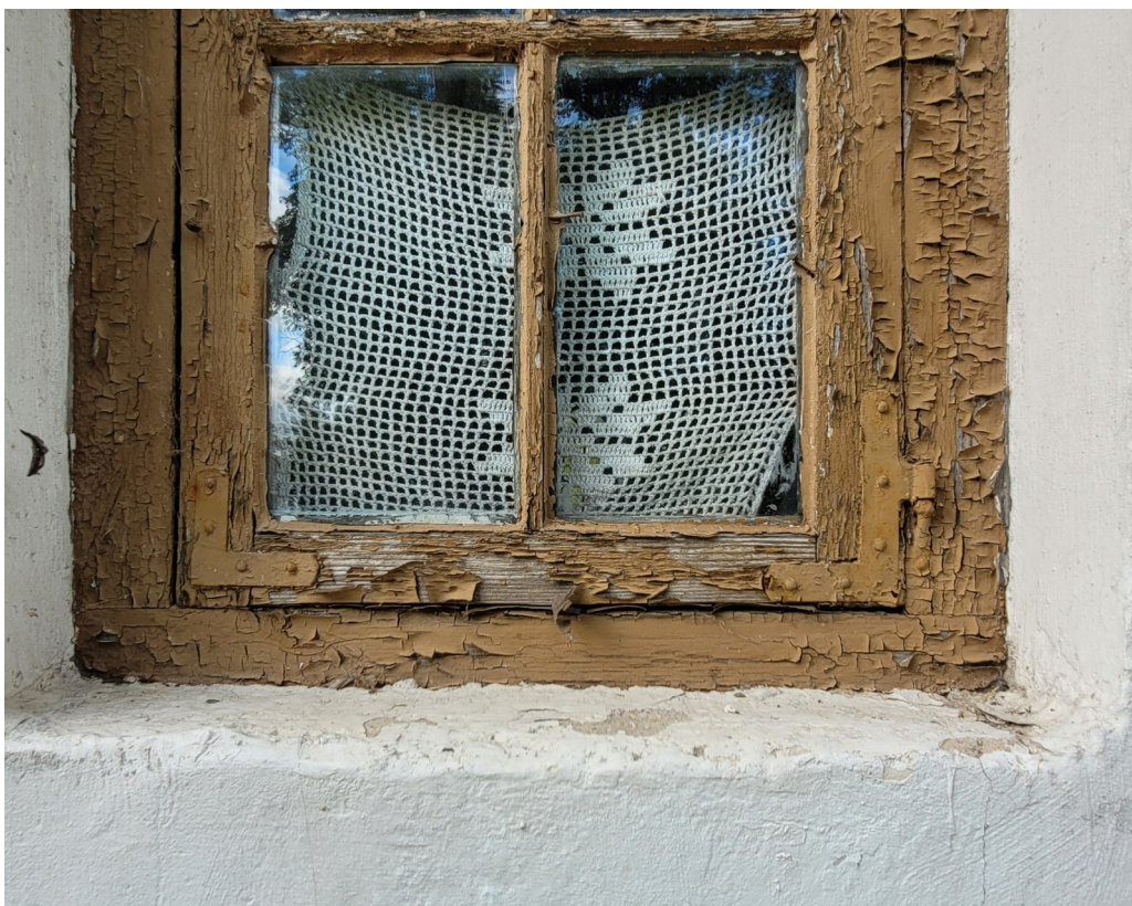
Ventspils_4_88130010096002_logs2 Sākotnējs loga aprīkojums.
