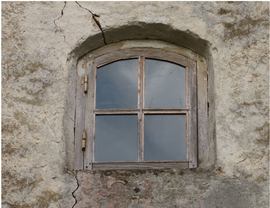
Ventspils_4_88130010096001_logs6 Vēsturisks logs torņa dienvidrietumu fasādē.
