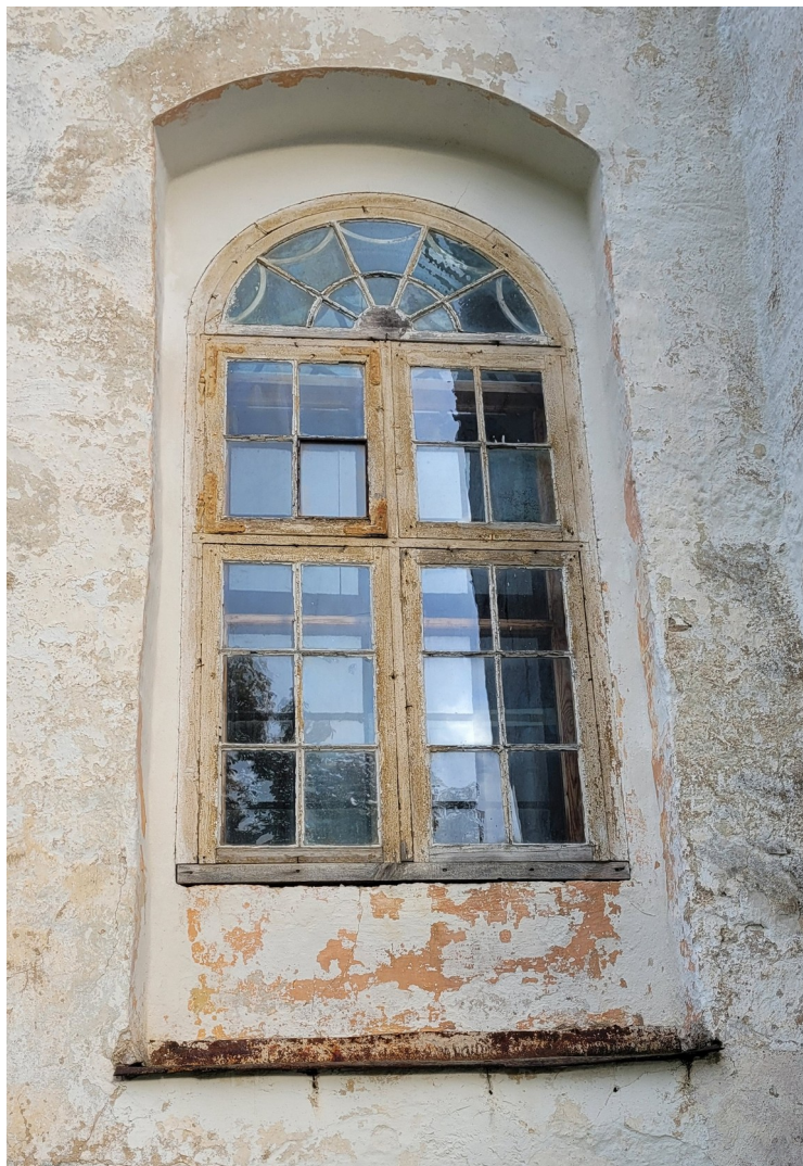
Ventspils_4_88130010096001_logs1 Baznīcas logs dienvidrietumu fasādē. 1857. gads.
