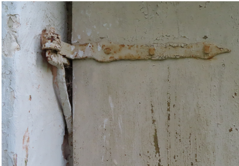
Ventspils_4_88130010096001_slegis1 Sakristejas loga slēģis (1876.g.) ar vēsturisku aprīkojumu.
