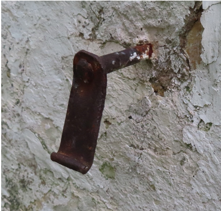
Ventspils_4_88130010096001 _slegis4 Slēga atvērta stāvokļa fiksators. 1876.gads.
