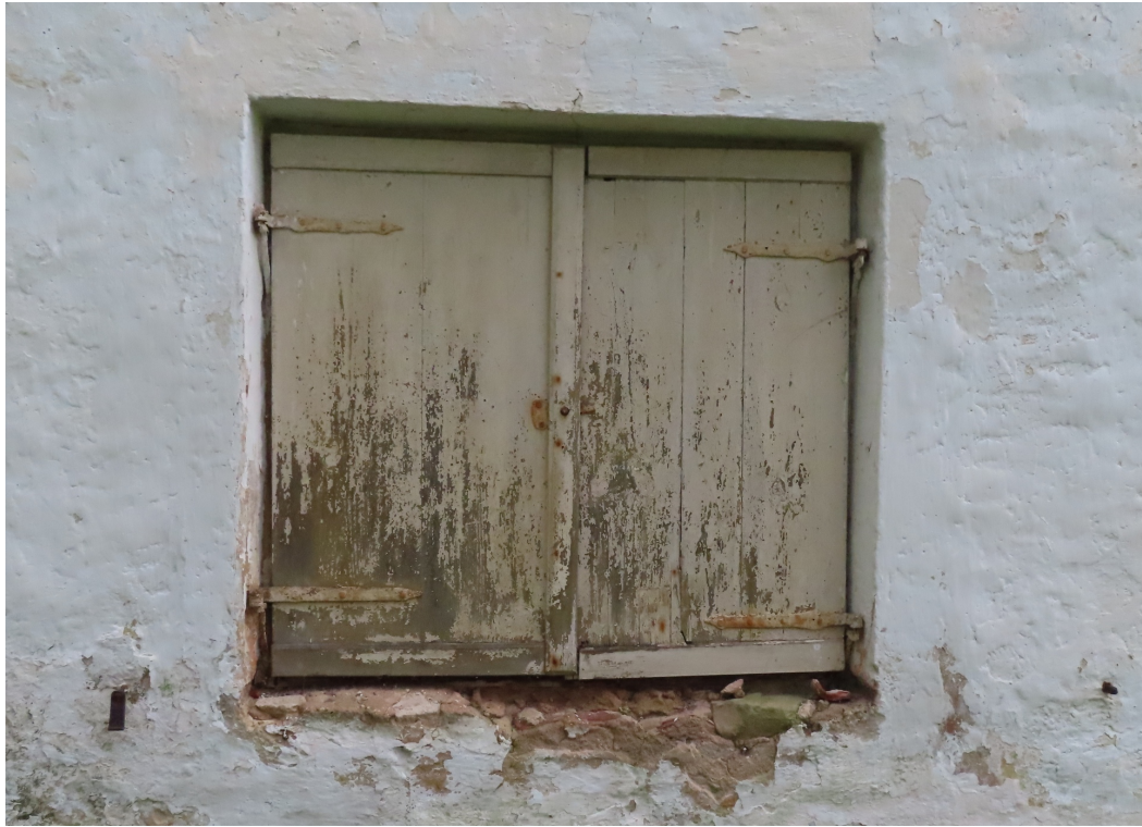
Ventspils_4_88130010096001_slegis1 Sakristejas loga slēģis (1876.g.) ar vēsturisku aprīkojumu.
