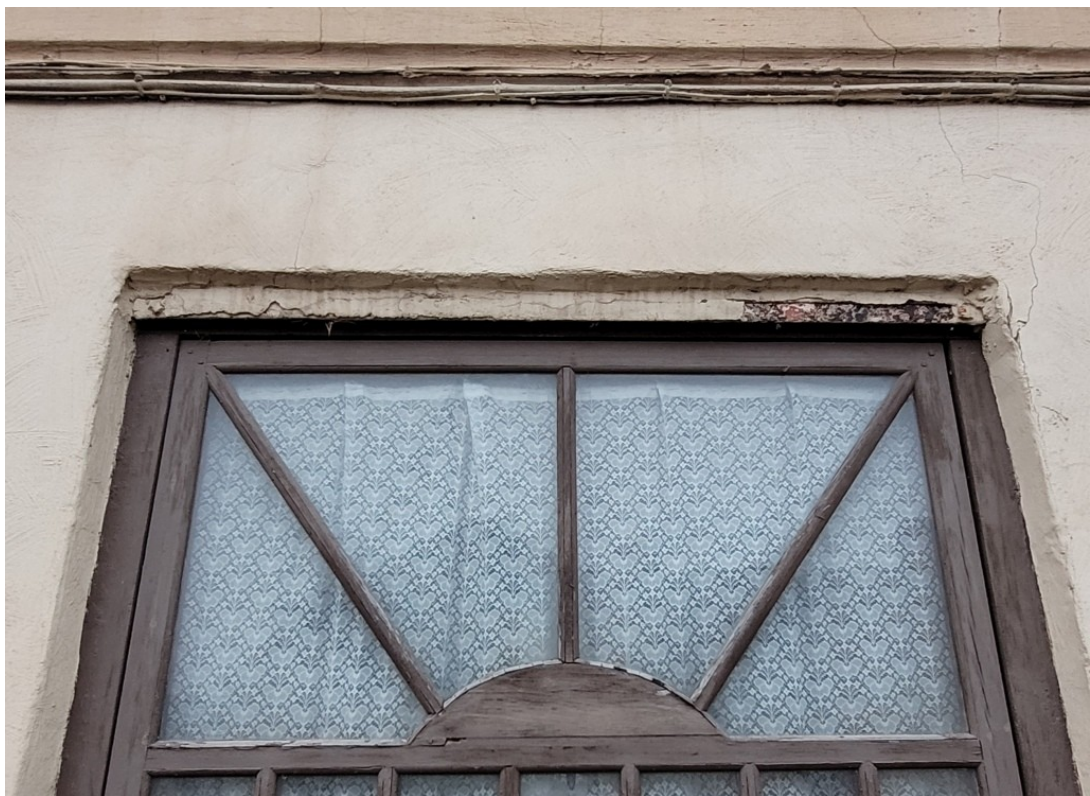
Ventspils_1_3_88130020156003_logs1 Vēsturisks rullveida žalūzijas metāla nosegs ailes augšmalā.
