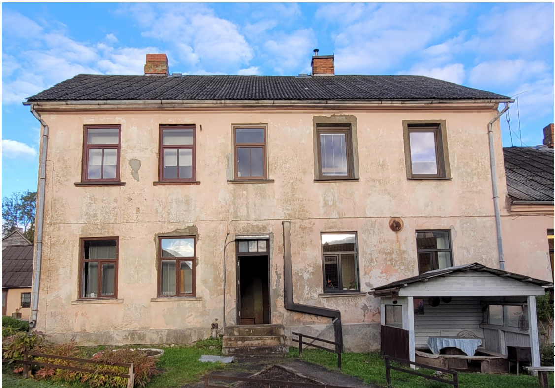
Ventspils_1_3_88130020156003_fasade4 Skats uz ēkas divstāvu apjomu no rietumiem.
