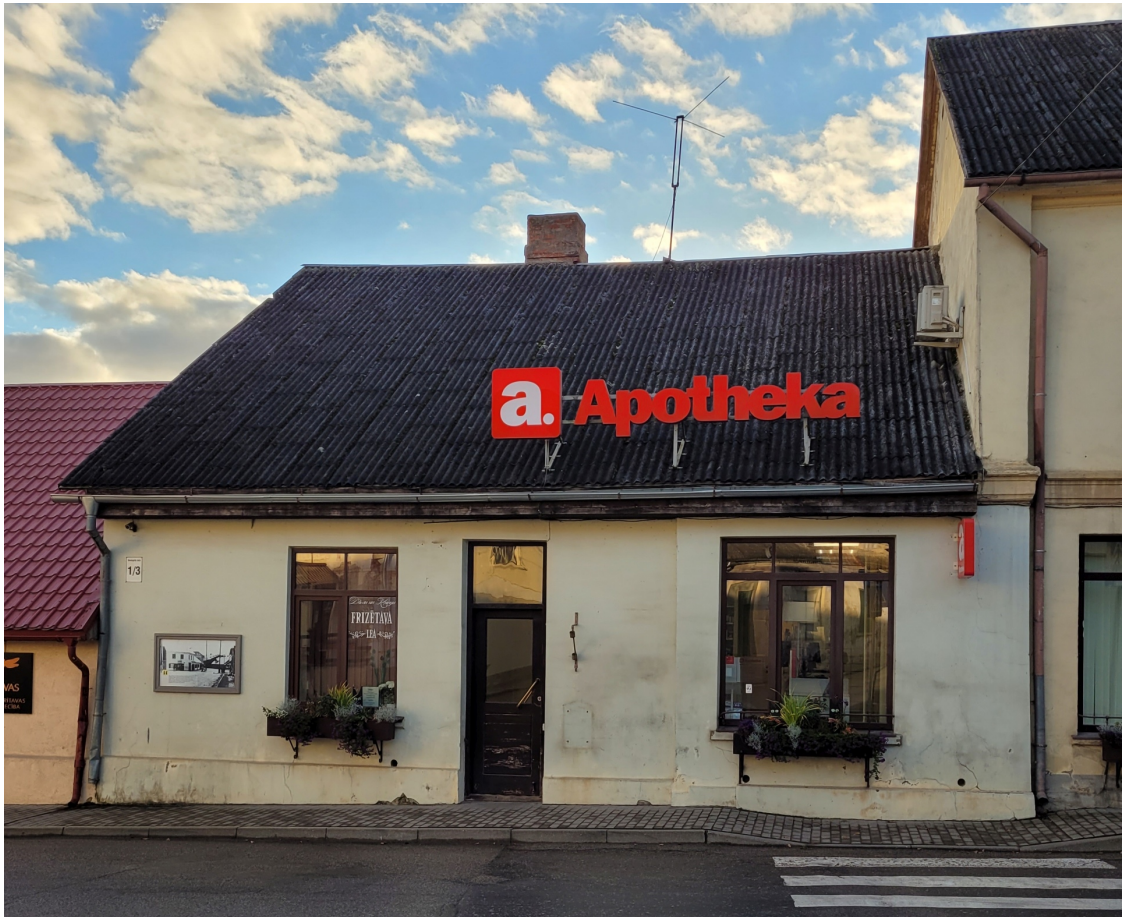
Ventspils_1_3_88130020156003_fasade5 Skats uz ēkas vienkāršā apjomu no austrumiem.
