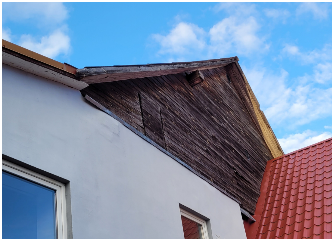
Ventspils_1_3_88130020156003_fragments1 Skats uz vienkārtējā apjoma dienvidu fasādes zelmīni ar jaunu dēļu apšuvumu (vēsturiski dēļi likti vertikāli).
