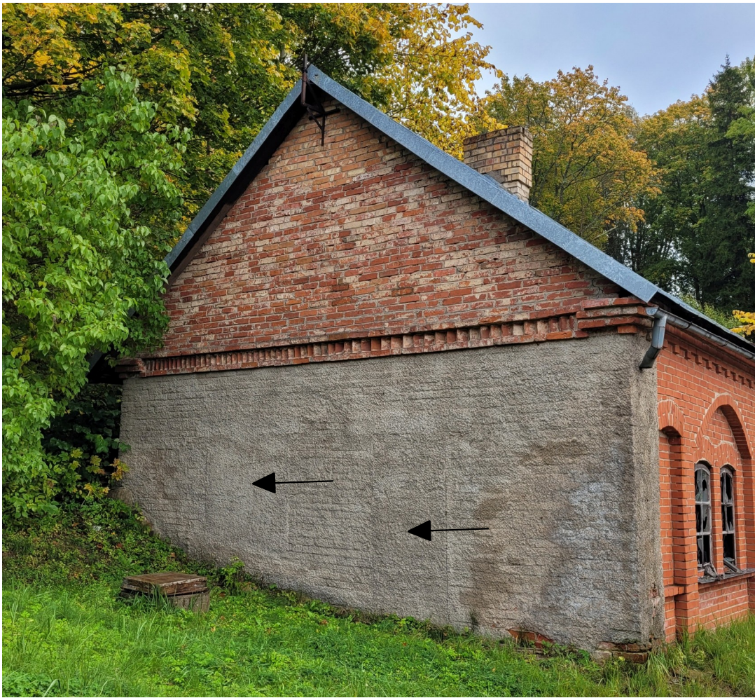
Talsu_17_88130040010001_fasade3 Skats uz ēku no ziemeļrietumiem. Fasādē redzamas sekundāri izveidotu un vēlāk izbūvētu ailu vietas.
