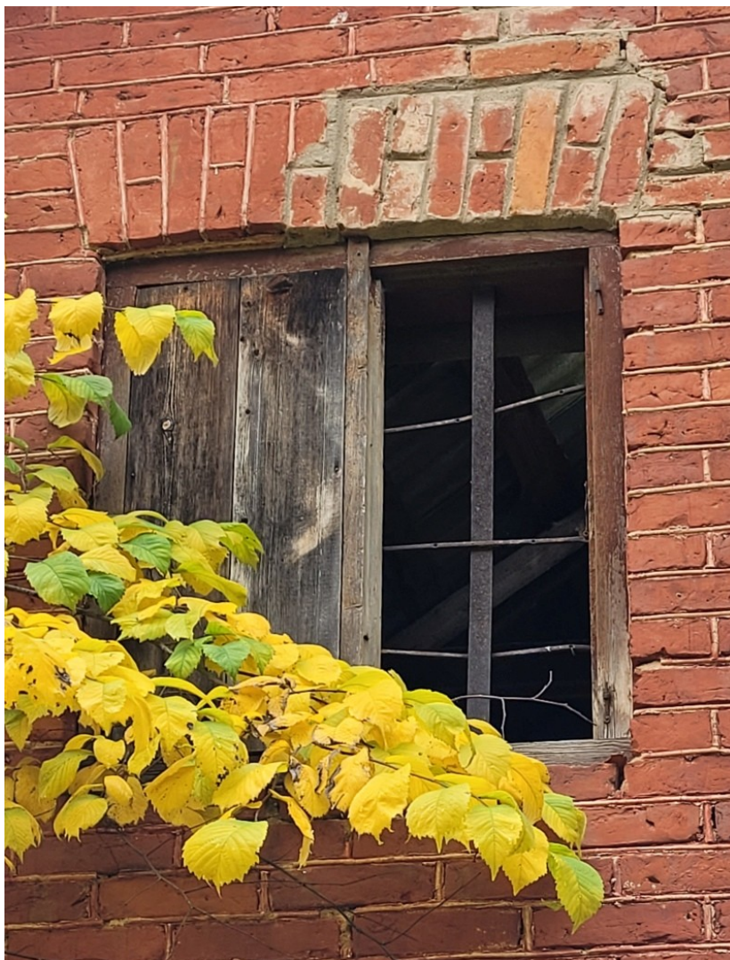
Talsu_17_88130040010001_logs1 Sākotnēja loga aploda ar viru kāšiem.
