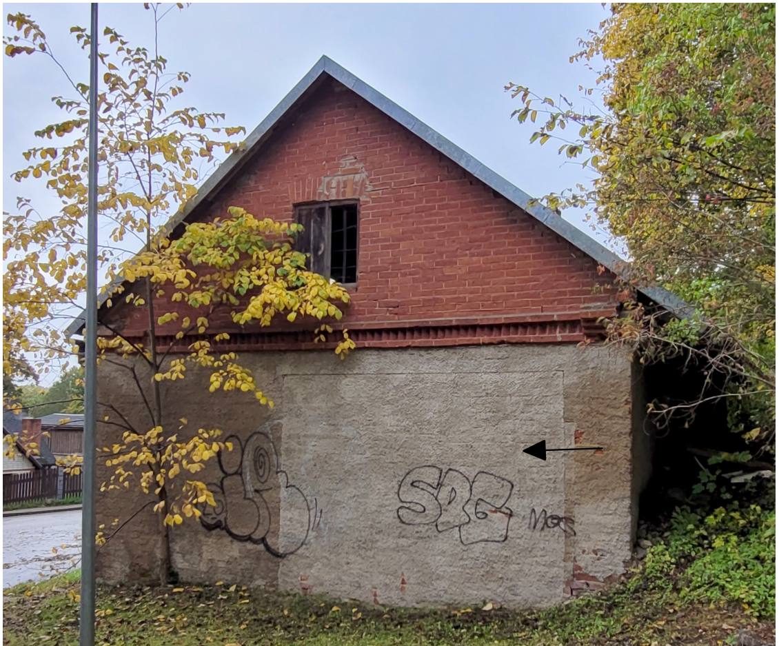
Talsu_17_88130040010001_fasade2 Skats uz ēku no dienvidaustrumiem. Fasādē redzama sekundāri izveidota un vēlāk aizbūvēta aila.
