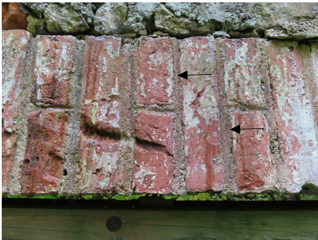
Talsu_16_88130040011002_fragments1 Durvju ailas pārsedzes ķieģeļi ar sākotnējo krāsojumu (ieskaitot šuves)
