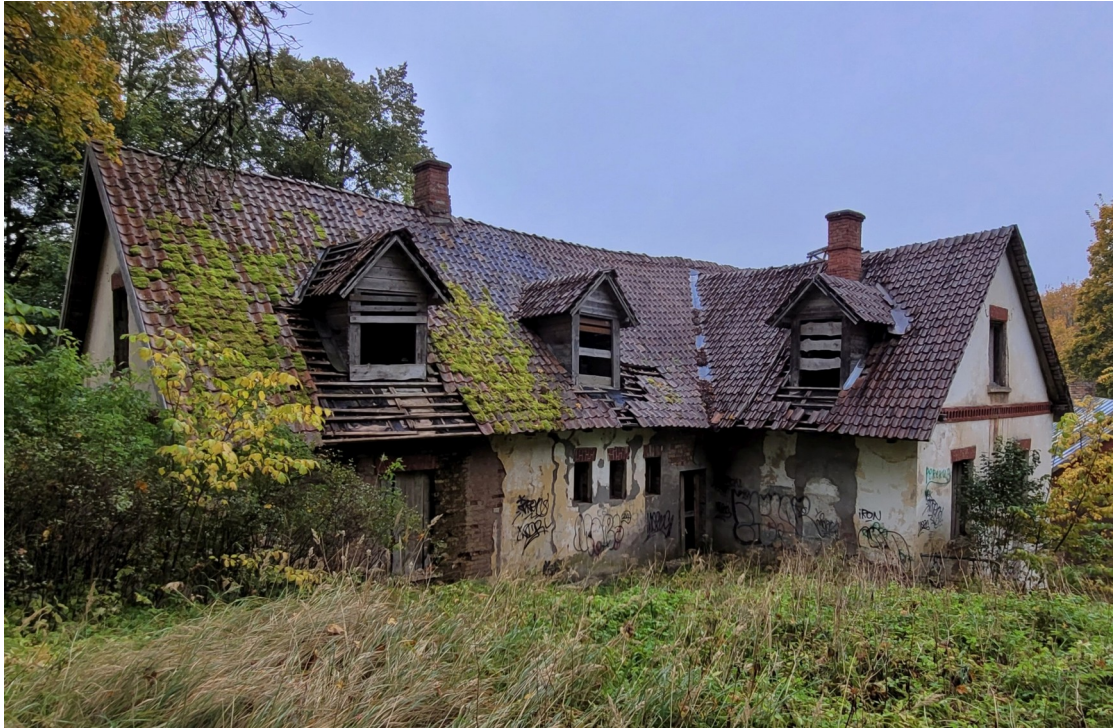
Talsu_16_88130040011001_fasade3 Skats uz ēku no dienvidaustrumiem. Jaunas jumta logu izbūves.
