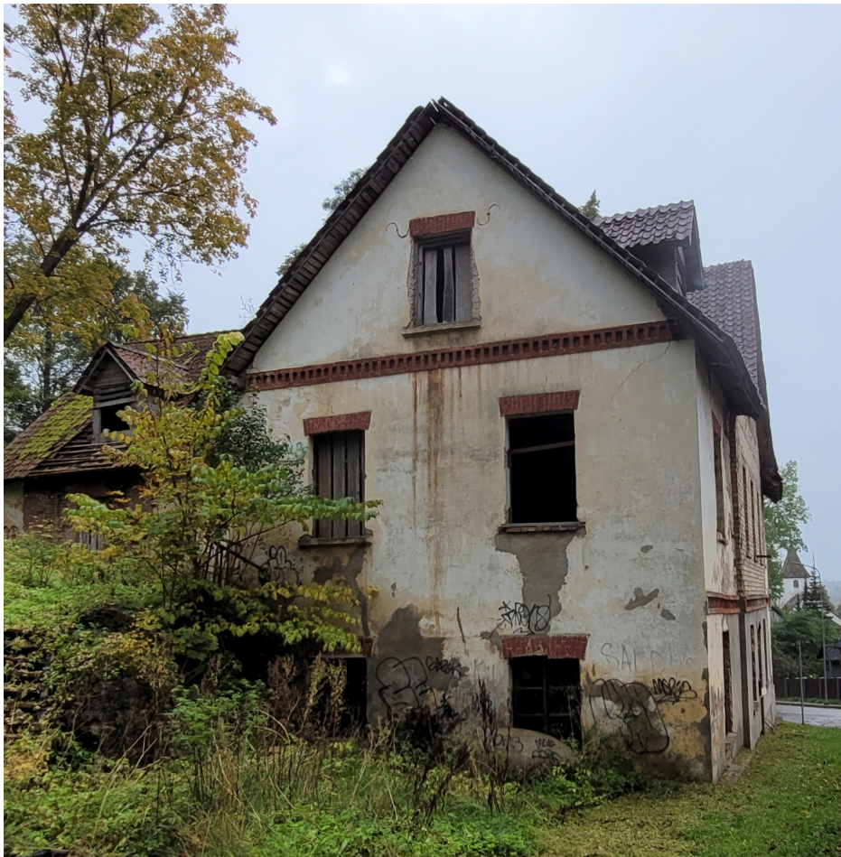
Talsu_16_88130040011001_fasade2 Skats uz ēku no austrumiem.
