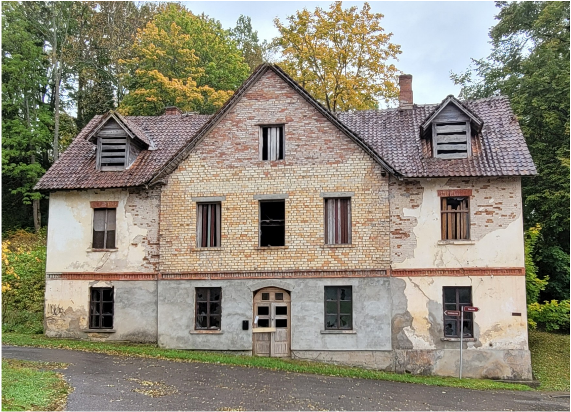
Talsu_16_88130040011001_fasade1 Skats uz ēku no ziemeļrietumiem. Jaunas jumta logu izbūves. Fasādes centrālā daļa uzmūrēta no jauna.
