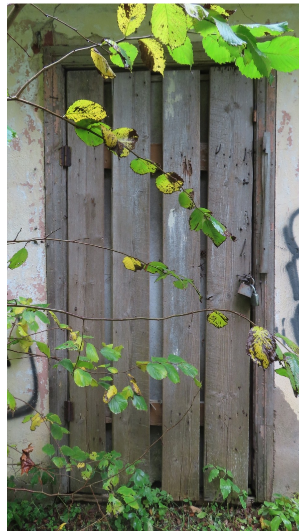
Talsu_16_88130040011001_durvis1 Saglabājusies sākotnējā durvju aploda un seglīstes.
