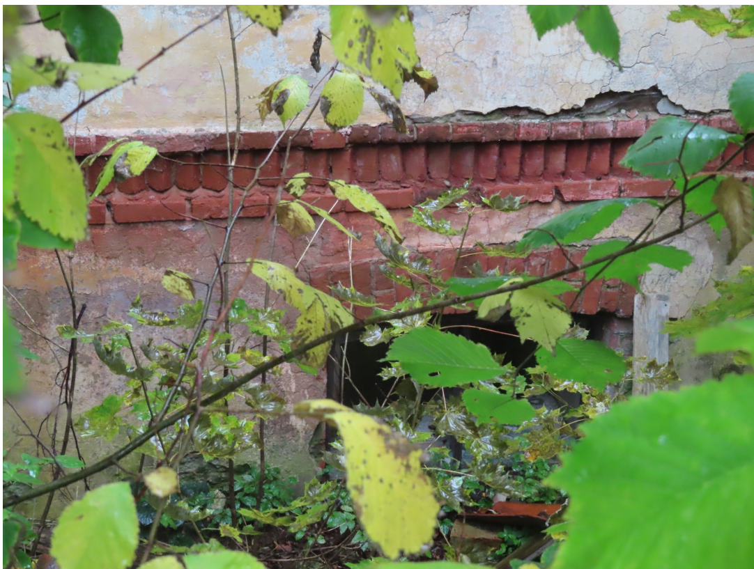
Talsu_16_88130040011001_fragments1 Fasādes cokoldaļas apdare pagalma korpusam.
