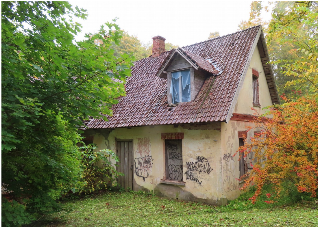
Talsu_16_88130040011001_fasade5 Skats uz pagalma korpusu no dienvidrietumiem. Jauna jumta loga izbūve.
