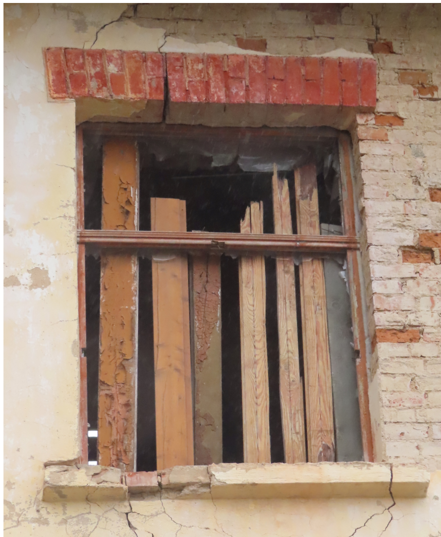
Talsu_16_88130040011001_logs1 Saglabājusies sākotnējā loga aploda.
