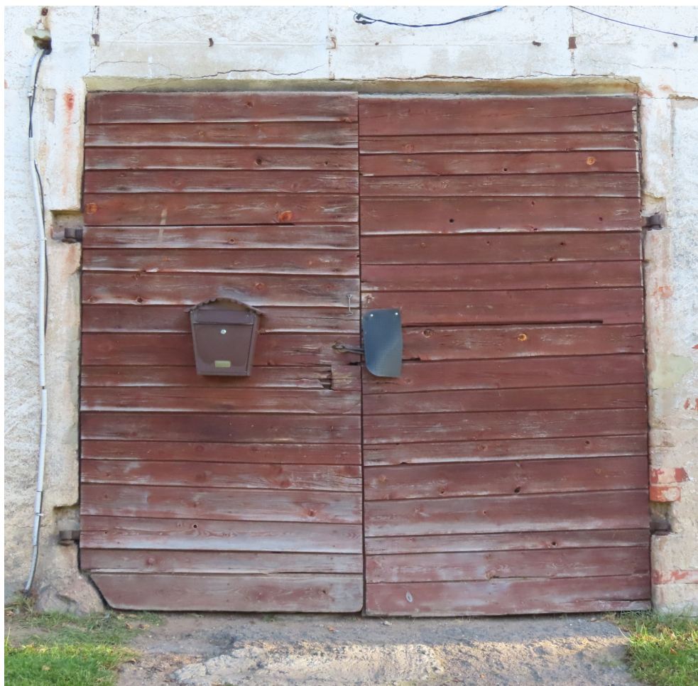
Talsu_14_88130040009001_durvis2 Vēsturiski vārti ar kāšu virām. Ārējās kārtas dēļi mainīti (bijuši vertikāli).
