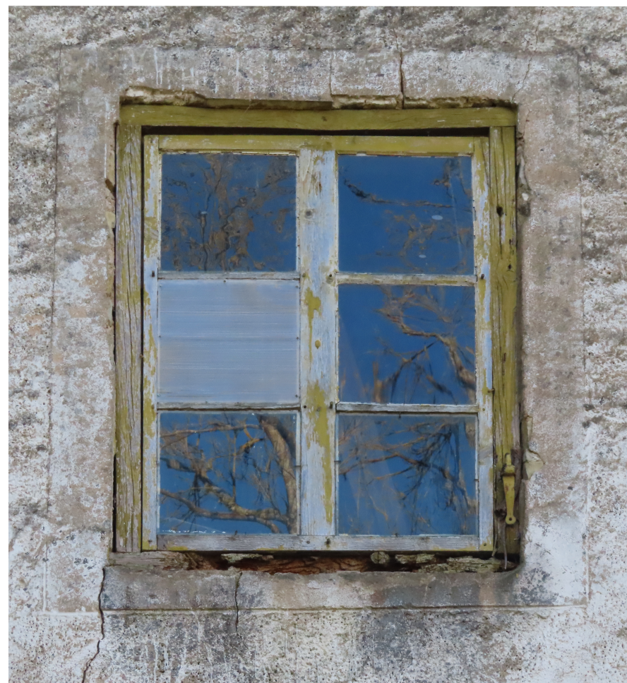
Talsu_14_88130040009001_logs1 Vēsturiski - aila ar slēģi. Saglabājies viru kāsis. Stiklota vērtne (domājams, vēsturiska) ievietota 20.gs.2.pusē.
