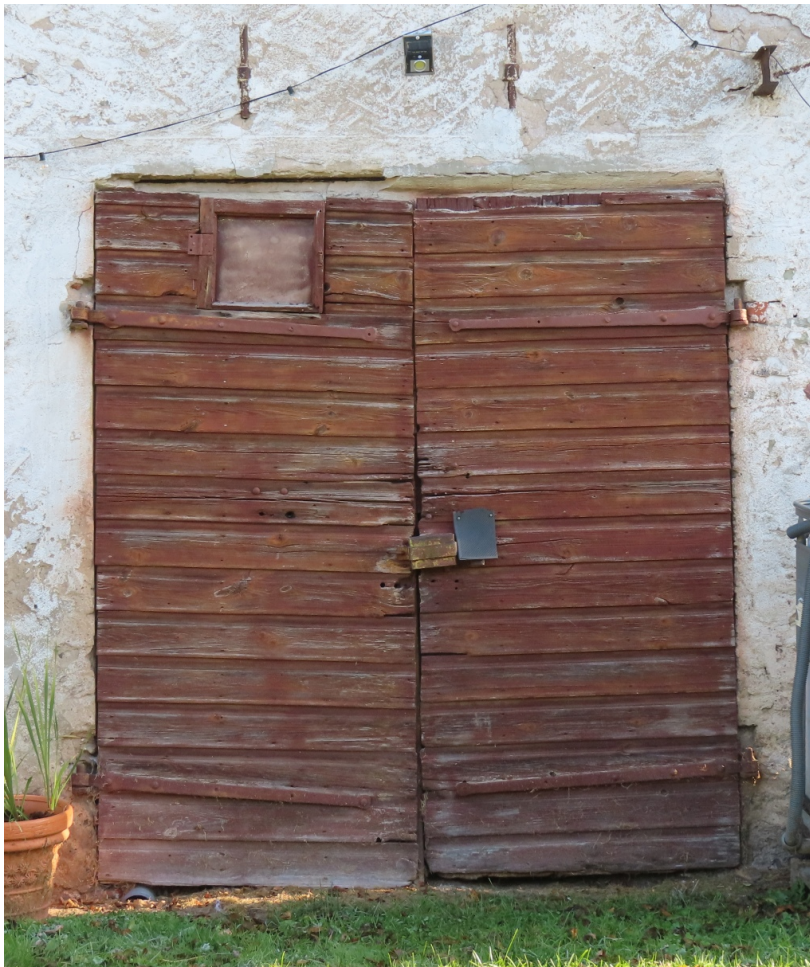
Talsu_14_88130040009 001_durvis1 Vēsturiski vārti ar kāšu virām. Lodziņš sekundārs.
