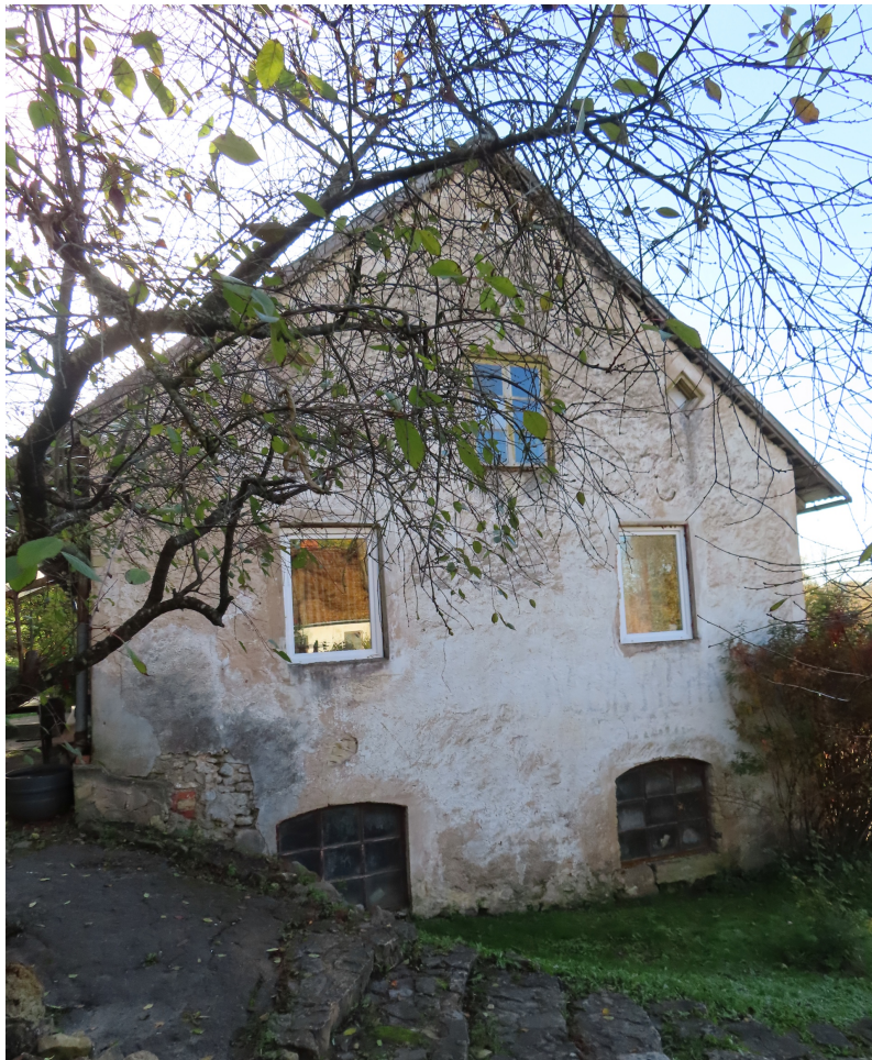
Talsu_14_88130040009001_fasade3 Skats uz ēku no ziemeļrietumiem.
