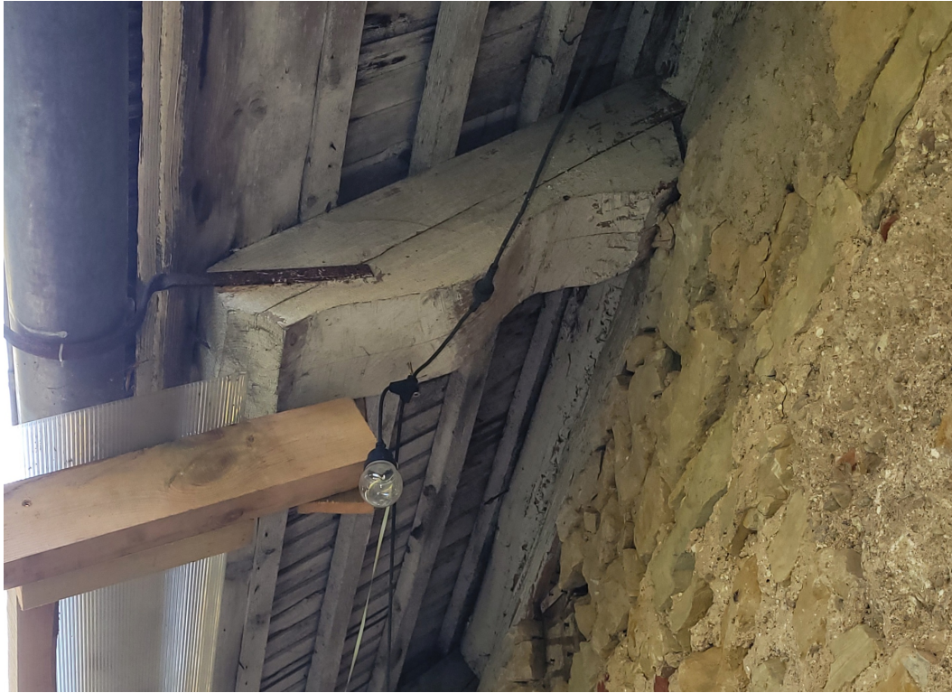
Talsu_14_88130040009001_fragments2 Sākotnēja spāre. Saglabājušās jumta skaidas zemsegumā.
