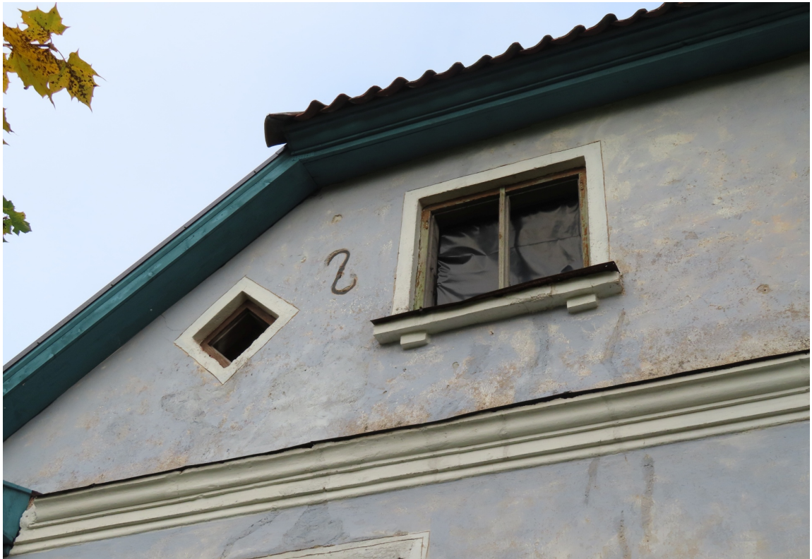
Talsu_13_88130010054001_fragments1 Skats uz ēkas dienvidrietumu fasādes zelmiņa fragmentu ar sākotnējo apdari un logu aplodām.
