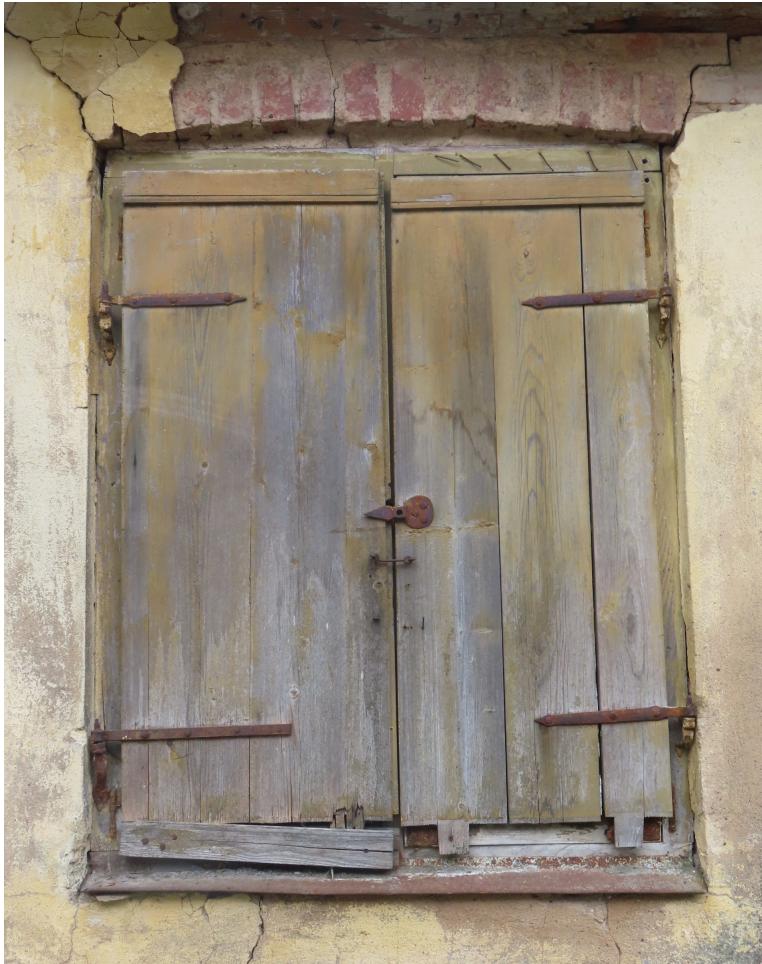
Talsu_12_88130010056001_slegis1 Sākotnējs slēģis ar aprīkojumu. 19.gs. 2.puse.
