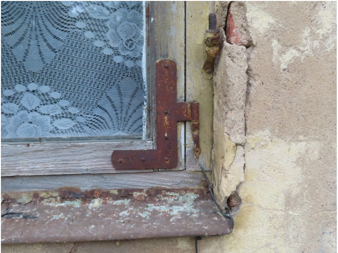
Talsu_12_88130010056001_logs5 19.gs. 2.puses loga un slēga kāšu viras.
