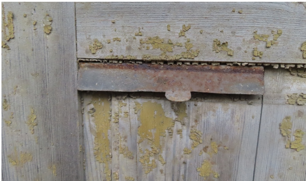
Talsu_12_88130010056001_durvis3 Vēsturisks pastkastes spraugas nosegs.
