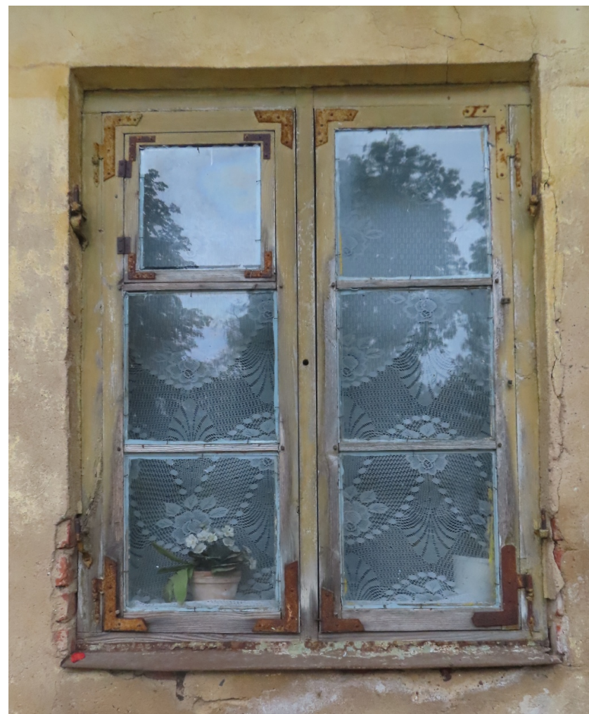
Talsu_12_88130010056001_logs2 Sākotnējs logs ar vēdlodziņu. Saglabājies aprīkojums. 19.gs. 2.puse.
