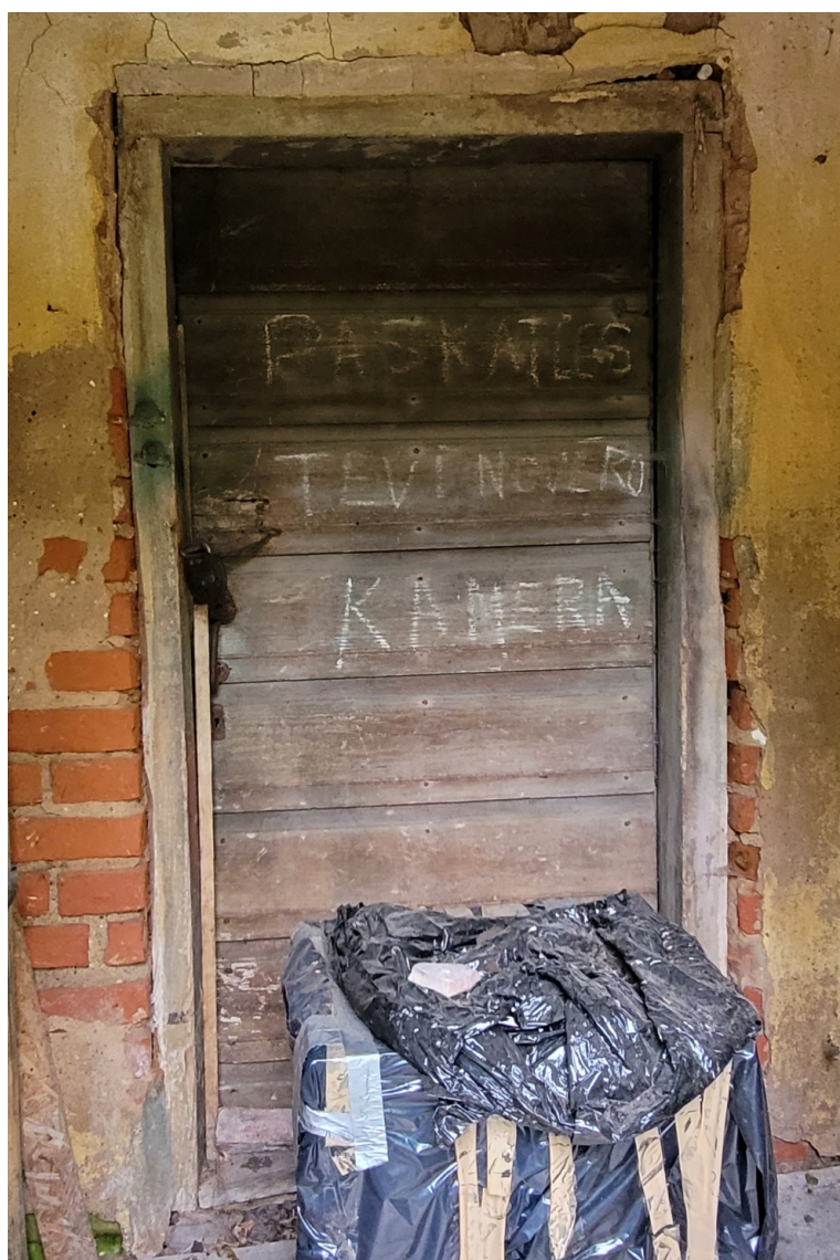
Talsu_12_88130010056001 _durvis4 Sākotnējās durvis ar aprīkojumu pagalma fasādē (šobrīd piebūvē).
