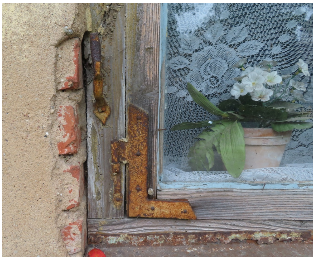
Talsu_12_88130010056001_logs4 19.gs. 2.puses loga un slēga kāšu viras.
