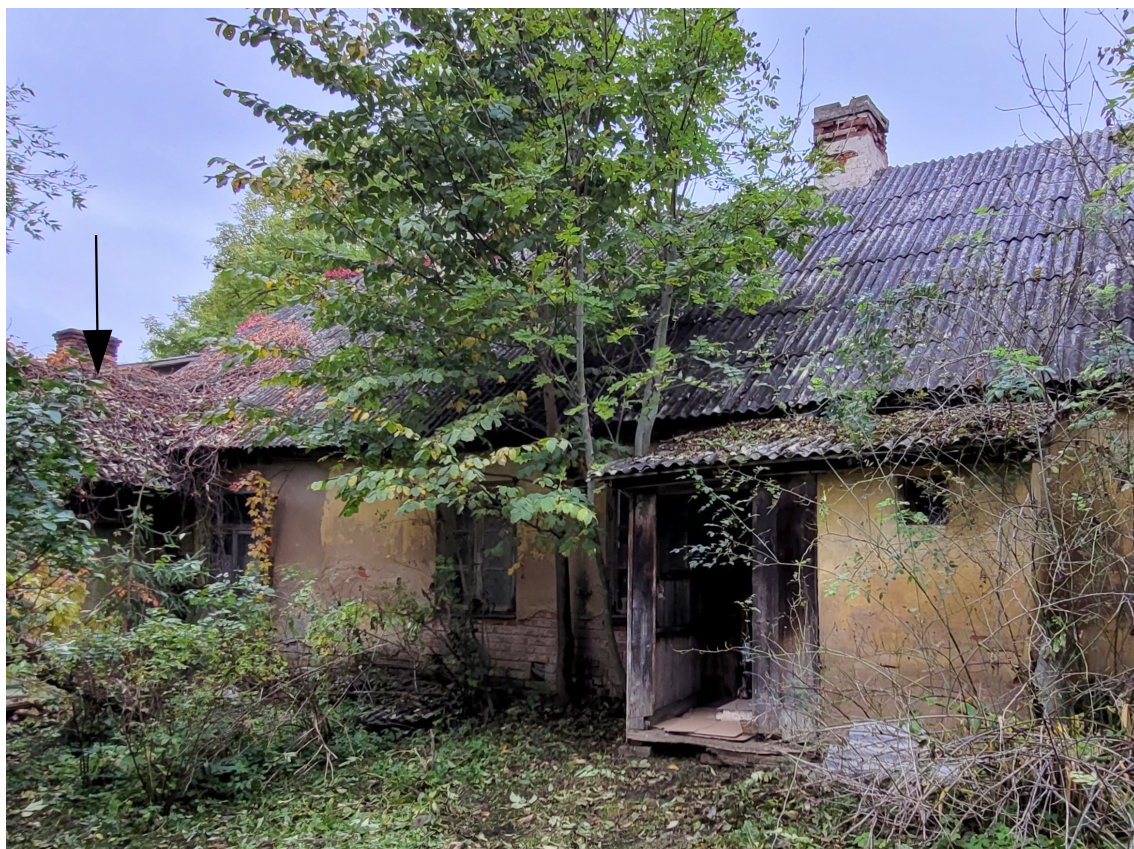
Talsu_12_88130010056001_fasade4 Skats uz ēkas ziemeļaustrumu fasādes dienvidu pusi. Ēkas dienvidu galā hronoloģiski senāks apjoms.
