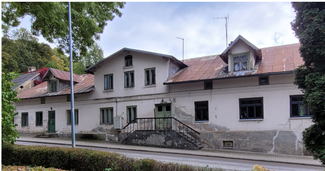
Talsu_10_88130010057001_fasade1 Skats uz ēku no ziemeļrietumiem. Ēka esošajā apjomā pārbūvēta pēc 1921.g. ugunsgrēka. Domājams, saglabājušās 19.gs. ārsienu konstrukcijas.
