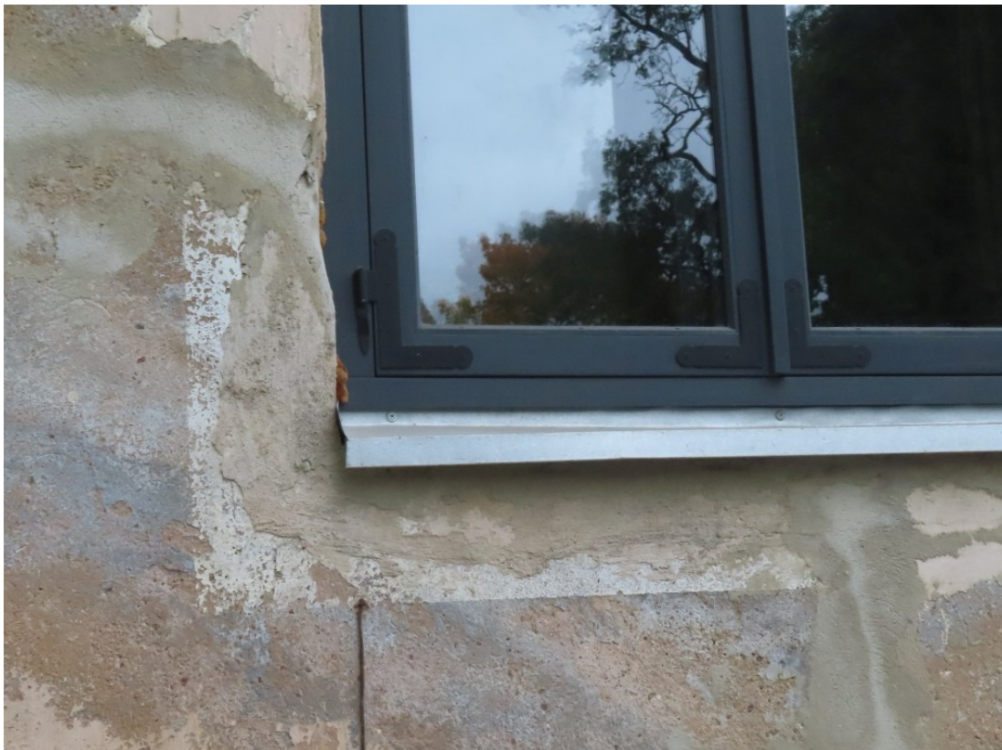
Talsu_10_88130010057001_logs5 21.gs. koka logs ar vēsturiskam atbilstošu aprīkojumu (nepieciešams krāsot loga tonī). Ap logailu saglabājies 1920.gadu fasādes krāsojums.
