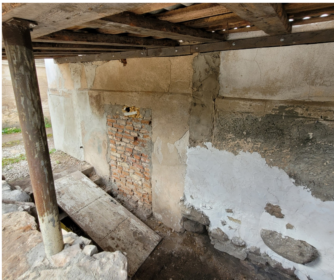
Talsu_10_88130010057001_fragments3 Dienvidaustrumu fasādes (pagalma) fragments ar aizmūrētu vēsturisko durvju ailu piebūvē (zudusi).
