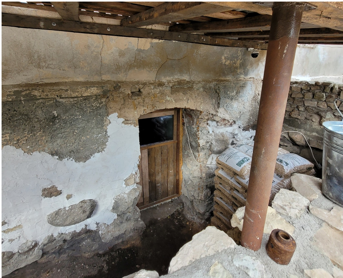
Talsu_10_88130010057001_fragments4 Dienvidausturumu fasādes fragments. Saglabājusies vēsturiski sašaurināta sākotnējā divvērtņu durvju aila.
