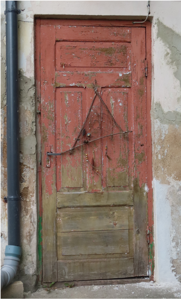
Talsu_10_88130010057001_durvis2 Ieejas durvis dienvidaustrumu (pagalma) fasādē. 1920.gadi. Rokturis un slēdzene sekundāri.
