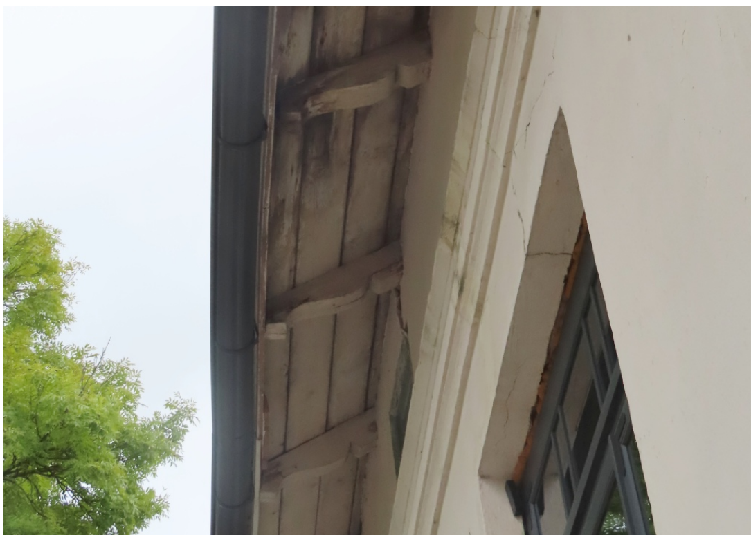
Talsu_10_88130010057001_fragments2 Skats uz jumta pārkari. Konstrukcija – 1920.gadi (pēc 1921.gada ugunsgrēka).
