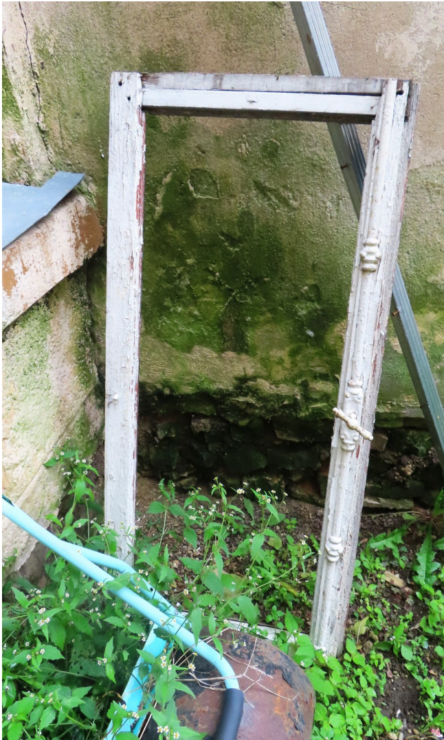
Talsu_8_88130010108002_logs3 Demontēta vēsturiskā loga vērtne. Saglabājies baskvils pilnā komplektācijā. 1920.gadi.
