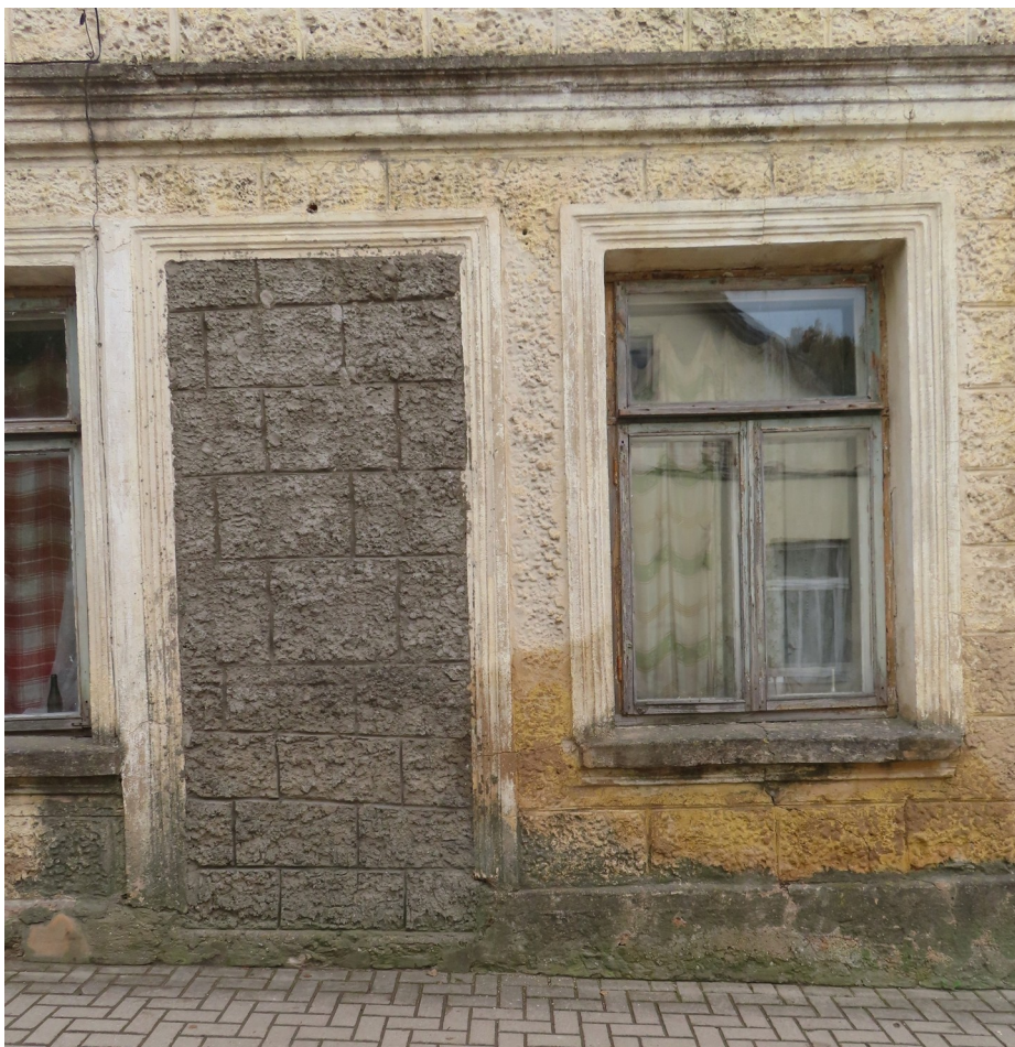
Talsu_8_88130010108002_fragments3 Ziemeļrietumu (ielas) fasādes fragments ar 20.gs. 2.pusē vai 21.gs. sākumā aizmūrētu durvju ailu.
