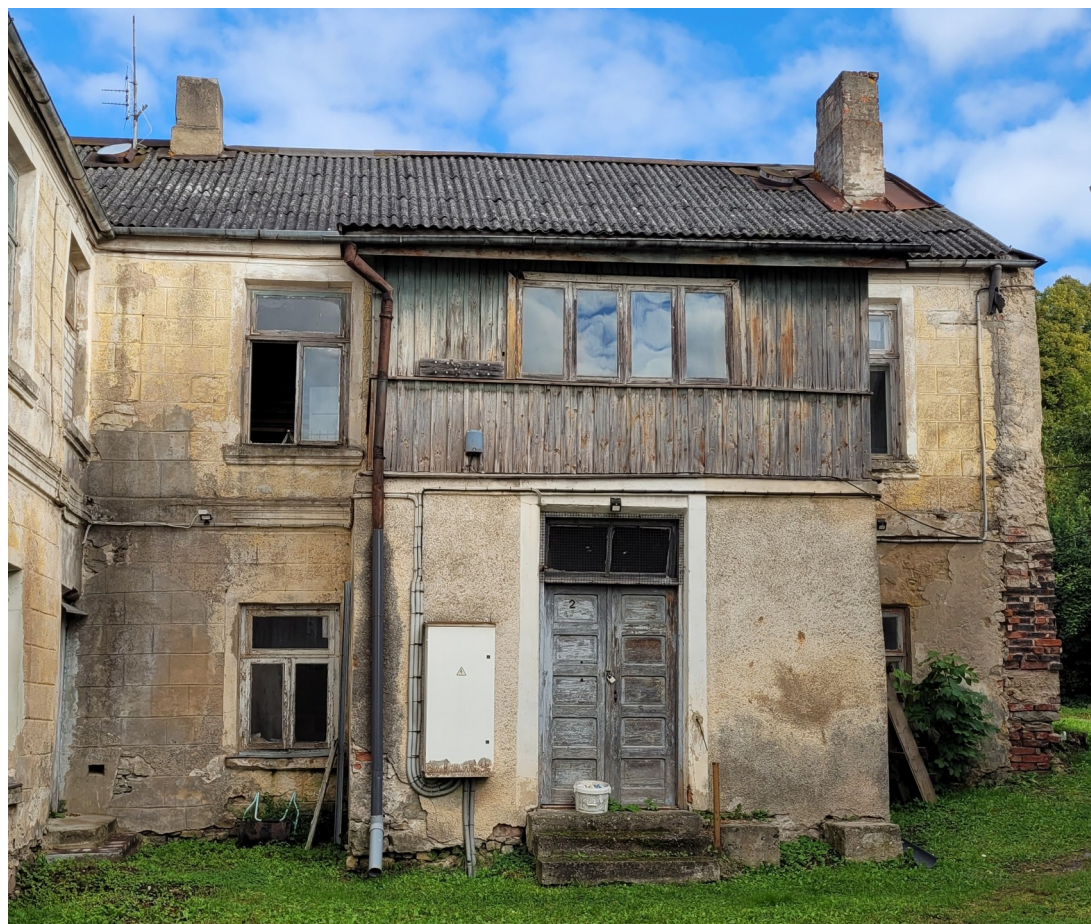
Talsu_8_88130010108002_fasade4 Skats uz ēkas pagalma korpusu no dienvidrietumiem. Vēsturiska vienstāva piebūve ar terasi, sākotnēji neapmesta. 2.stāva koka daļa – 1960.gadi.
