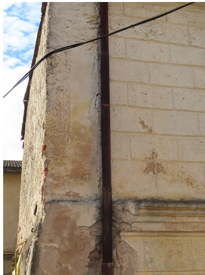
Talsu_8_88130010108002_fragments4 Pagalma korpusa ziemeļaustrumu fasādes stūris ar, domājams, sākotnējo reljefo apdari.
