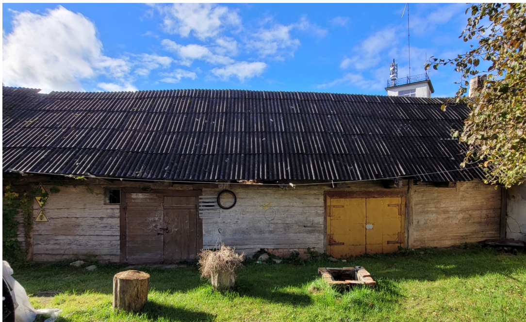
Talsu_4_88130010059004_fasade1 Skats uz ēku no ziemeļaustrumiem.
