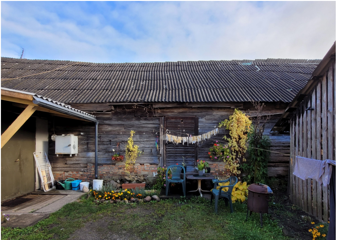
Talsu_4_88130010059004_fasade3 Skats uz ēku no dienvidrietumiem. Centrā sekundāri izveidota aila.
