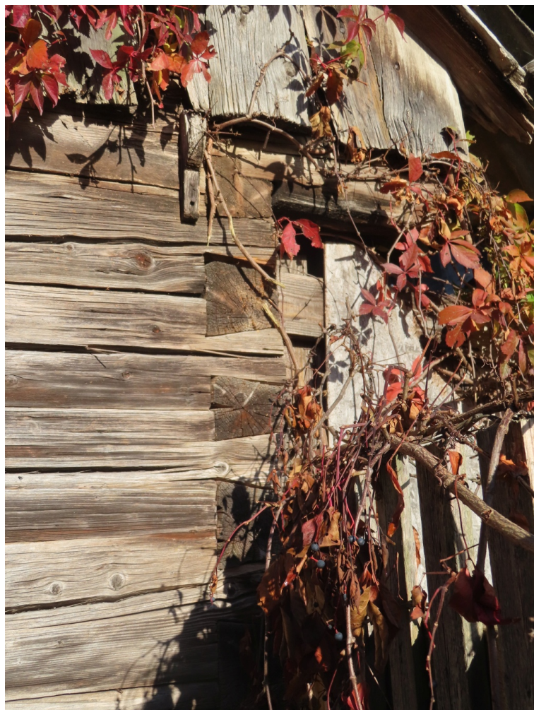
Talsu_4_88130010059004_fragments1 Skats uz ēkas stūra savienojumu gludajā paksī.
