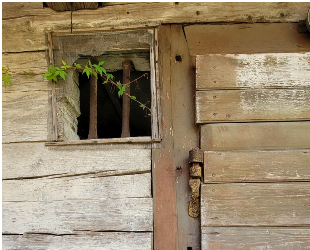
Talsu_4_88130010059004_fragments2 Vēsturisku durvju fragments ar virām un sekundāri izveidots lodziņš
