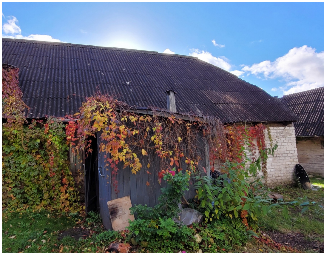
Talsu_4_88130010059002_003_fasade3 Skats uz ēku 003 no ziemeļrietumiem. Ēkai priekšā jauna atejas ēka. Silikātķieģeļu mūris – 1960. - 1970.gadi.
