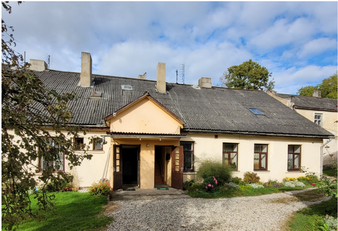
Talsu_6_88130010058001_fasade5 Skats uz ēkas dienvidaustrumu fasādes ziemeļu pusi. Ieejas piebūve – 1960.gadi.
