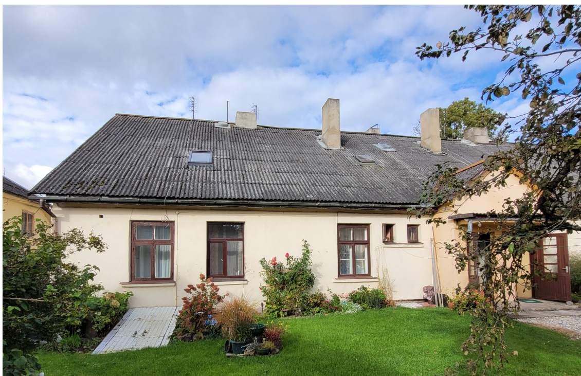
Talsu_6_88130010058001_fasade6 Skats uz ēkas dienvidaustrumu fasādes dienvidu pusi.
