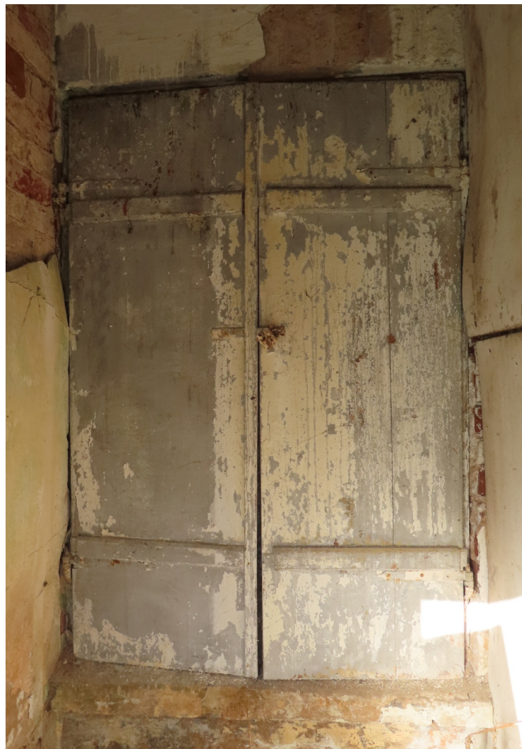
Talsu_4_88130010059001_slegis1 Sākotnēji loga slēgi ar aprīkojumu.
