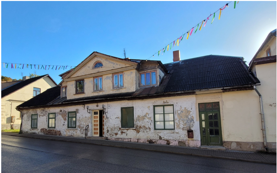
Talsu_4_88130010059001_fasade1 Skats uz ēku no ziemeļrietumiem.
