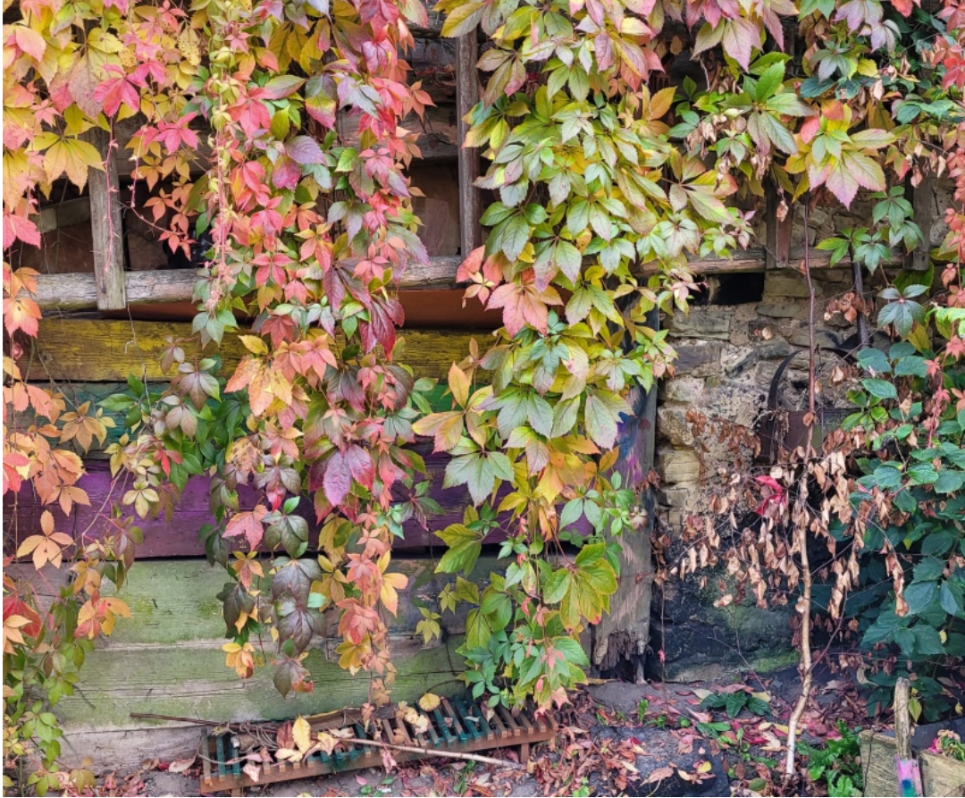
Talsu_4_88130010059_bez_kadastra_fragments2 Dienvidrietumu fasādes fragments. Mūra nesošā konstrukcija ar dēļu aizpildījumu.
