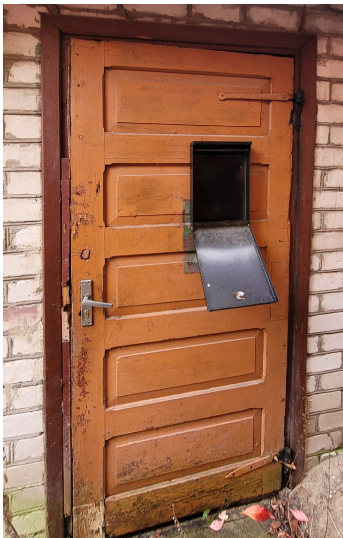
Talsu_1_7A_88130010052001_ durvis4 1960., 70.gadu durvju vērtne ar atkārtoti izmantotām vēsturiskām virām.
