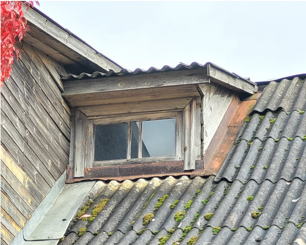
Talsu_1_7_88130010053002_logs1 Vēsturiska loga vērtne atkārtoti izmantota 1960.gadu jumta izbūvē.
