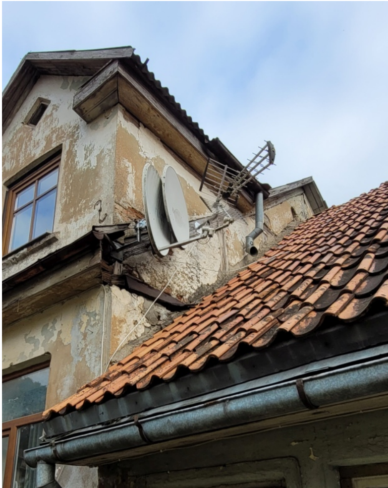
Talsu_1_7_88130010053002 _fragments1 Skats uz ēkas dienvidrietumu fasādes pildrežģa konstrukcijas zelmini. Mezonīns hronoloģiski jaunāks.
