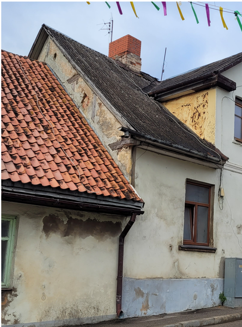
Talsu_1_7_88130010053002 _fasade3 Skats uz ēkas dienvidrietumu fasādi no dienvidiem.
