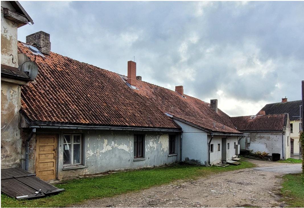
Talsu_1_7_88130010053001_fasade11 Skats uz ēku no ziemeļiem.
