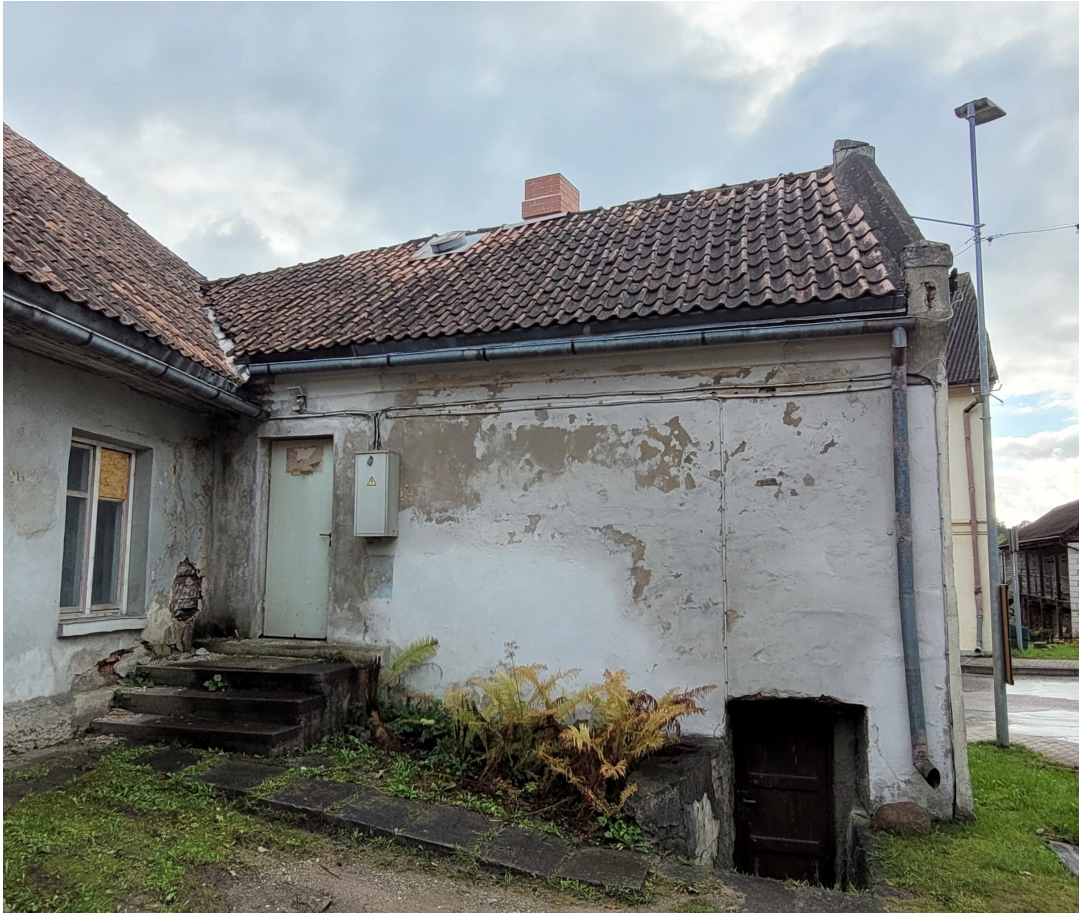
Talsu_1_7_88130010053001_fasade7 Skats piebūves pagalma fasādi no ziemeļaustrumiem.
