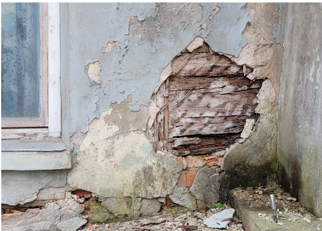
Talsu_1_7_88130010053001_fragments2 Pamatapjoma ziemeļrietumu fasādes fragments ar aizbūvētu ailu (pirms piebūves).
