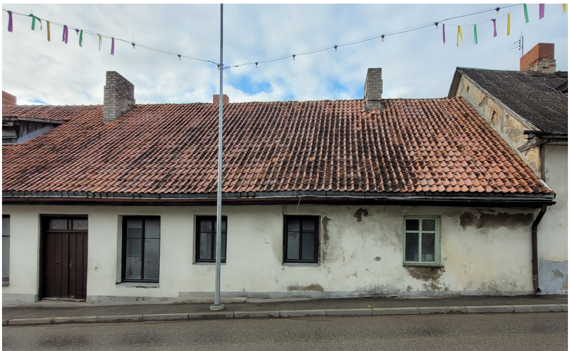
Talsu_1_7_88130010053001_fasade2 Dienvidaustrumu fasādes ziemeļu gals.
