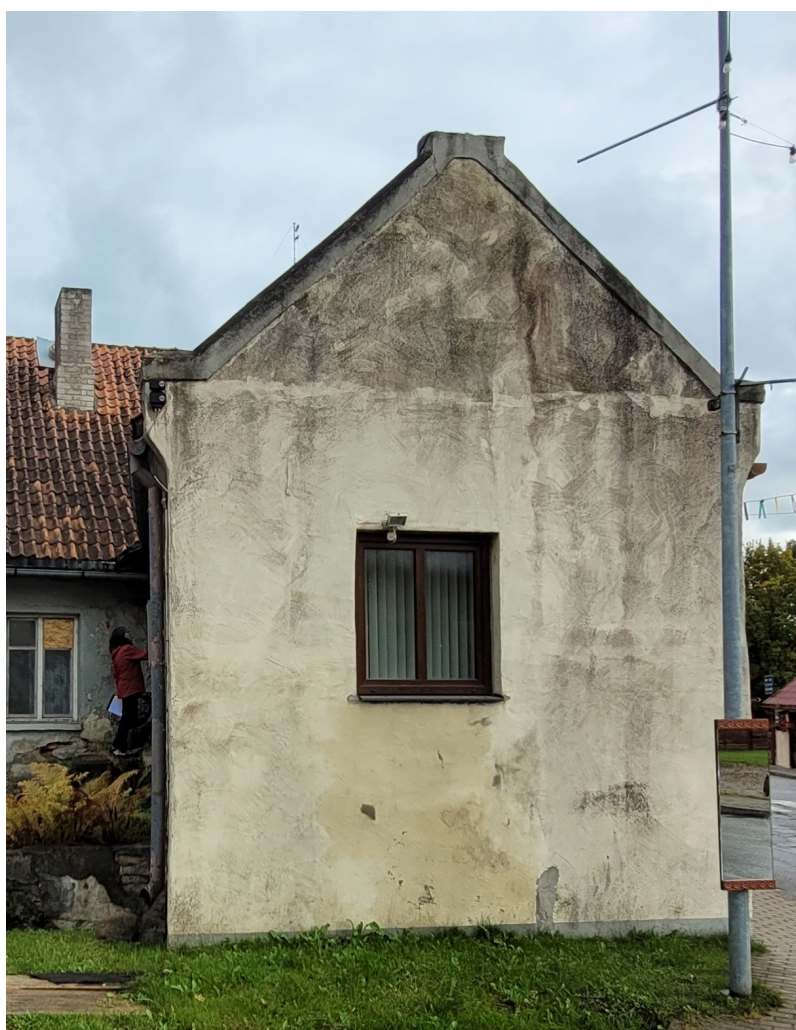
Talsu_1_7_88130010053001_fasade6 Skats uz piebūves gala fasādi no ziemeļrietumiem.
