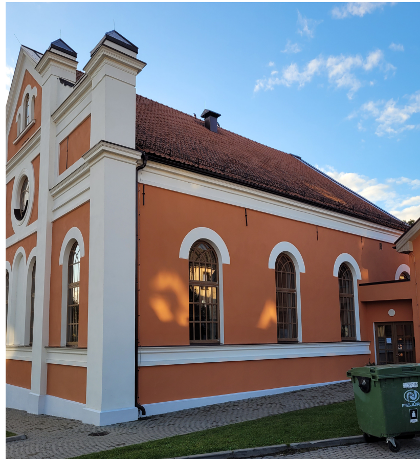
Strautu_4_88130020131001_fasade4 Skats uz ēku no austrumiem.
