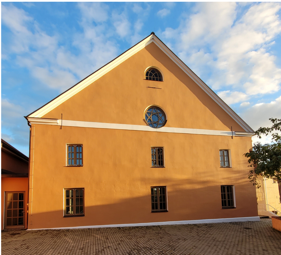
Strautu_4_88130020131001_fasade3 Skats uz ēku no ziemeļrietumiem.
