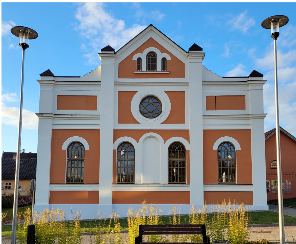
Strautu_4_88130020131001_fasade1 Skats uz ēku no dienvidaustrumiem. Esošais lūgšanu telpas logu sīkrūšu dalījums nav atbilstošs vēsturiskajiem logiem.
