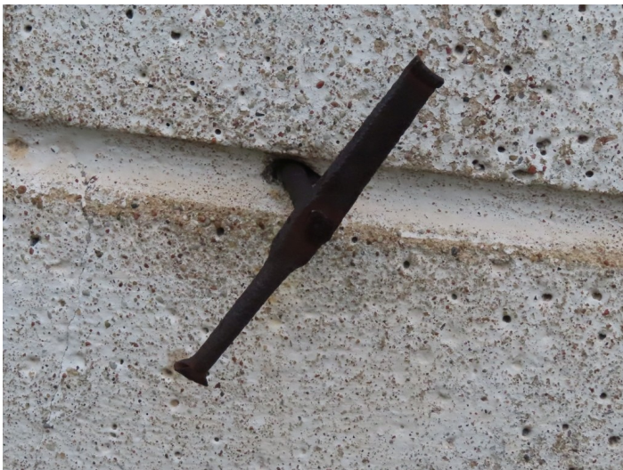
Riigas_29_88130040070001 _slegis1 Sākotnējs slēģa atvērta stāwokļa fiksators.
