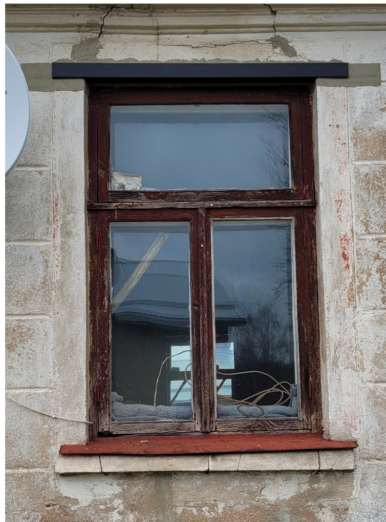
Riigas_29_88130040070001_logs2 1960.gadu logs. Dalījums neatbilstošs sākotnējam.
