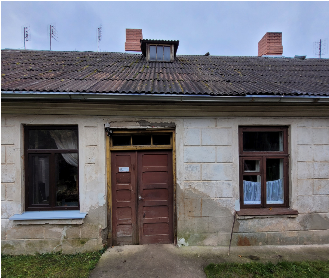
Riigas_29_88130040070001_fragments2 Ziemeļaustrumu fasādes fragments ar sākotnējo ieejas durvju ailu, kurā saglabājusies aploda un virslogs. Jumta loga izbūve – 1960.gadi.
