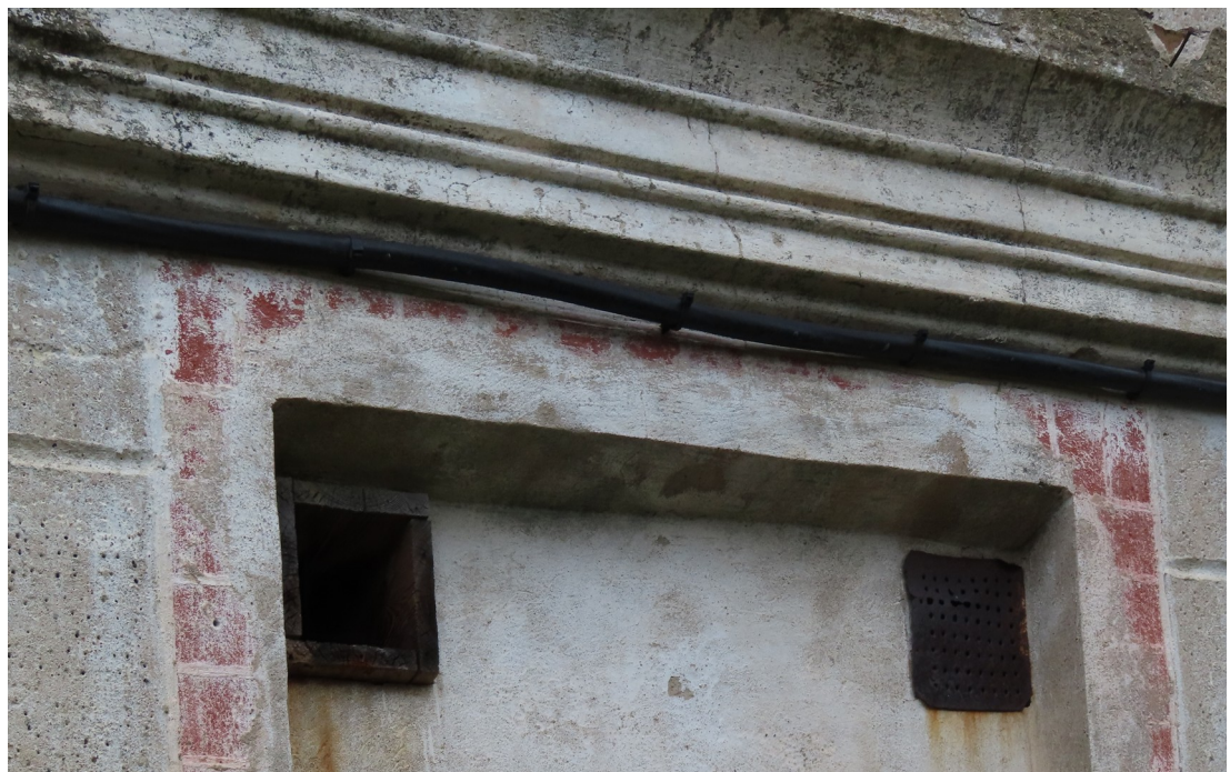
Riigas_29_88130040070001_fragments3 Sākotnējā ailu apdare – ķieģeļu imitācijas krāsojums.
