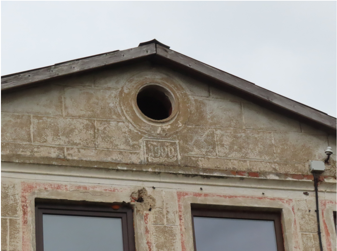
Riigas_29_88130040070001_fragments1 Skats uz mezonīna frontonu dienvidrietumu fasādē. Marķēts ēkas celtniecības laiks – 1900.gads.
