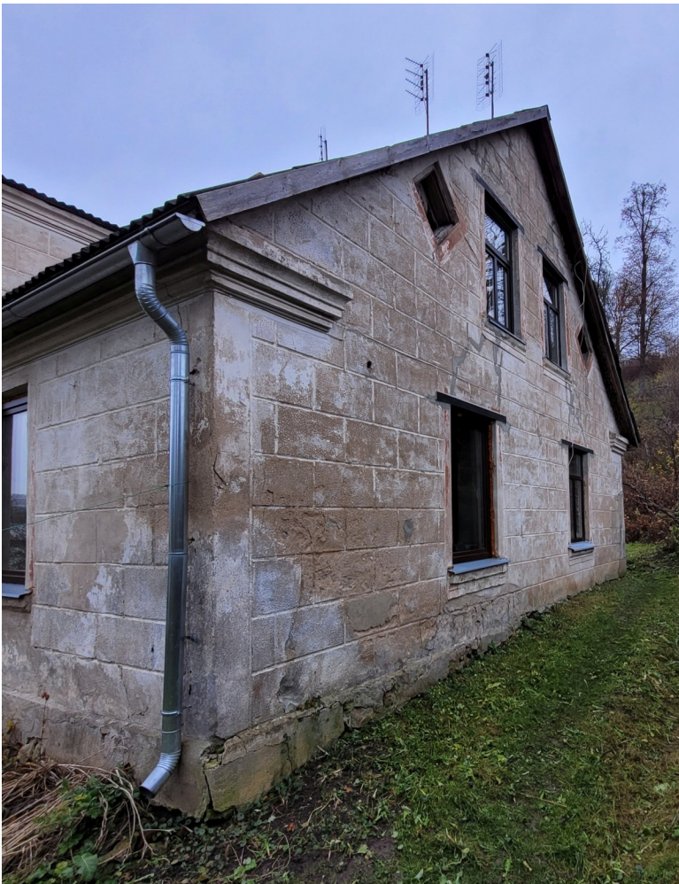
Riigas_29_88130040070001_ fasade4 Skats uz ēkas dienvidaustrumu fasādi.
