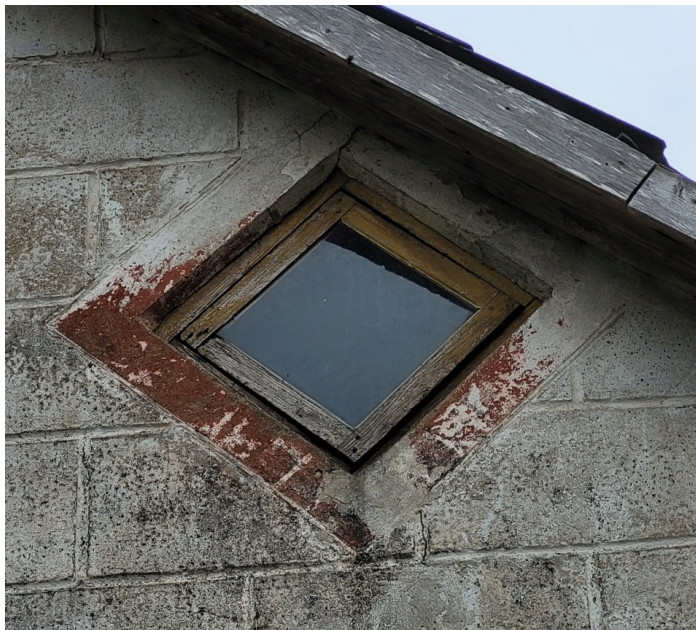
Riigas_29_88130040070001 _logs1 Sākotnējs logs un ailas apdare.
