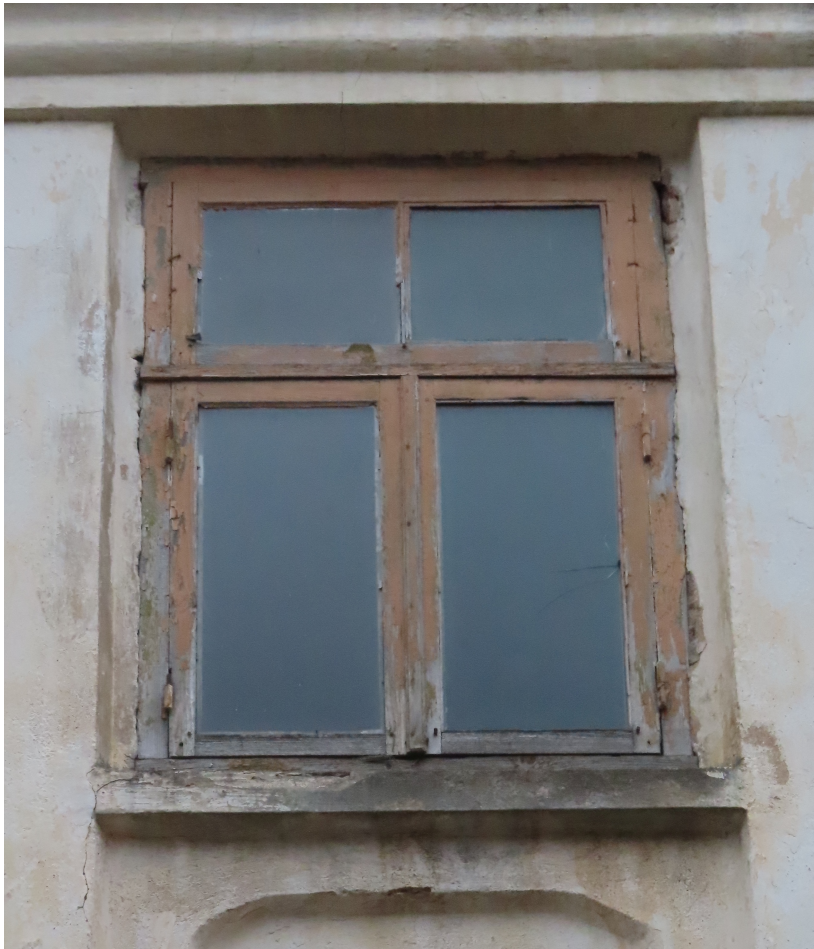
Riigas_28_88130040038001 _logs1 Logs galvenās fasādes mezonīnā. 20.gs. 2.trešdaļa.
