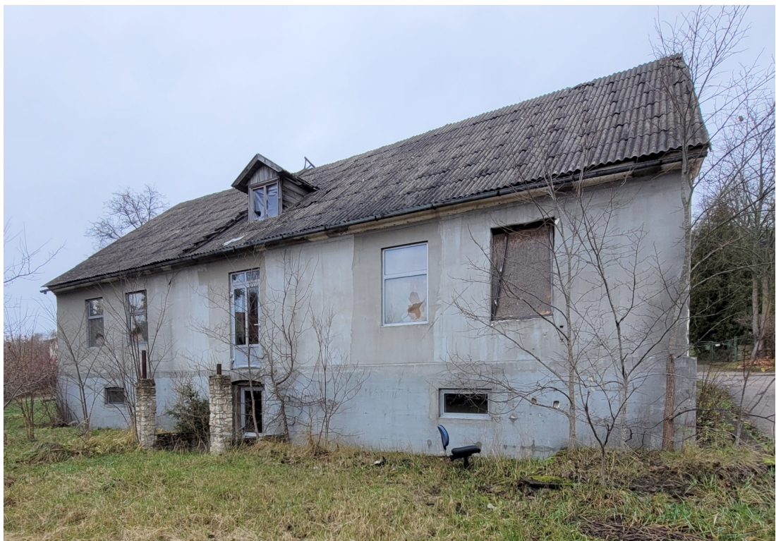
Riigas_28_88130040038001_fasade4 Skats uz ēku no dienvidiem.
