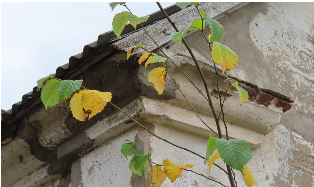
Riigas_28_88130040038001_dzega1 Ēkas rietumu stūris ar sākotnējo dzegu.
