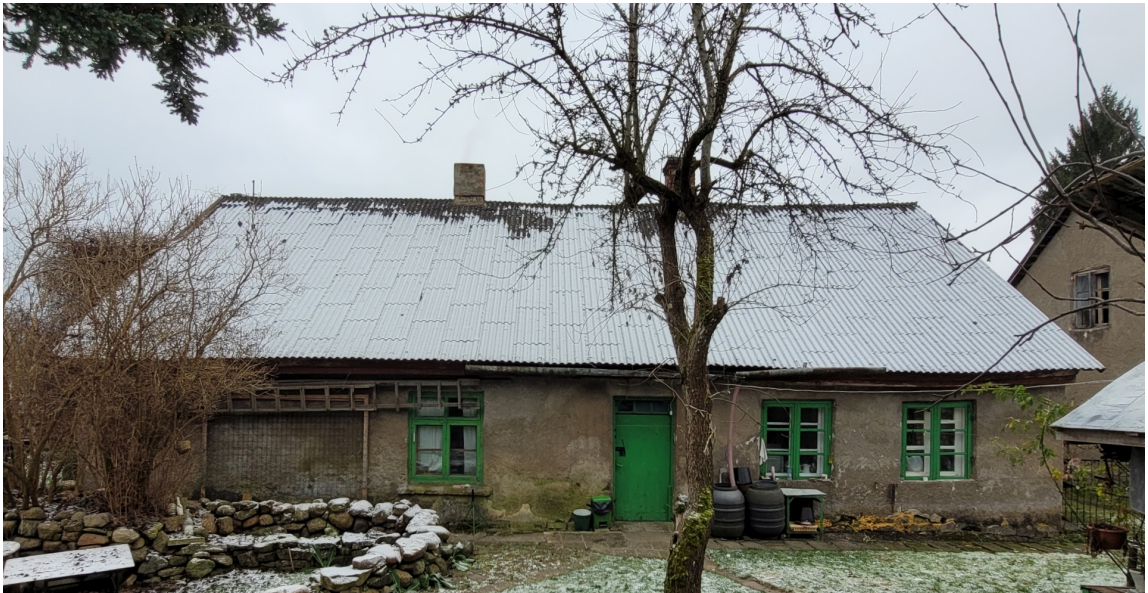
Riigas_25_88130040016001_fasade3 Skats uz ēku no ziemeļaustrumiem.
