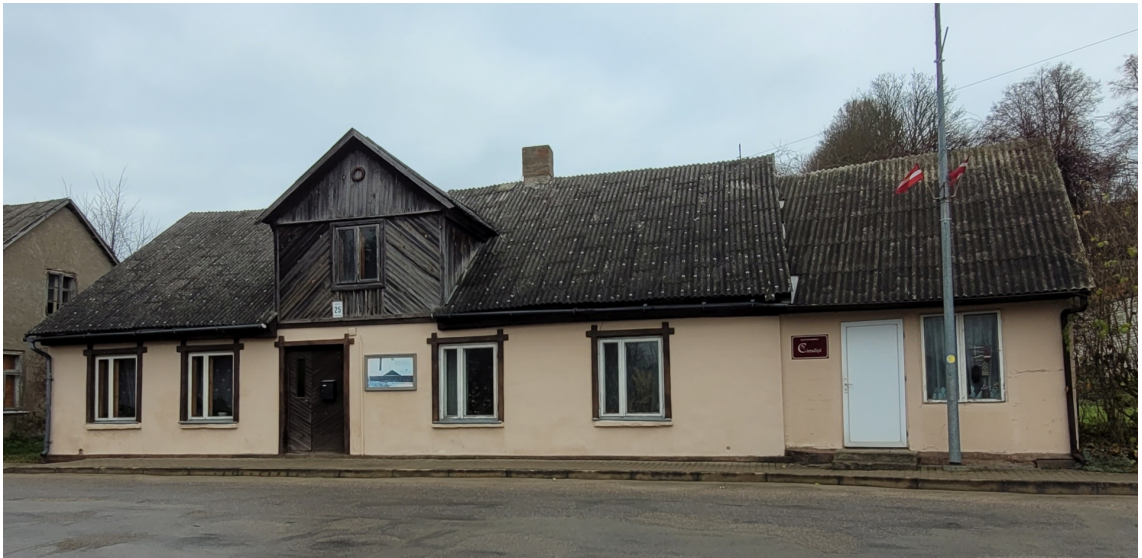
Riigas_25_88130040016001_fasade1 Skats uz ēku no dienvidrietumiem. Fasādē vēsturisks mezonīns ar 20.gs. beigu apdari. Piebūve ēkas labajā pusē – 20.gs. pēdējais ceturksnis.
