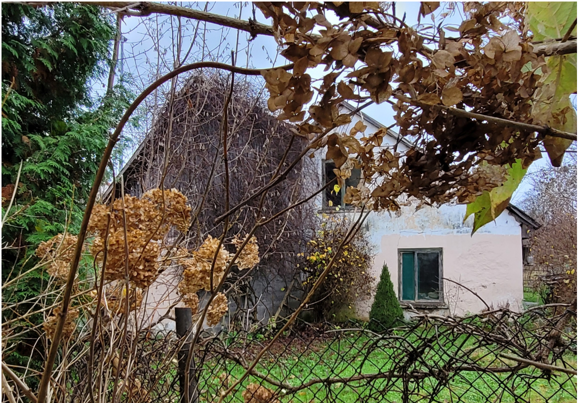
Riigas_25_88130040016001_fasade4 Skats uz ēku no dienvidaustrumiem. Fasādes kreisajā pusē 20.gs. pēdējā ceturkšņa piebūve.
