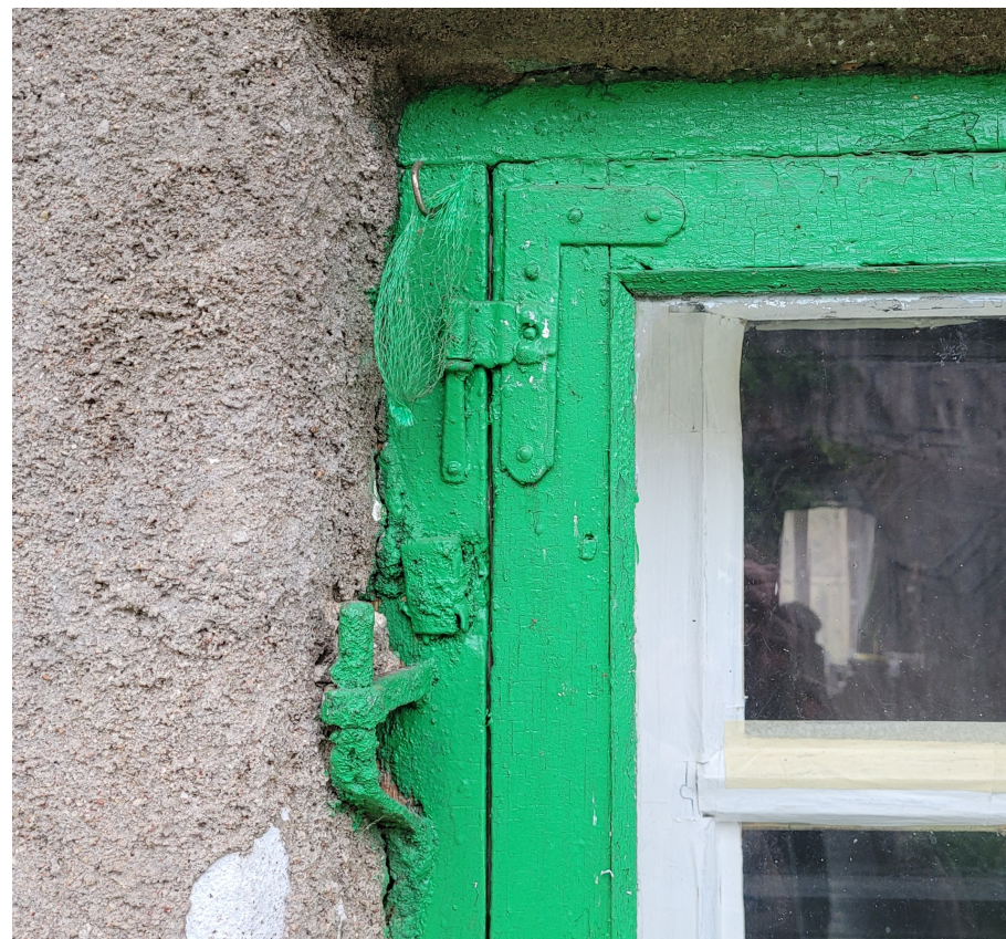
Riigas_25_88130040016001_logs2 Sākotnēja loga kāšu vira un slēģa viras kāsis.
