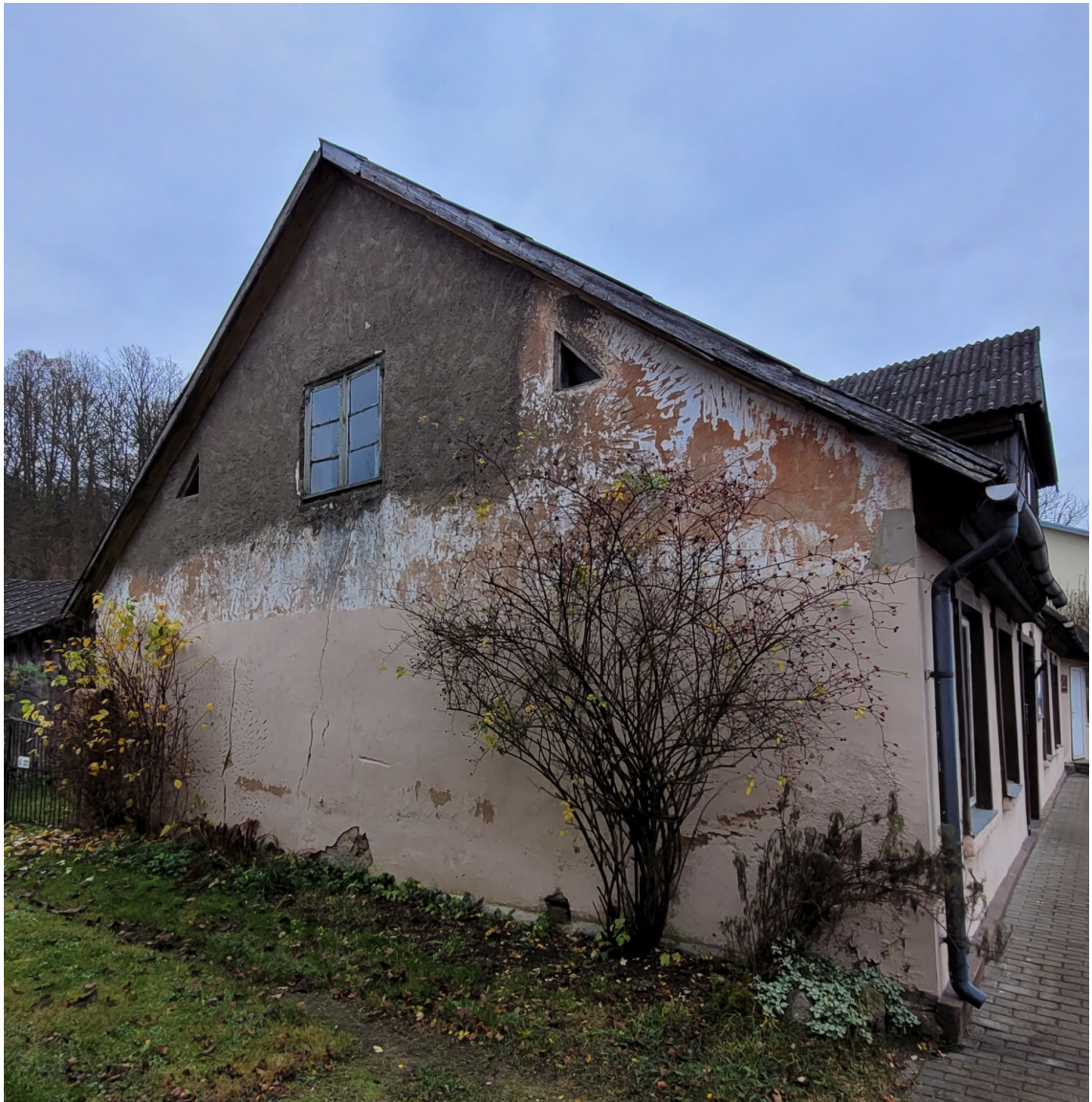
Riigas_25_88130040016001_fasade2 Skats uz ēku no ziemeļrietumiem.
