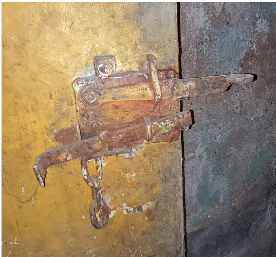
Riigas_23_88130040015001_durvis5 1920.gadu ārdurvis ziemeļaustrumu fasādes piebūvē. Saglabājies vērtnes aizvērta stāvokļa fiksators un aizbīdnis.
