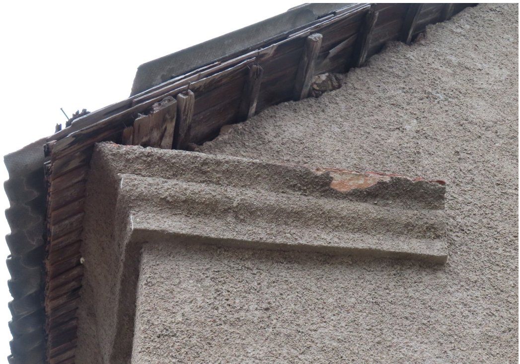
Riigas_23_88130040015001_dzega1 Ēkas dienvidu stūris. Sākotnēja dzega. Saglabājies skaidu segums.
