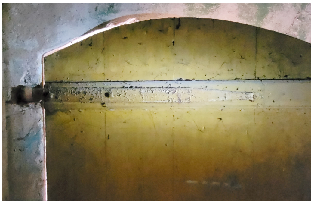
Riigas_23_88130040015001_durvis7 1920.gadu ārdurvis ziemeļaustrumu fasādes piebūvē. Lentveida kāšu vira.
