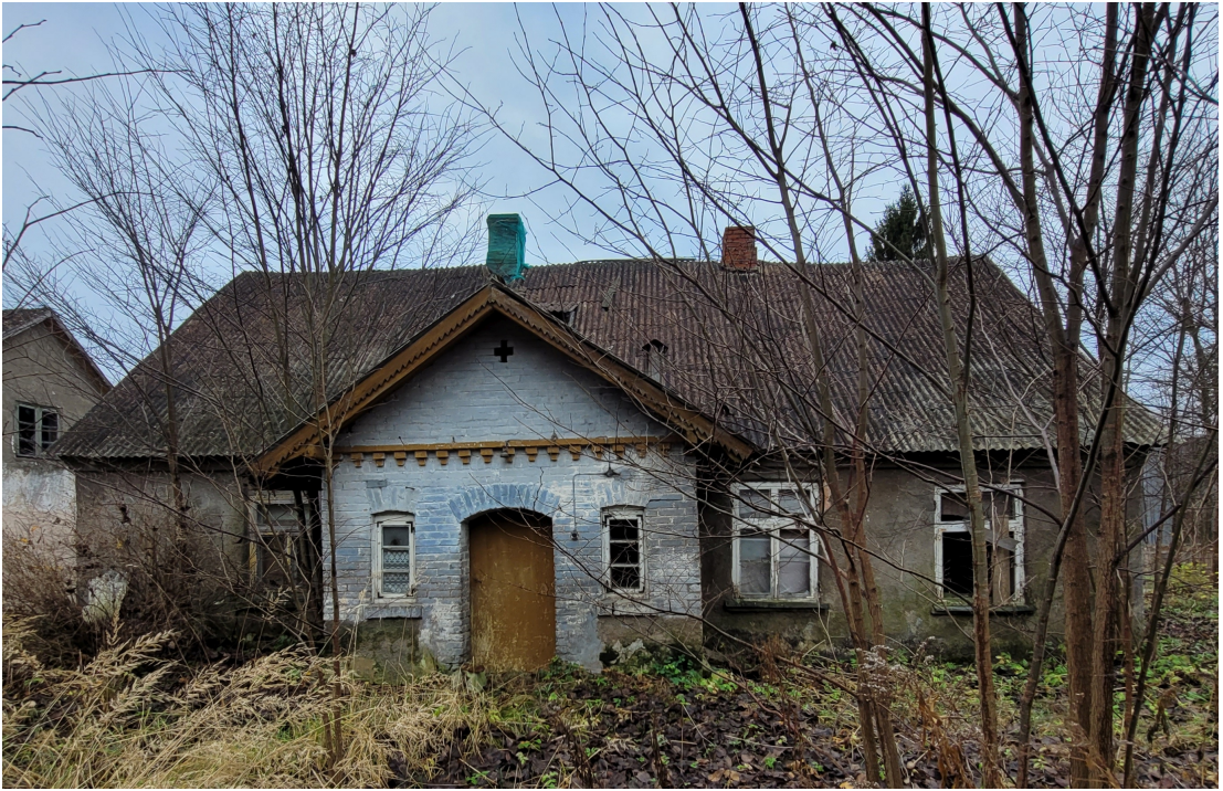
Riigas_23_88130040015001_fasade4 Skats uz ziemeļaustrumu fasādi. Piebūve – 1920.gadi.
