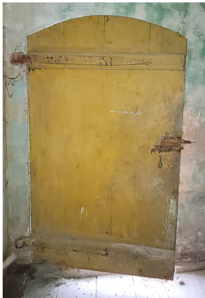
Riigas_23_88130040015001_durvis4 1920.gadu ārdurvis ar aprīkojumu ziemeļaustrumu fasādes piebūvē (iekšskats).
