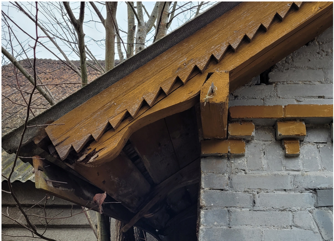
Riigas_23_88130040015001_fragments1 Ziemeļaustrumu fasādes piebūves jumta konstrukcijas fragments. 1920.gadi.
