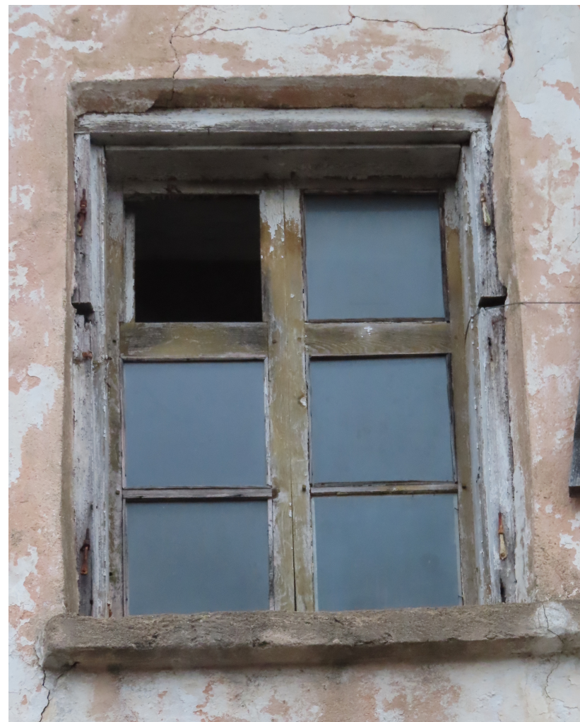
Riigas_23_88130040015001_logs3 Logs ar ziemas vētrni un daļēji saglabājušos aprīkojumu dienvidrietumu fasādes 2.stāvā. 1920.gadi.
