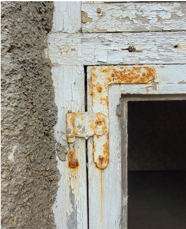
Riigas_23_88130040015001_ logs7 Sākotnēja loga kāšu vira. 19.gs. beigas – 20.gs. sākums.
