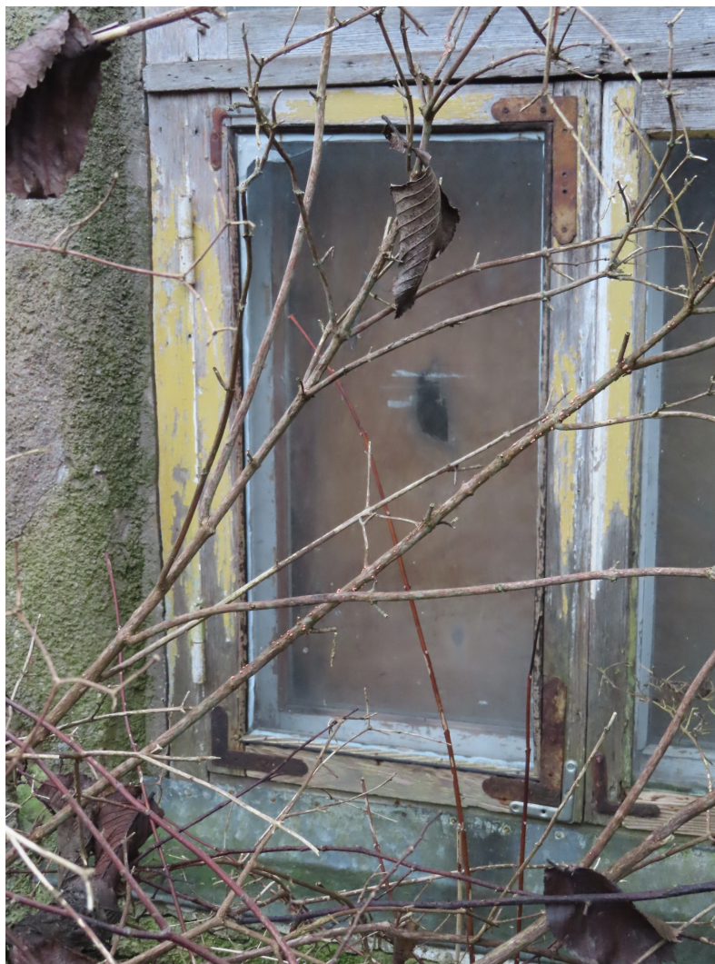
Riigas_23_88130040015001_logs5 Sekundārs logs ar atkārtoti izmantotu 19.gs.2.puses aprīkojumu.
