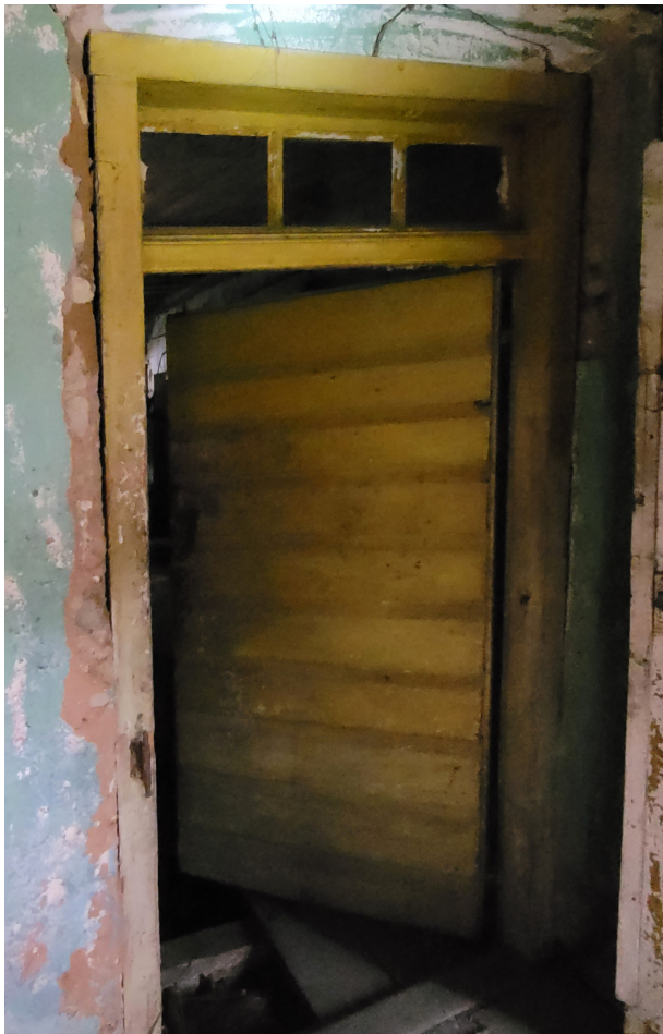
Riigas_23_88130040015001_durvis1 Sākotnējas ēkas ārdurvis ziemeļaustrumu fasādē (šobrīd piebūvē). 19.gs. beigas – 20.gs. sākums. Saglabājies aprīkojums.
