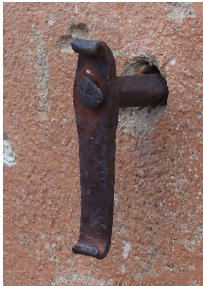
Riigas_23_88130040015001_slegis2 Sākotnēja slēga atvērta stāvokļa fiksators. 19.gs. beigas – 20.gs. sākums.
