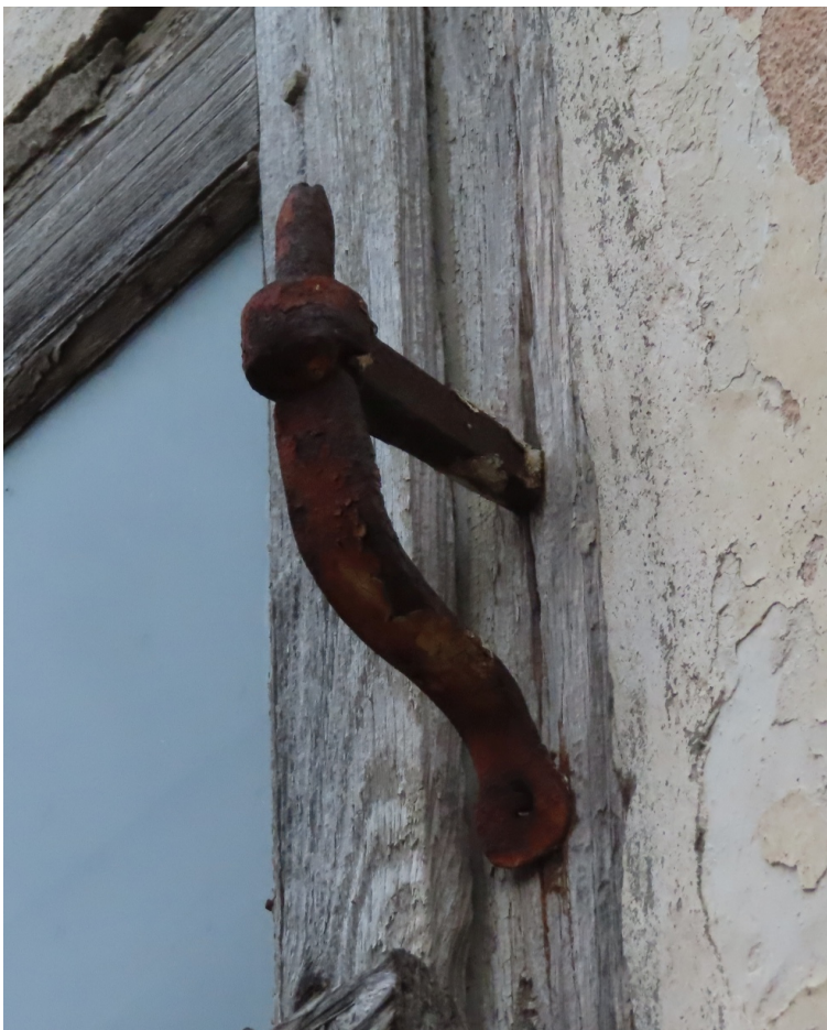
Riigas_23_88130040015001_slegis1 Sākotnēja slēga kāšu vira. 19.gs. beigas – 20.gs. sākums.
