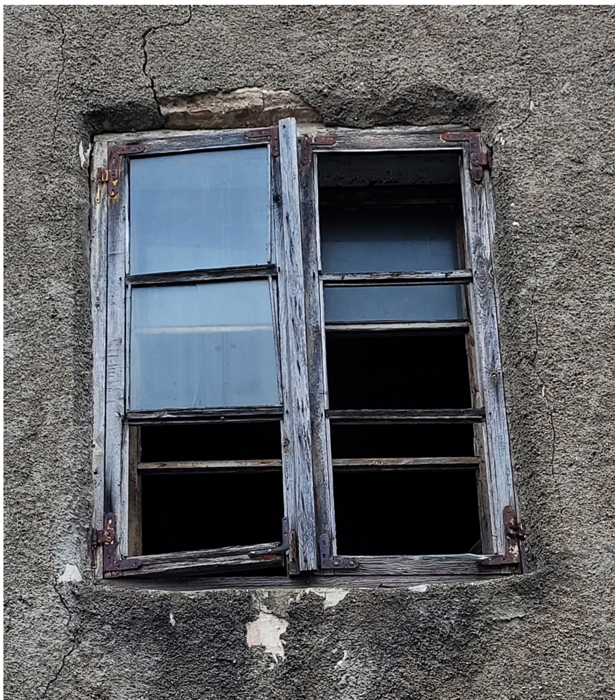
Riigas_23_88130040015001_logs2 Sākotnējs logs ar aprīkojumu dienvidaustrumu fasādes zeltinī. 19.gs. beigas – 20.gs. sākums.
