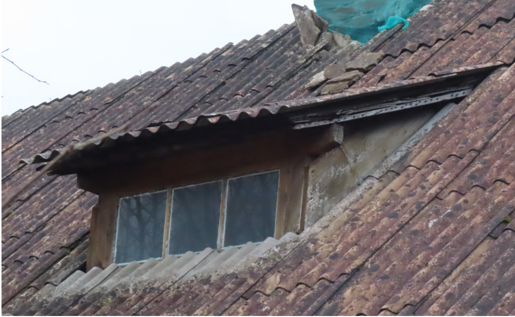
Riigas_23_88130040015001_logs6 Sākotnēja jumta loga izbūve un logs. 19.gs. beigas – 20.gs. sākums.
