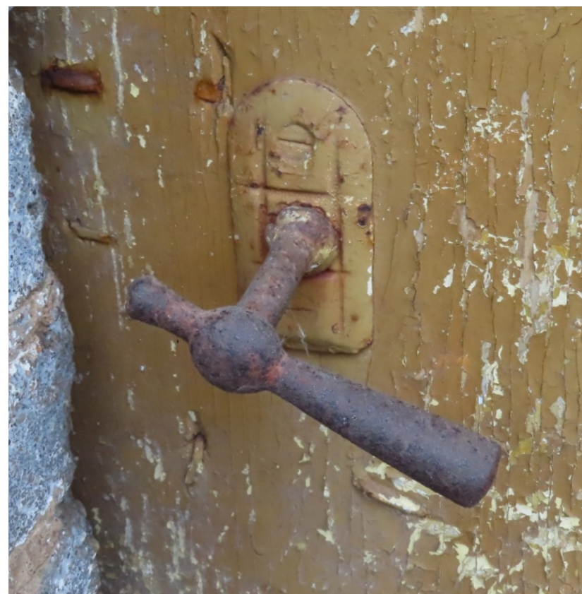
Riigas_23_88130040015001_durvis6 1920.gadu ārdurvis ziemeļaustrumu fasādes piebūvē. Durvju rokturis.
