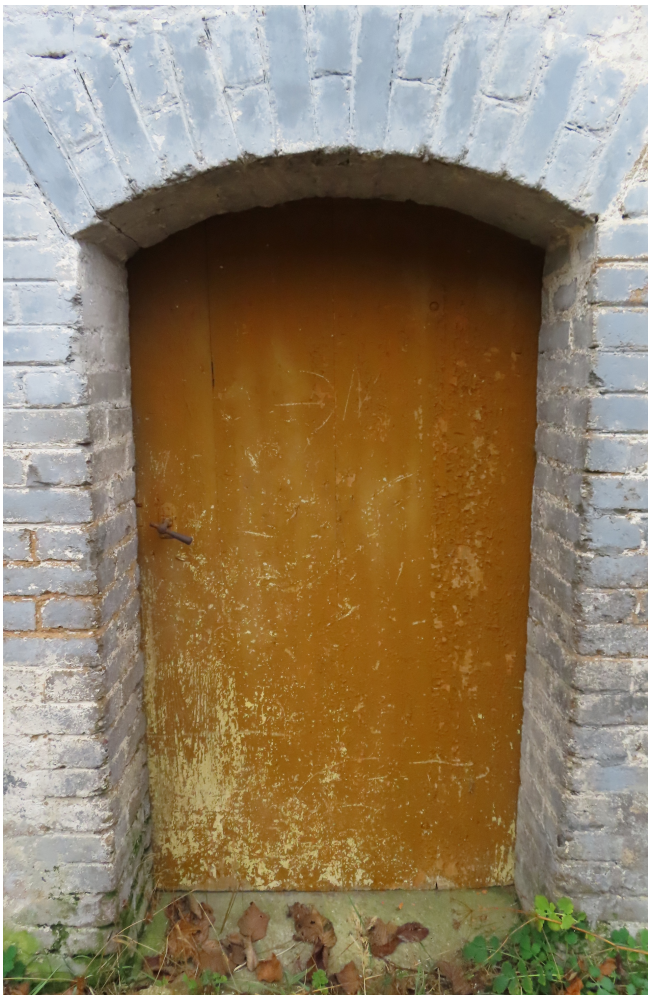
Riigas_23_88130040015001_durvis3 1920.gadu ārdurvis ziemeļaustrumu fasādes piebūvē. Saglabājies aprīkojums.
