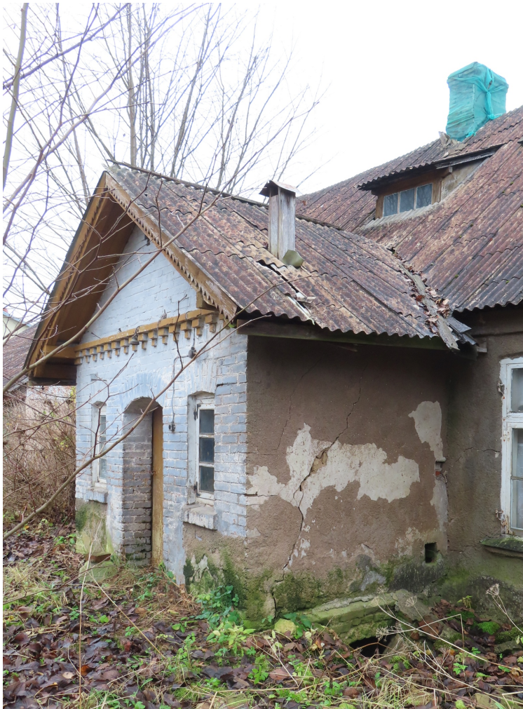
Riigas_23_88130040015001_ fasade6 Skats uz ziemeļaustrumu fasādes piebūvi no ziemeļiem.
