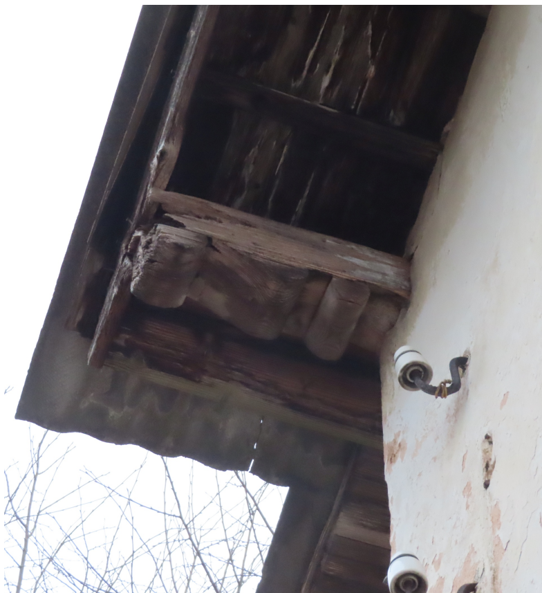
Riigas_23_88130040015001_ fragments2 Dienvidrietumu fasādes divstāvu apjoma mūrlatas gals. 1920.gadi.
