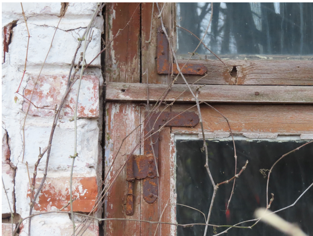
Riigas_22A_88130040068003_logs4 Sākotnējs pamatapjoma loga aprīkojums. 19.gs. beigas – 20.gs. sākums.
