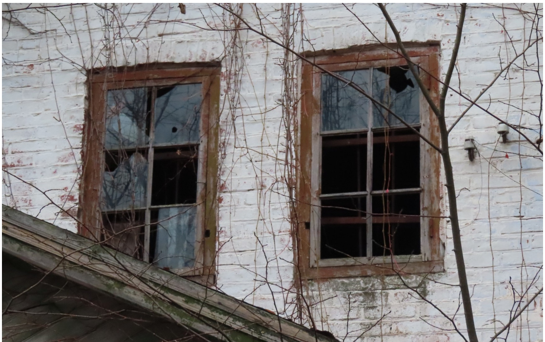
Riigas_22A_88130040068003_logs2 Sākotnēji logi pamatapjoma ziemeļaustrumu fasādes zelminī. Sākotnēji, domājams, neverami. 19.gs. beigas – 20.gs. sākums.
