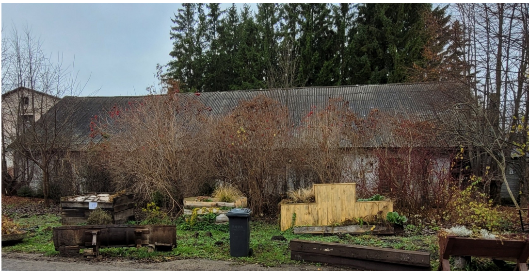
Riigas_22A_88130040068003_fasade1 Skats uz ēku no dienvidaustrumiem. Pilnībā saglabājies vēsturiskais apjoms.
