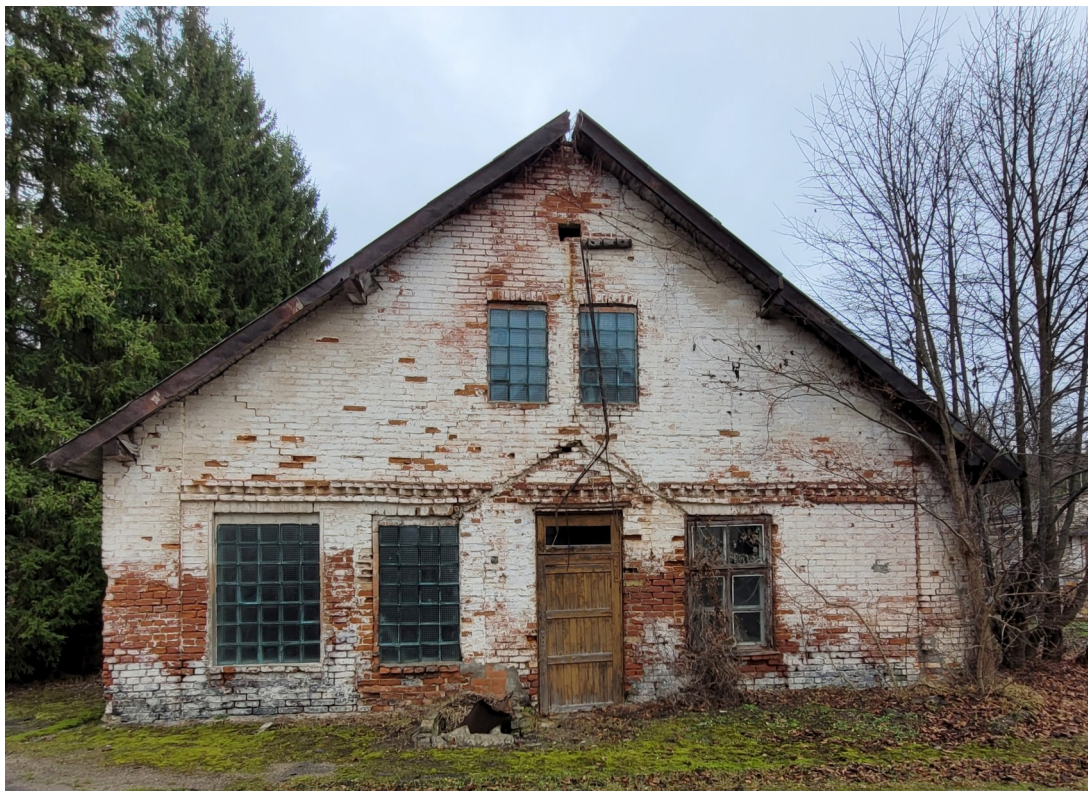
Riigas_22A_88130040068003_fasade6 Skats uz ēku no dienvidrietumiem.
