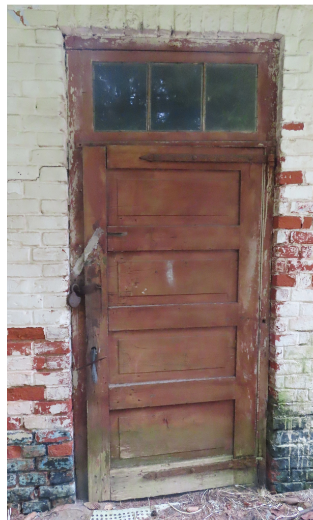
Riigas_22A_88130040068003_durvis3 Sākotnēja durvju aploda ar virslogu. Vērtne – 1960.gadi.
