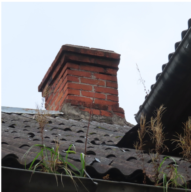
Riigas_21_88130040001001_detala1 Sākotnējais skurstenis ēkas pamatapjomam.
