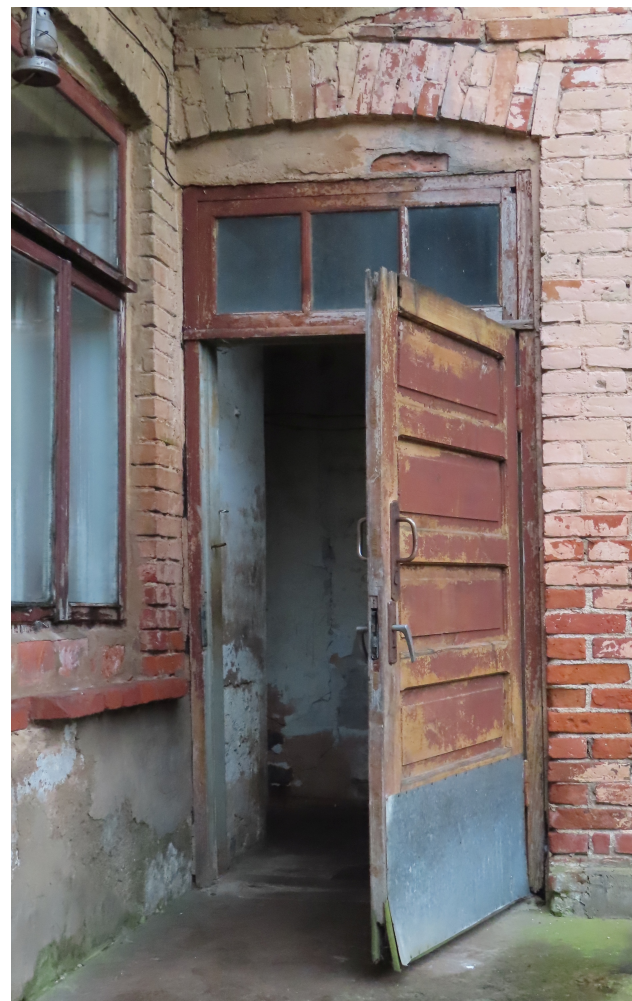
Riigas_21_88130040001001_durvis5 Ieejas durvis pagalma korpusā. 1960.gadi. Aploda un virslogs hronoloģiski vecāki.
