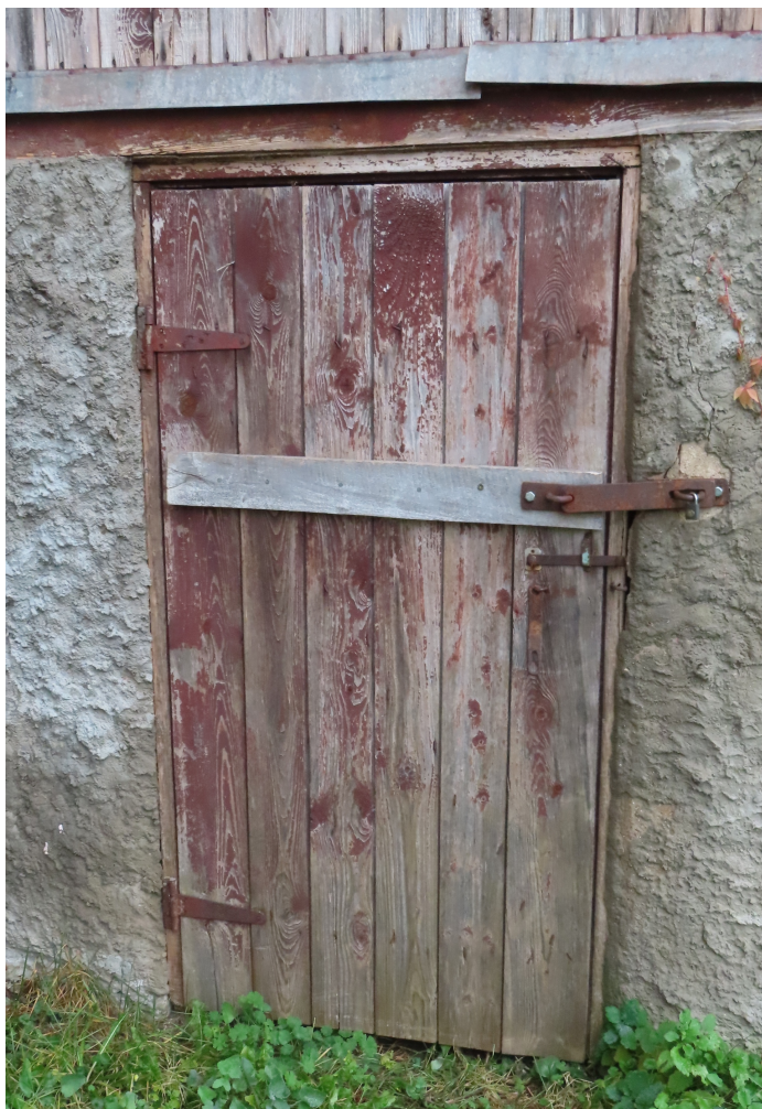
Riigas_21_88130040001001_durvis6 Ieejas durvis dienvidrietumu fasādes austrumu puses verandas cokolā. 1950. - 1960.gadi.
