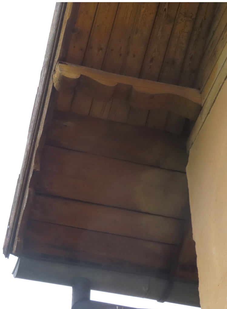
Riigas_21_88130040001001_fragments9 Skats uz atejas piebūves jumtu. 19.gs. beigu - 20.gs. sākuma konstrukcija.
