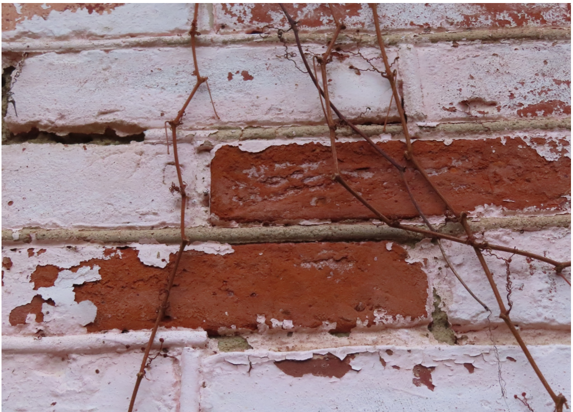
Riigas_21_88130040001001_fragments2 Pamatapjoma galvenās fasādes sienas fragments ar sākotnējo apdari – eksponēts krāsotu ķieģeļu mūris ar reljefu šuvojumu. Pagalma fasādē ķieģeļi nekrāsoti.
