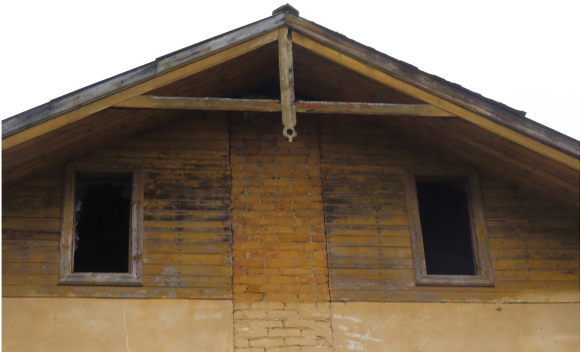
Riigas_21_88130040001001_fragments1 Skats piebūves ziemeļaustrumu fasādes zelmini. 20.gs. 20.gadu (iespējams, 1928.gadā) pārbūvē likvidēts skurstenis fasādes galā.
