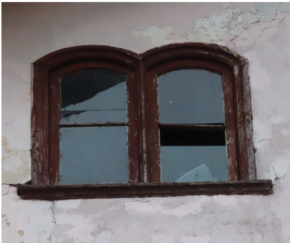
Riigas_21_88130040001001_logs5 Sākotnējie logi galvenās fasādes mezonīna zelminī. 1920.gadi.
