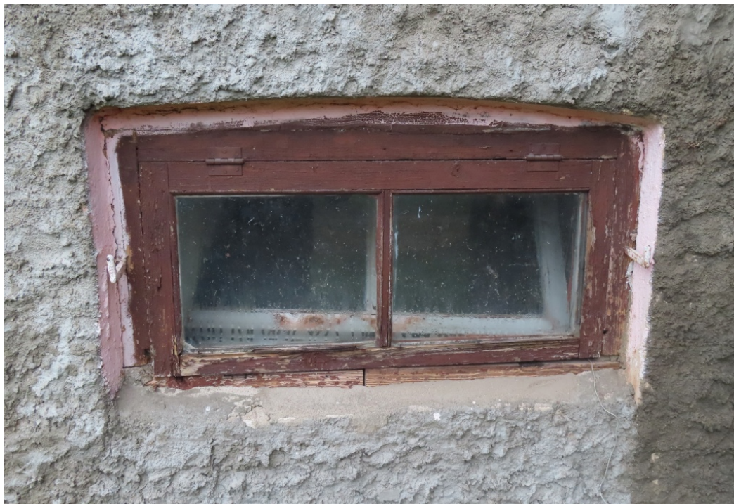
Riigas_21_88130040001001_logs1 Sākotnēja pagraba loga augšējā daļa – aploda un vērtne. Viras sekundāras. Saglabājušies aplodā iestrādāti slēgu viru kāši.
