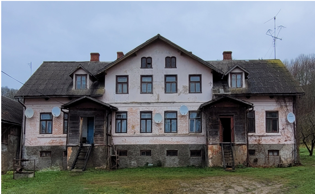
Riigas_21_88130040001001_fasade1 Skats uz ēku no dienvidrietumiem. Mezonīns un jumta logu izbūves – 1920.gadi (iespējams, 1928.gads).
