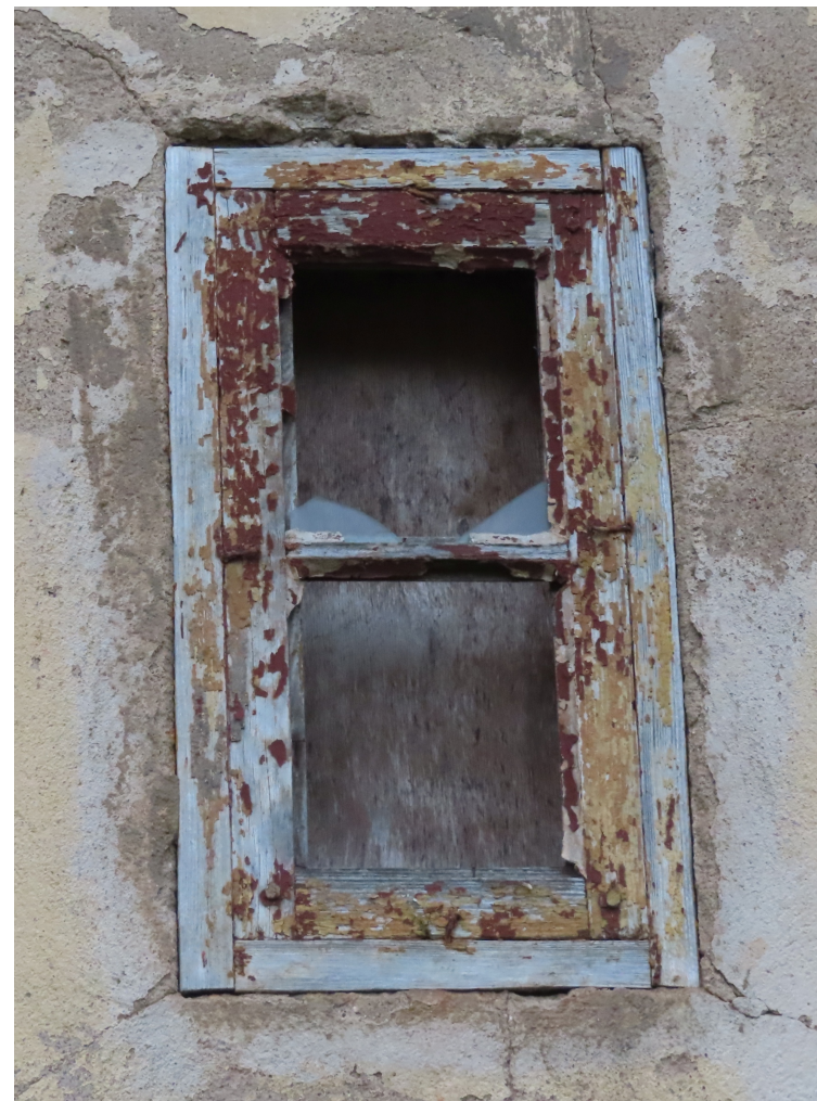
Riigas_21_88130040001001_logs2 Sākotnējs pagalma fasādes ateju piebūves logs. 19.gs. beigas – 20.gs. sākums.
