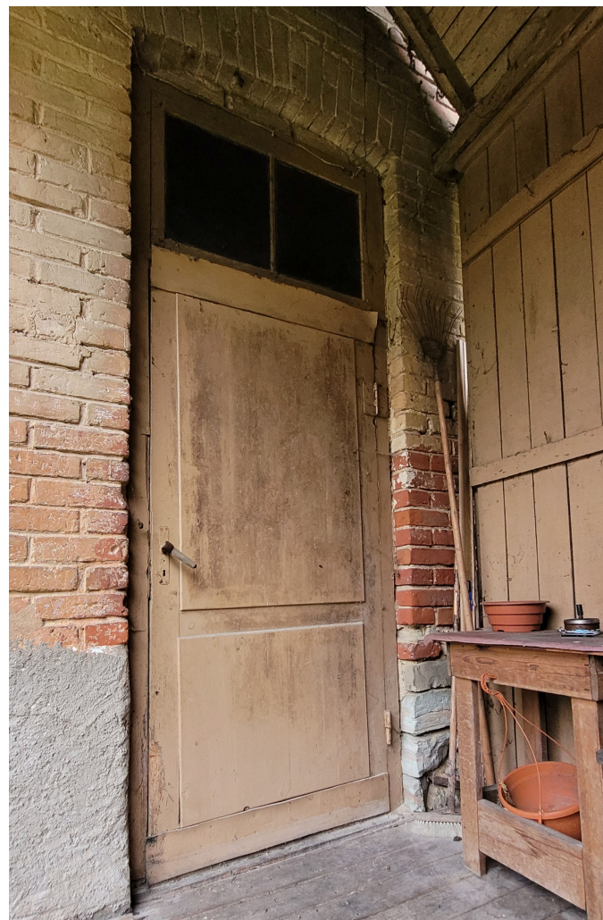
Riigas_21_88130040001001_durvis1 Vēsturiskas ārdurvis ziemeļaustrumu (pagalma) fasādē – sākotnēja aploda un virslogs, vērtne, domājams, hronoloģiski jaunāka.
