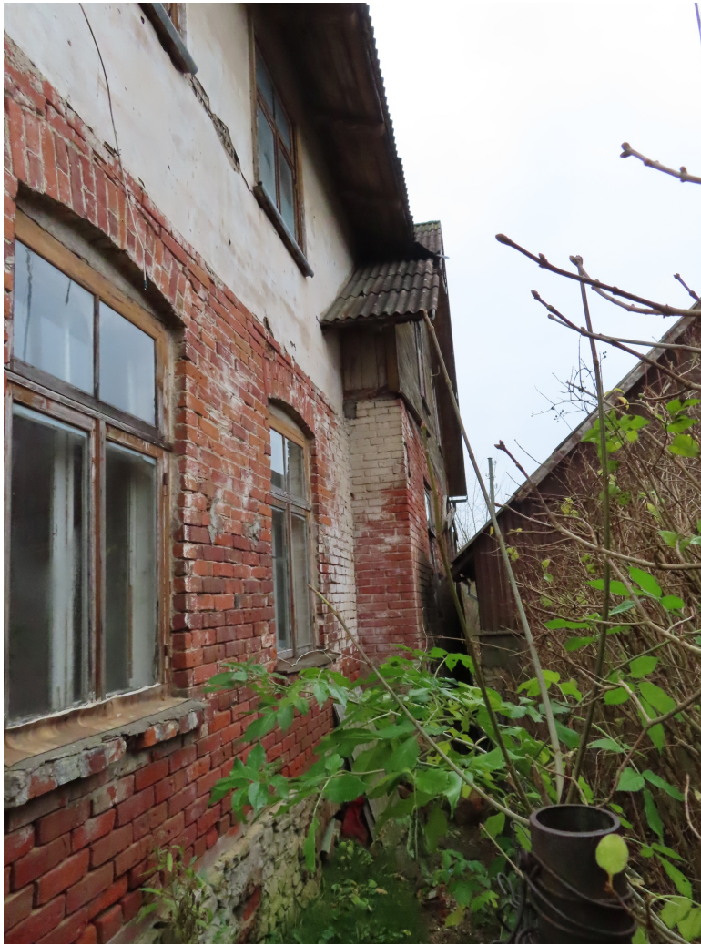
Riigas_21_88130040001001_ fasade8 Skats uz piebūves un pamatapjoma ziemeļrietumu fasādes daļu.
