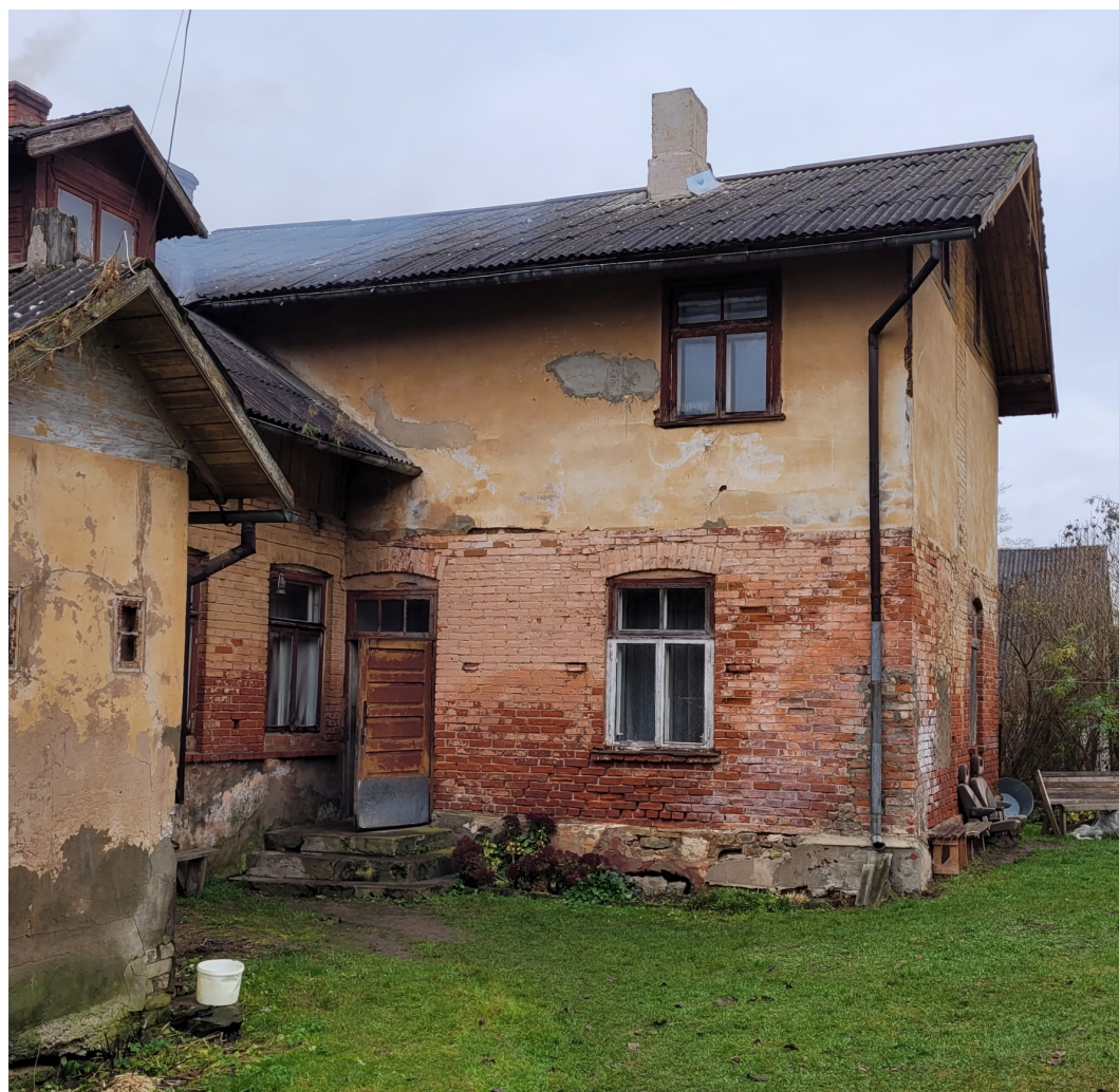
Riigas_21_88130040001001_fasade6 Skats uz fasādes rietumu gala piebūvi no dienvidaustrumiem. Sākotnēji 2.stāvs neapmests. Piebūves pārbūve veikta 20.gs. 20.gados (iespējams, 1928.gadā).
