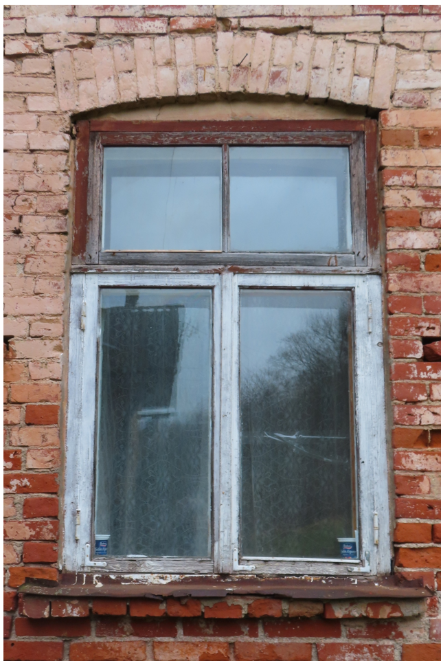
Riigas_21_88130040001001_logs7 Loga pagalma korpusā. Aploda un vērtne – 1920.gadi. Apakšējās vērtnes sekundāras.
