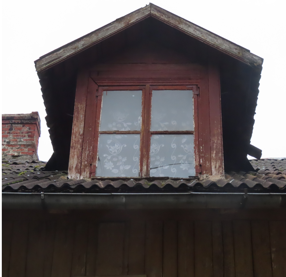
Riigas_21_88130040001001_logs3 Jumta loga izbūve ar oriģinālo logu un aprīkojumu pagalma fasādē. 1920.gadi.
