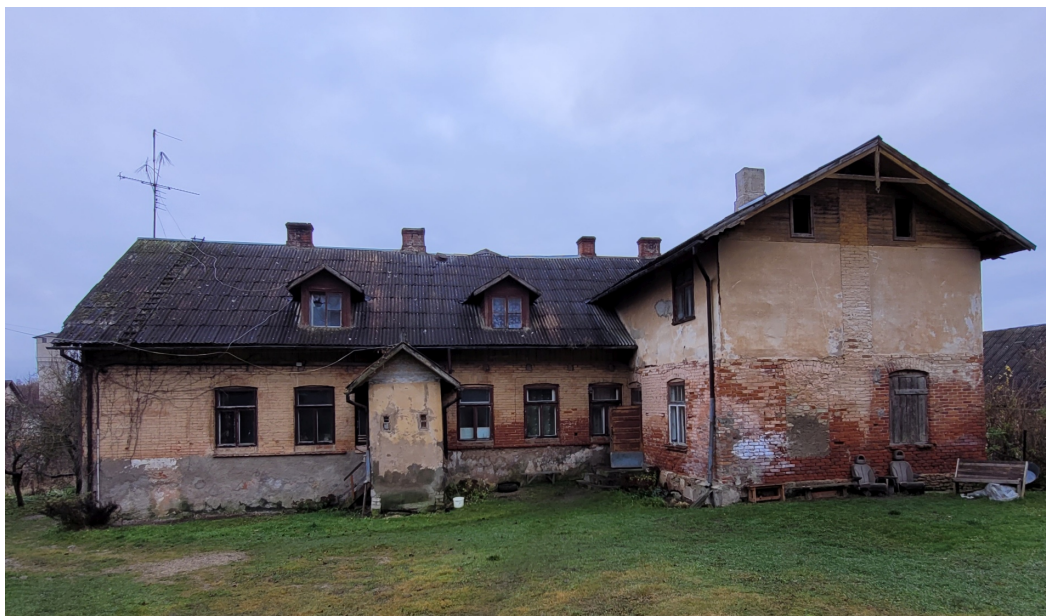
Riigas_21_88130040001001_fasade4 Skats uz ēku no ziemeļaustrumiem. Ateju piebūve pamatapjoma vidū – 19.gs. beigas -20.gs. sākums (līdz 1.pasaules karam). Pagalma korpusa 2.stāvs pārbūvēts 20.gs. 20.gados (iespējams, 1928.gadā).
