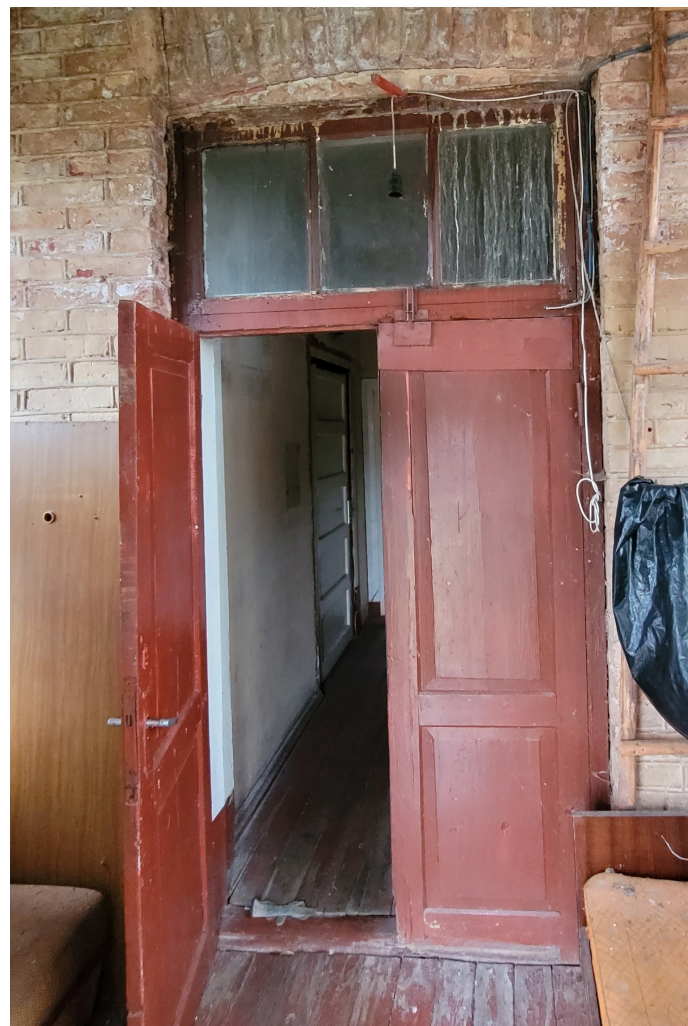
Riigas_21_88130040001001_durvis3 Ieejas durvis ēkā no austrumu puses verandas. Aploda un virslogs vēsturiski, vērtnes – 1960.gadi.
