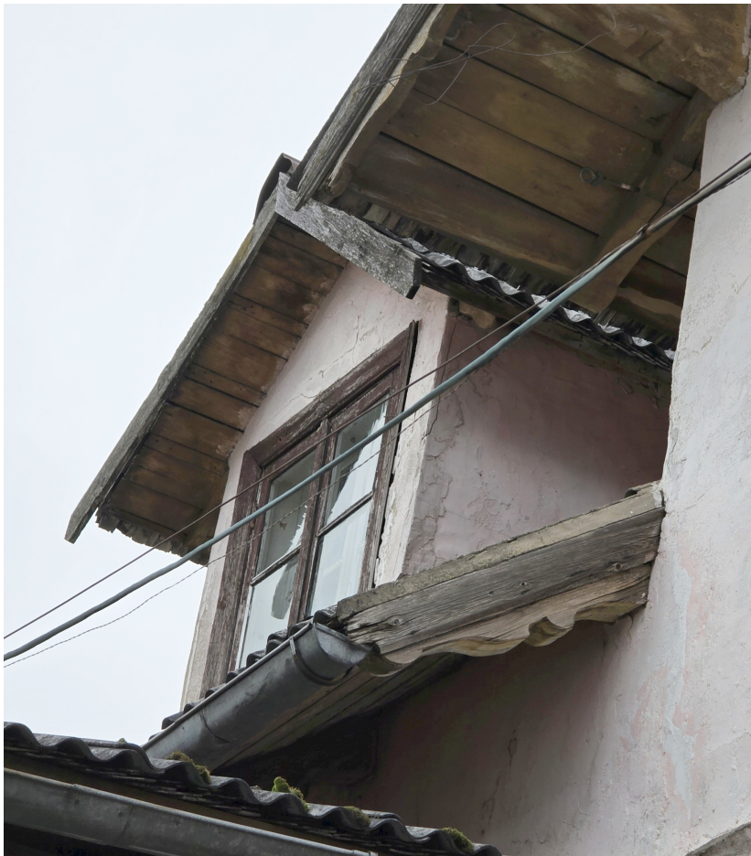
Riigas_21_88130040001 001_fragments6 1920.gadu jumta loga izbūve pamatapjoma dienvidrietumu fasādē. Ēkas jumtam un mezonīnam spāres ar dekoratīviem galiem.
