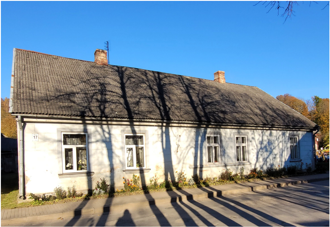
Riigas_17_88130040004003_fasade1 Skats uz ēku no dienvidrietumiem.
