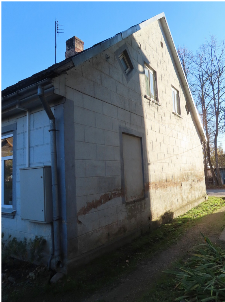
Riigas_17_88130040004003_fasade4 Skats uz ēku no ziemeļiem.
