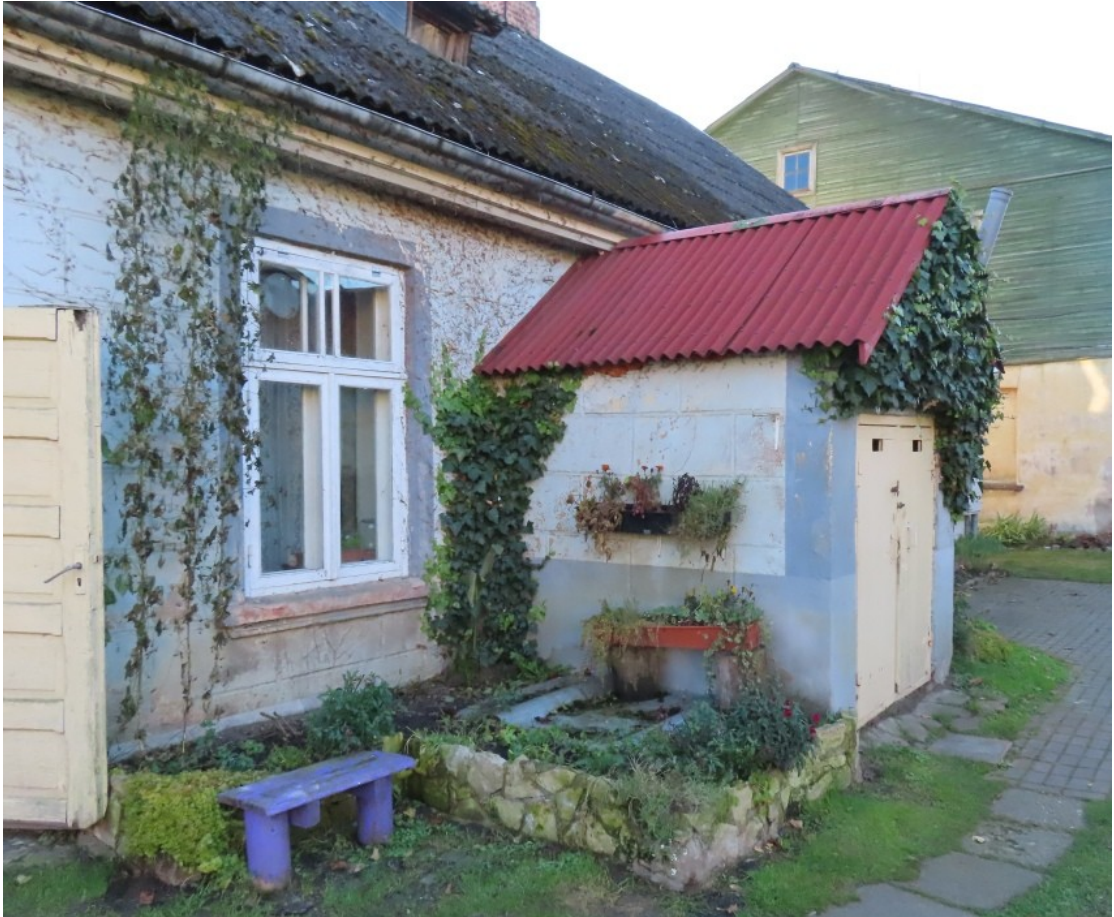
Riigas_17_88130040004003_fragments1 Skats uz ziemeļaustrumu fasādes rietumu galu. Sākotnēja piebūve.
