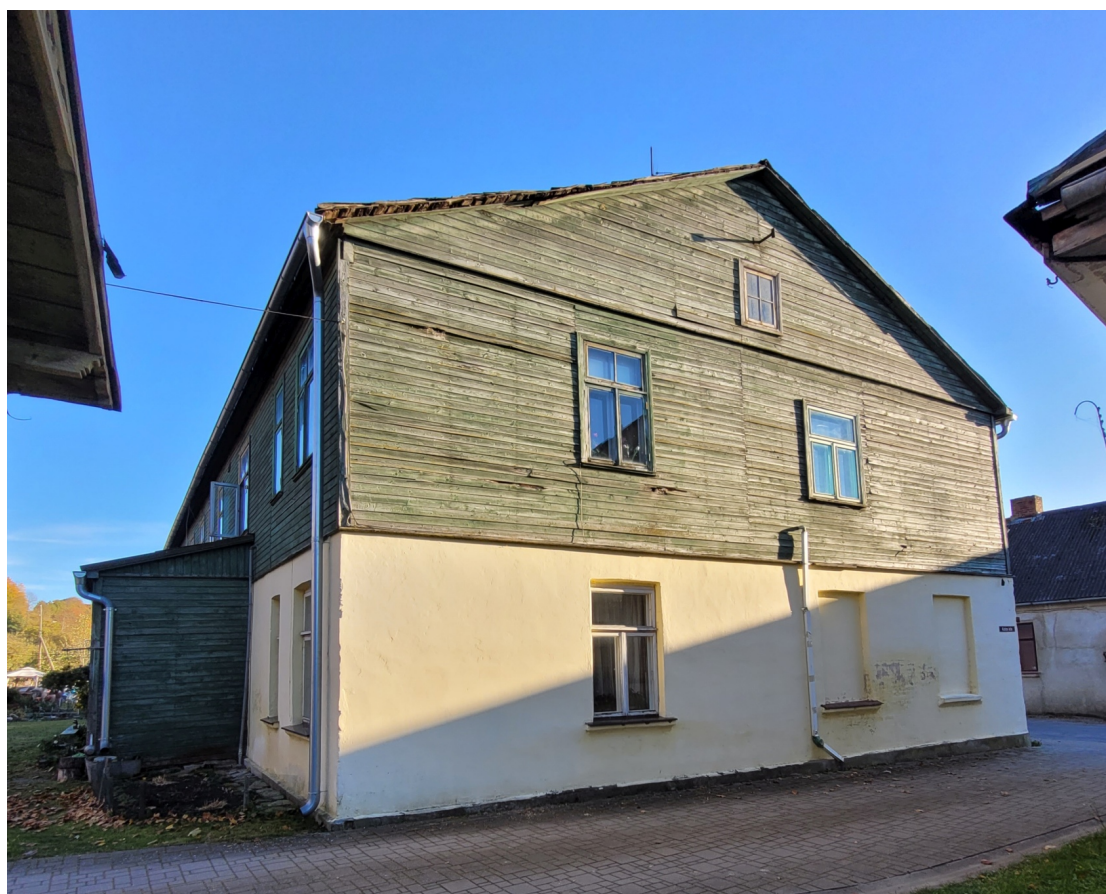
Riigas_15_88130040004001_fasade2 Skats uz ēku no ziemeļrietumiem.
