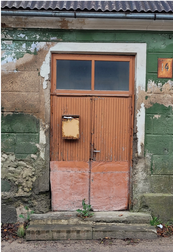
Riigas_14_88130040040001_ durvis1 1950.gados logailas vietā izbūvētas durvis. Esošās vērtnes sekundāras.
