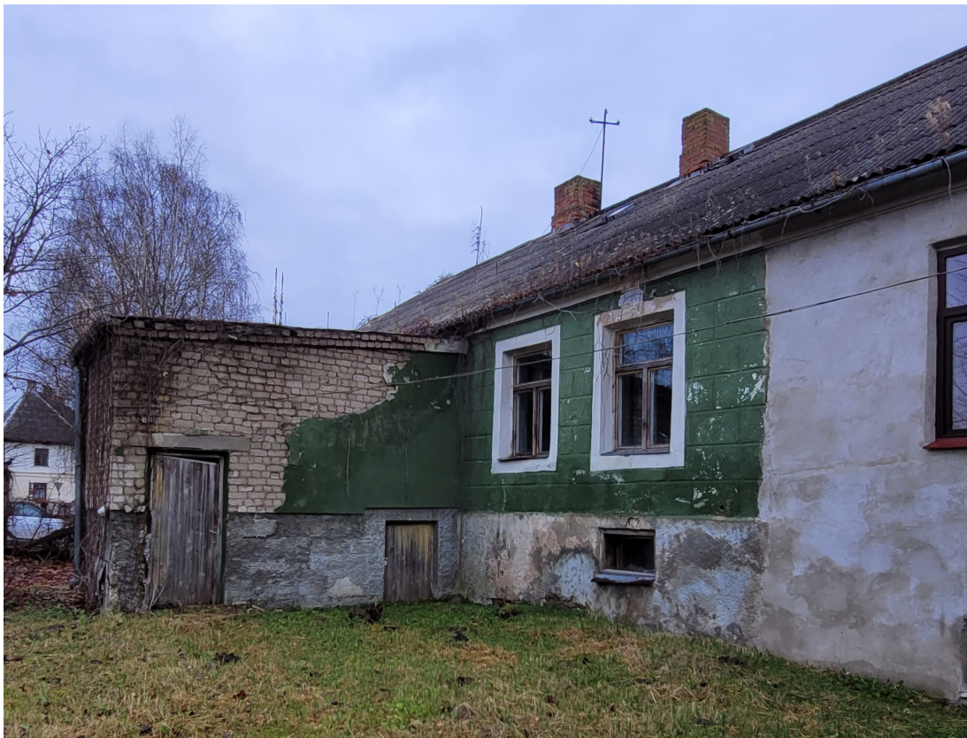
Riigas_14_88130040040001_fasade7 Skats uz ēkas dienvidrietumu fasādes rietumu pusi.
