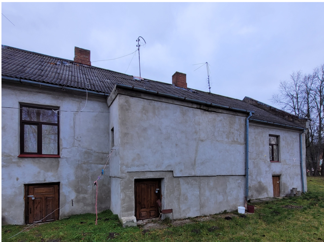
Riigas_14_88130040040001_fasade6 Skats uz ēkas dienvidrietumu fasādes austrumu pusi.
