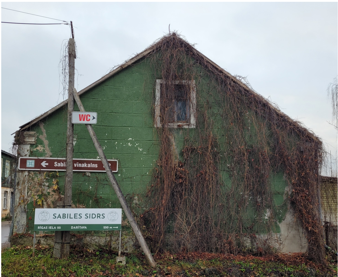
Riigas_14_88130040040001_fasade2 Skats uz ēku no ziemeļrietumiem.
