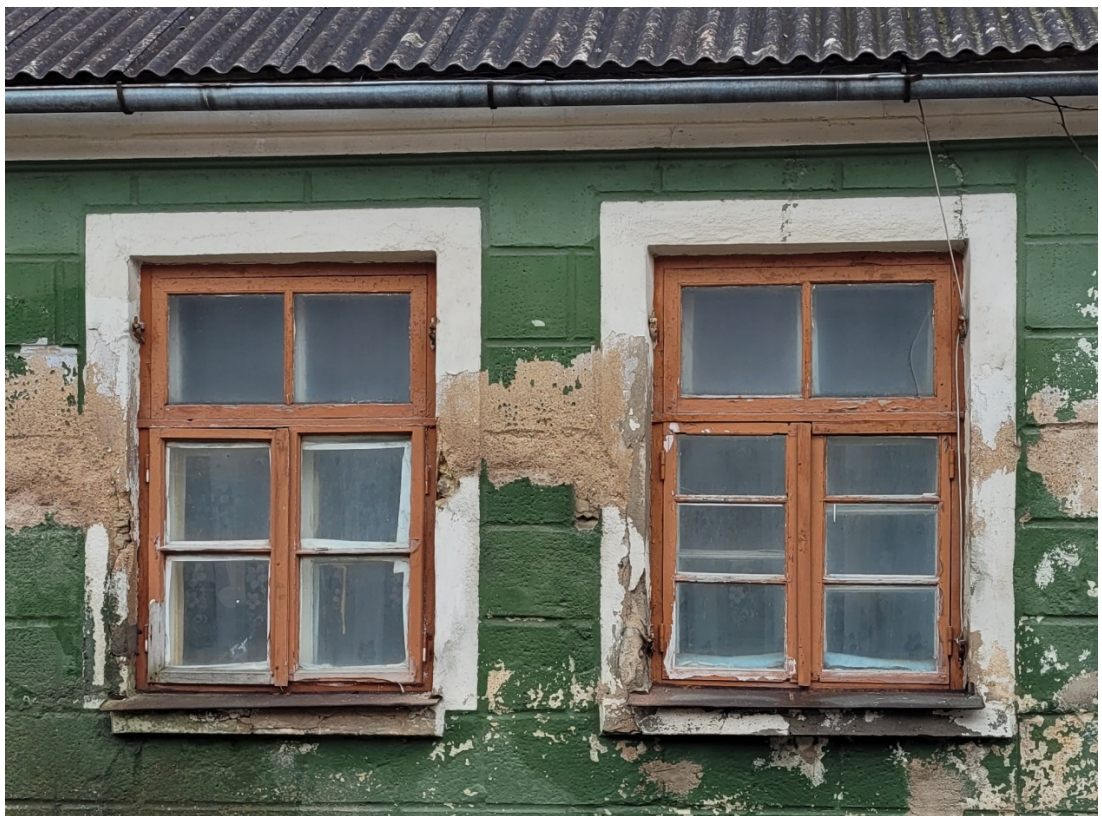
Riigas_14_88130040040001_logi1 Sākotnēji logi. Mainītas apakšējās ārējās vērtnes. Uz aplodas saglabājušies slēgu viru kāši.
