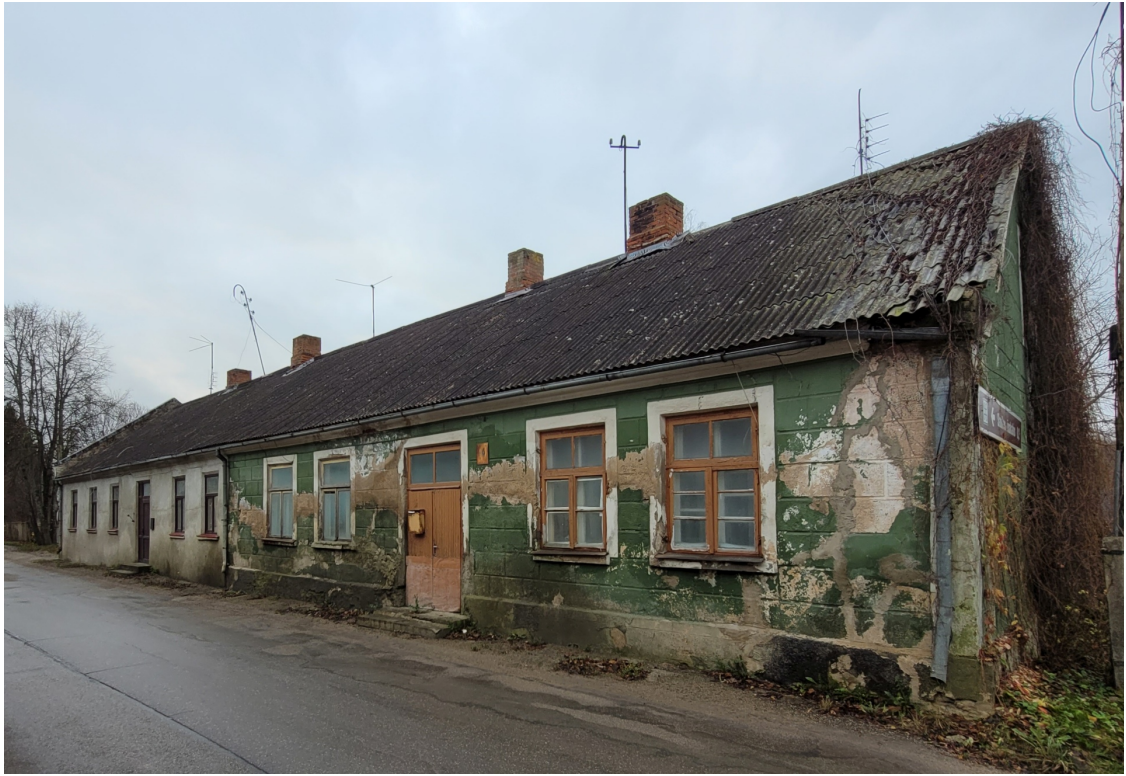
Riigas_14_88130040040001_fasade1 Skats uz ēku no ziemeļiem.
