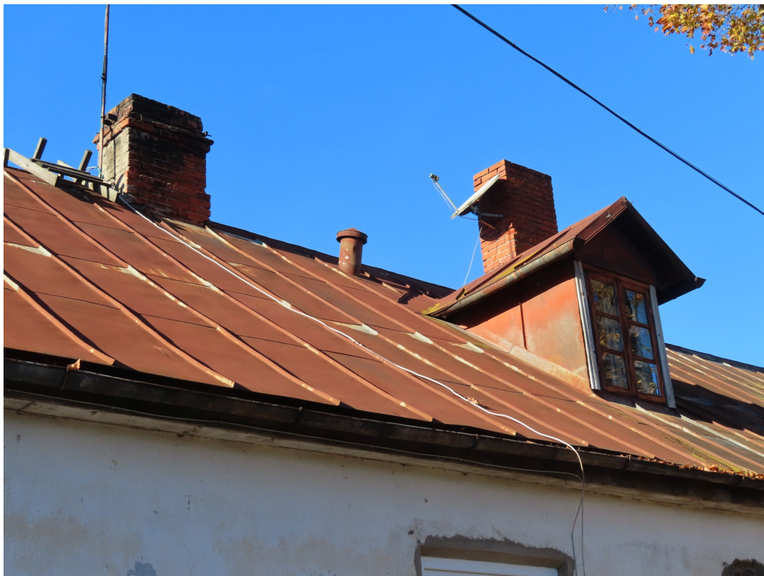
Riigas_13_88130040012002_fragments4 Domājams, vēsturiska jumta loga izbūve. Pa kreisi sākotnējs skurstenis (pārmūrēta augšdaļa).
