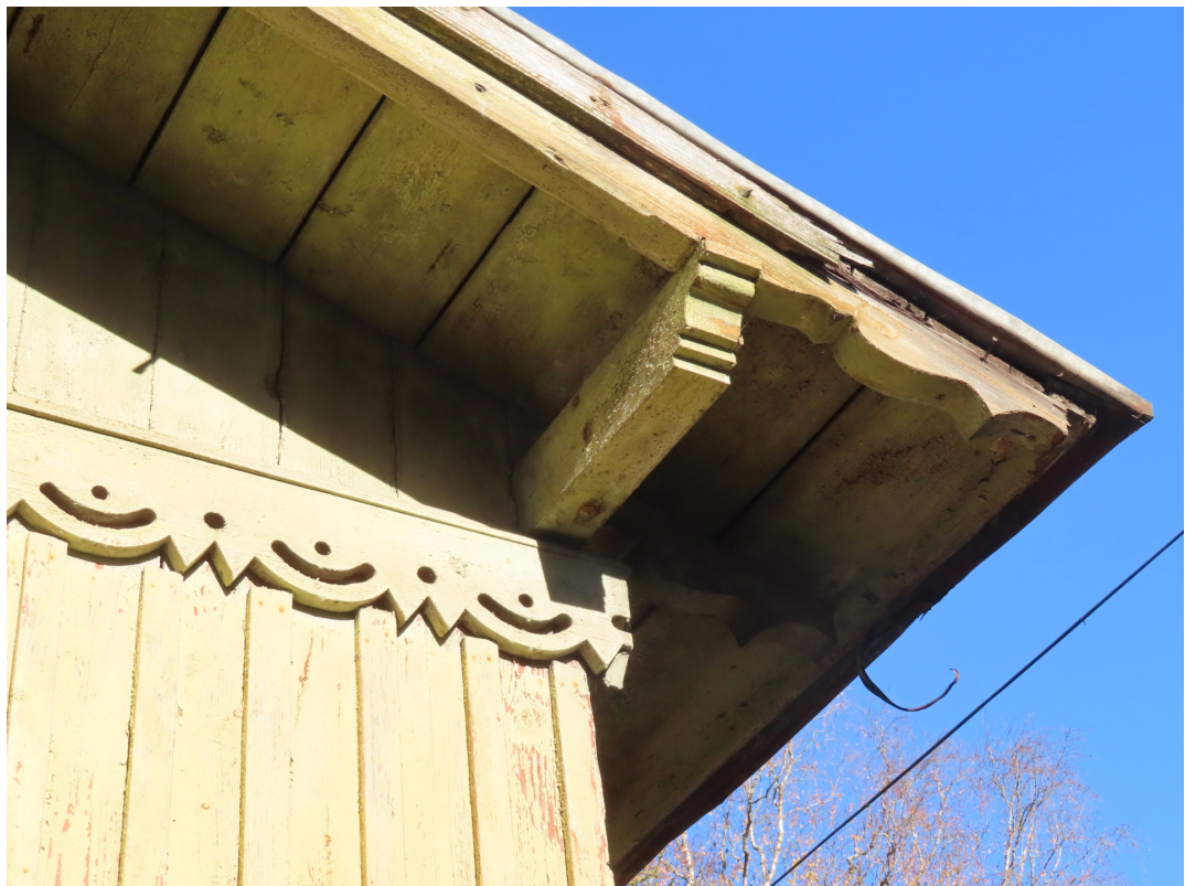
Riigas_13_88130040012002_fragments2 Sija un spāres ar profilētiem galiem un siluētgriezuma dekora josla ieejas piebūvē.
