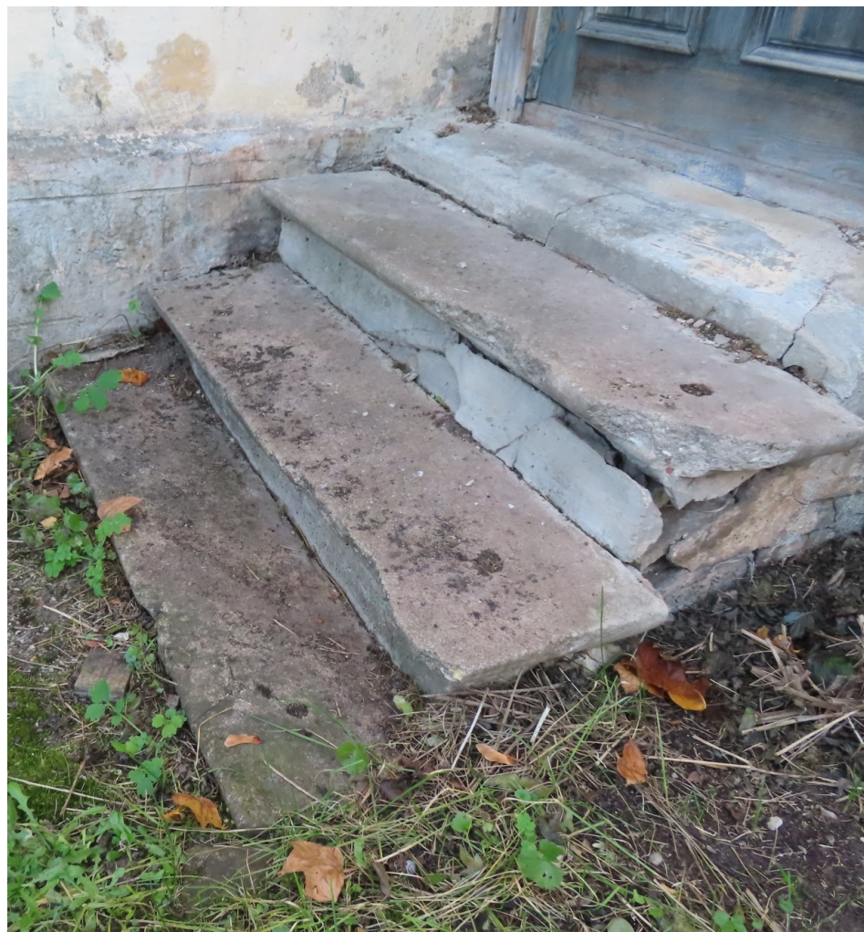
Riigas_13_88130040012002_detaļa1 20.gs. 1.cet. kāpnes.
