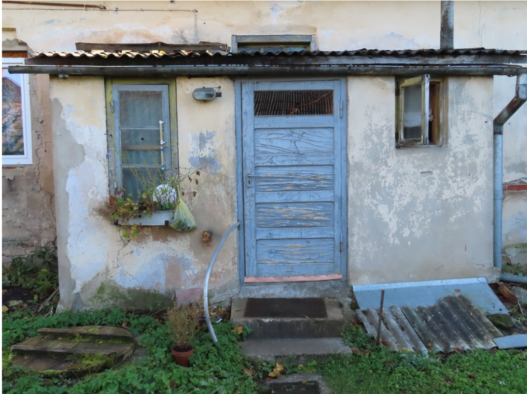
Riigas_13_88130040012002_fasāde7 20.gs. 1.ceturkšņa atejas piebūve (no durvīm palabi) pie ēkas ziemeļrietumu fasādes Piebūve pagarināta 1960.gados. Saglabājušies piebūves daļu celtniecības laikam atbilstoši būvgaldniecības izstrādājumi.
