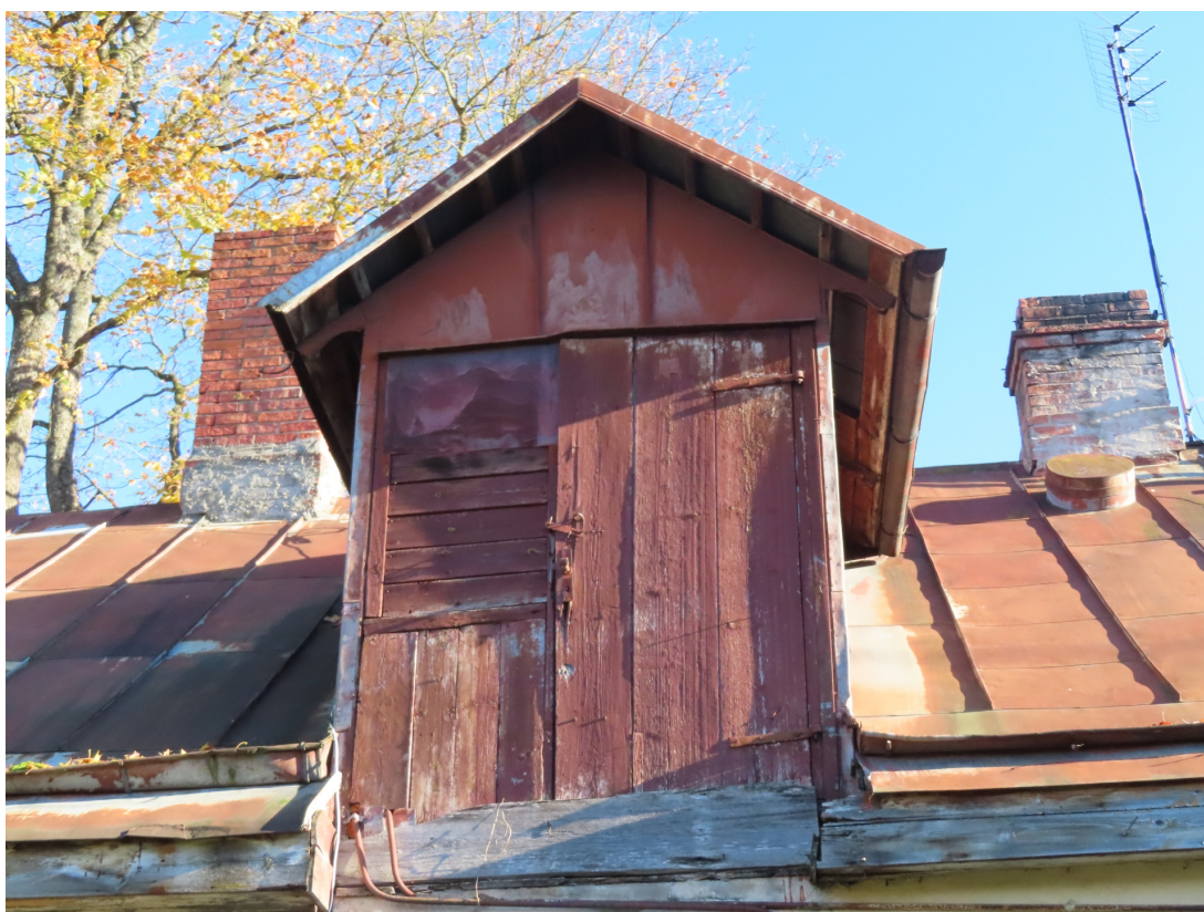
Riigas_13_88130040012002_fragments5 Sākotnēja jumta izbūve ar durvju vērtņi. Aprīkojums sekundārs.
