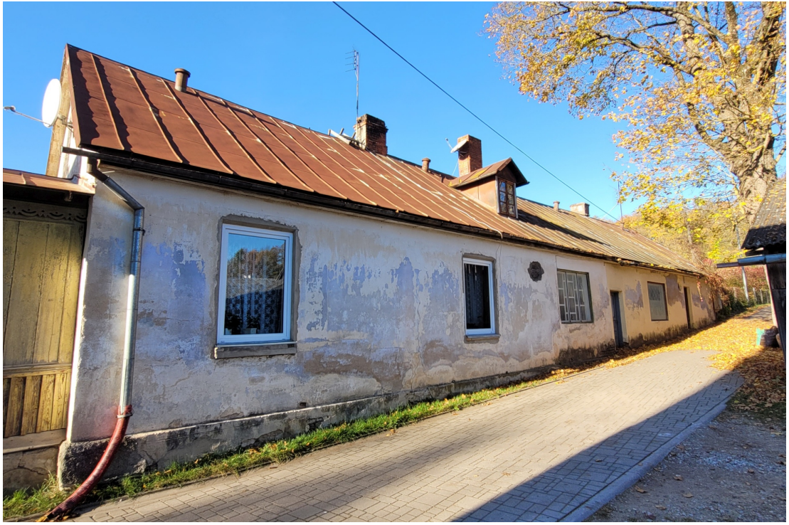
Riigas_13_88130040012002_fasade1 Skats uz ēku no dienvidiem.
