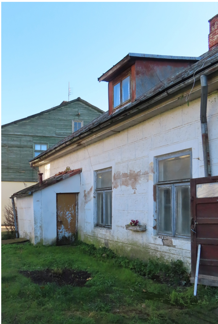
Riigas_13_88130040012001_fasade5 Ēkas ziemeļaustrumu fasādes austrumu puse.
