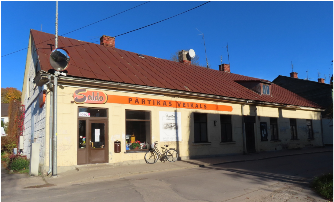
Riigas_13_88130040012001_fasade1 Skats uz ēku no dienvidrietumiem.
