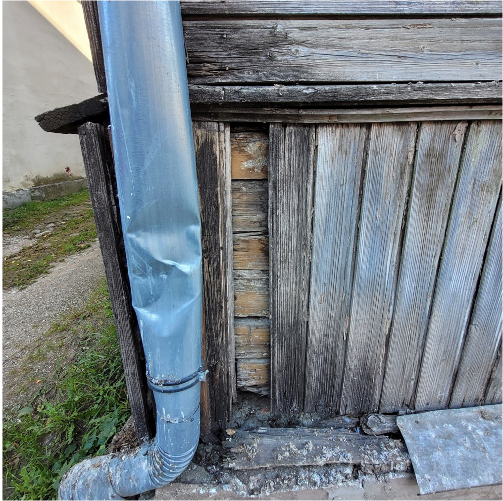
Riigas_9_88130010003001_fragments2 Dienvidrietumu fasādes cokoldaļā atsegts fragments ar sākotnējiem guļbaļķiem.
