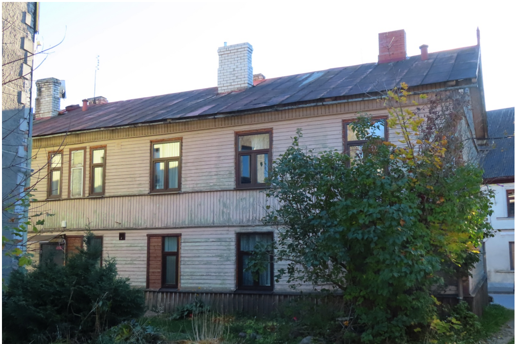
Riigas_9_88130010003001_fasade4 Ēkas ziemeļaustrumu fasādes ziemeļu puse.
