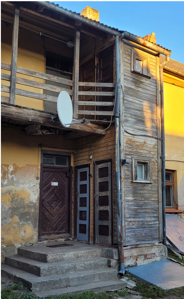
Riigas_8_1_88130020128001 _fragments2 1960.gadu koka piebūve pagalma fasādē.
