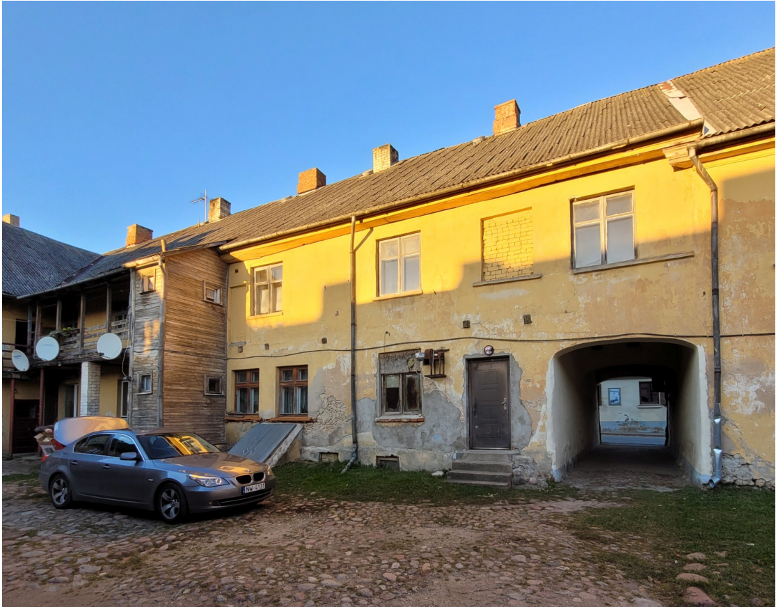
Riigas_8_1_88130020128001_fasāde2 Skats uz ēkas ielas korpusu no dienvidiem. Koka piebūve – 1960.gadi.
