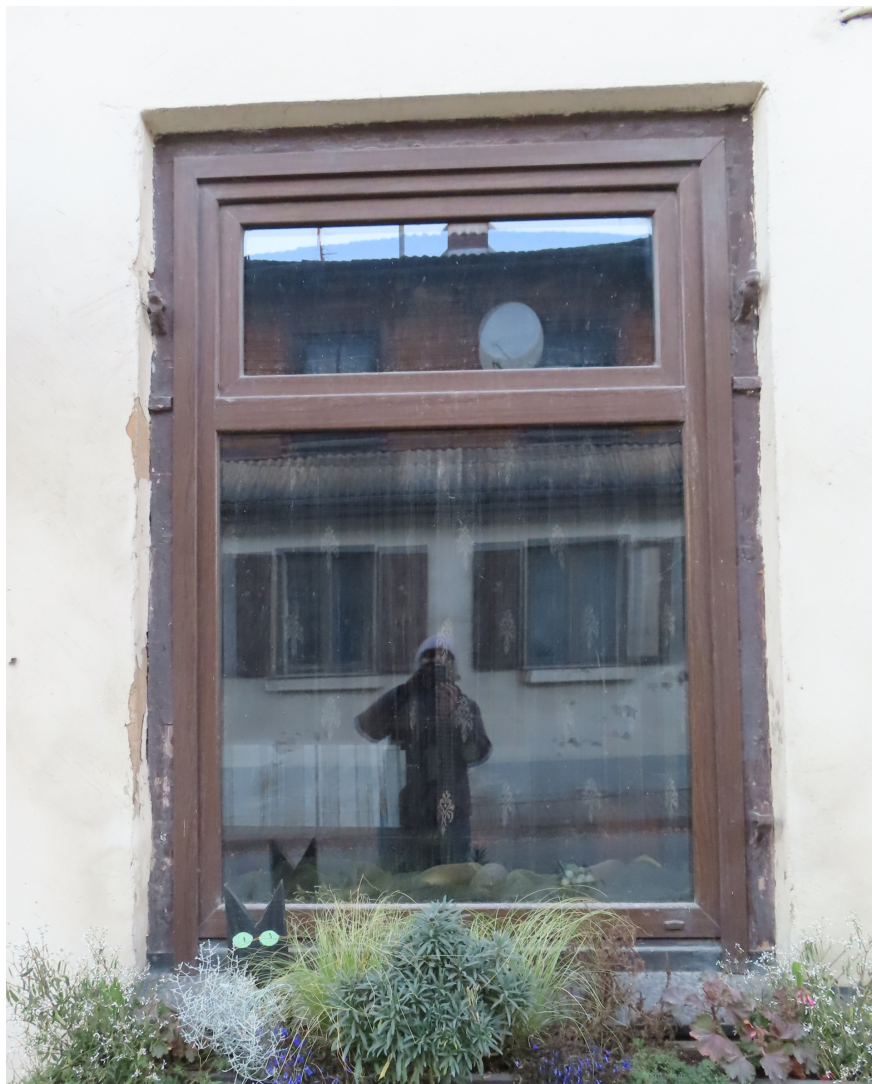
Riigas_8_1_88130020128001_logs1 Saglabājusies sākotnēja loga aploda ar slēgu kāšu virām.
