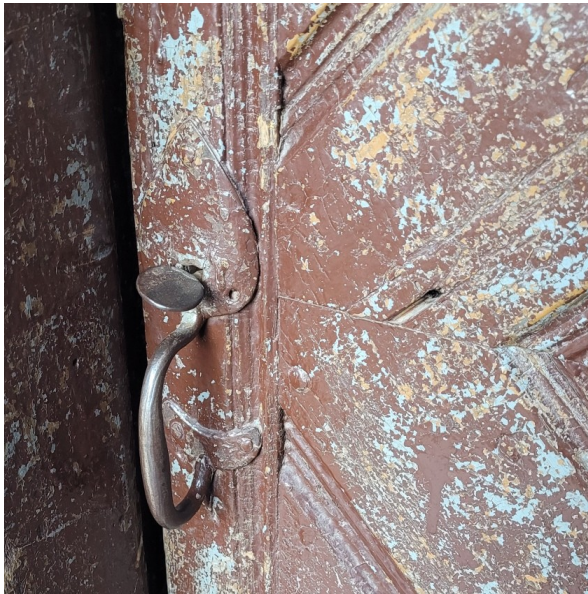
Riigas_8_1_88130020128001_durvis2 Sākotnējs rokturis ar nospiežamu mēlīti.
