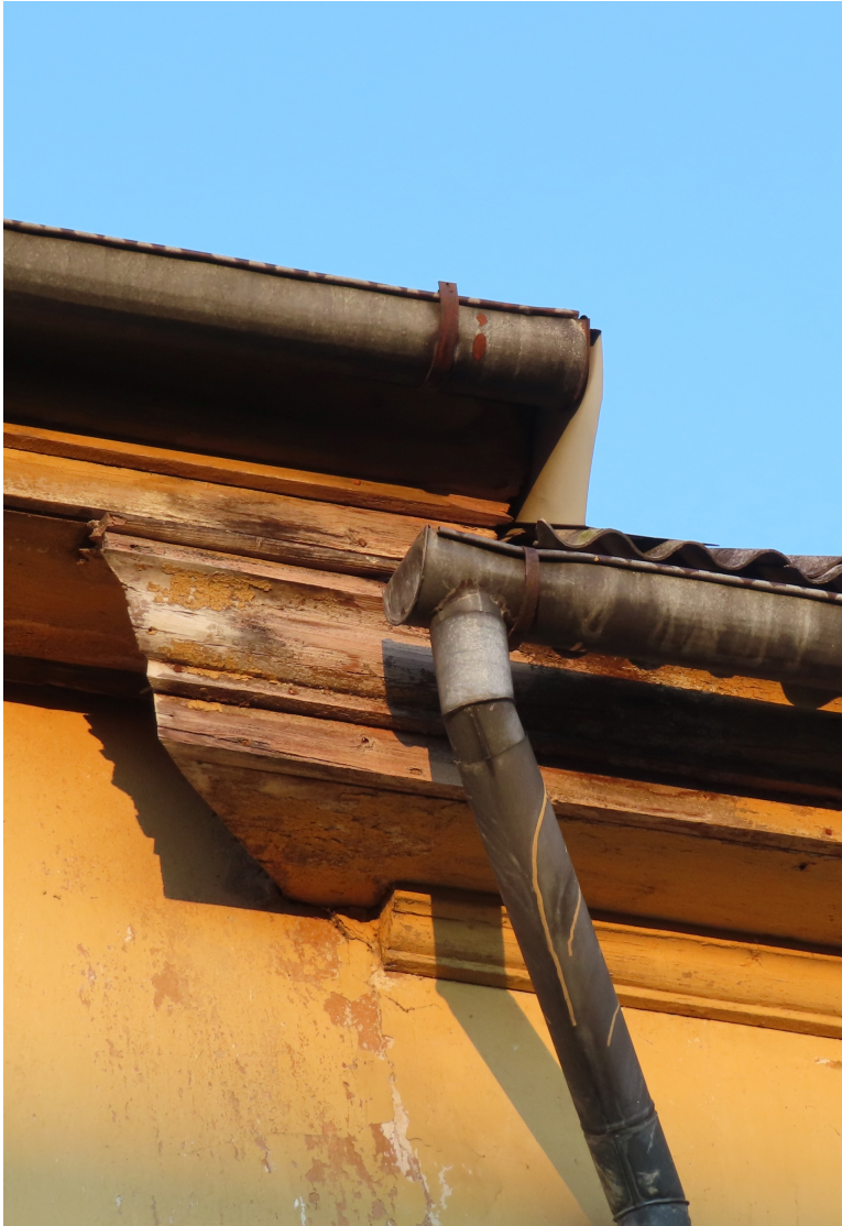
Riigas_8_88130020128001 _dzega2 Sākotnējā koka dzega divu ēku sadurvietā pagalma fasādē.
