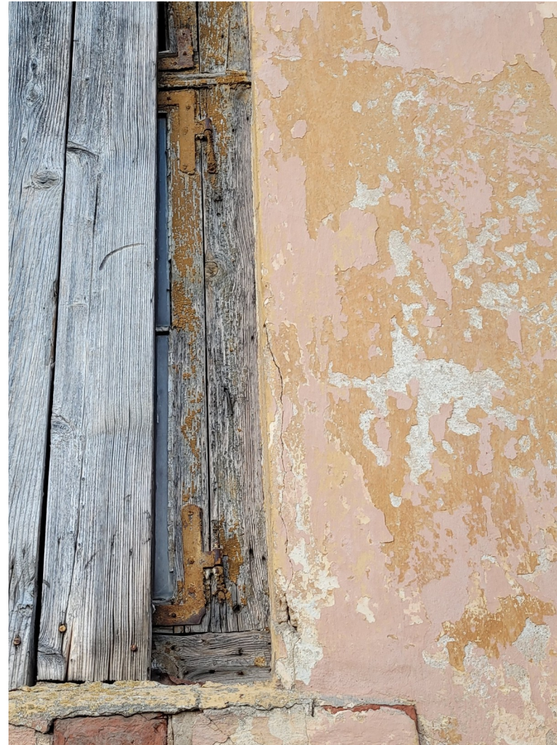
Riigas_8_88130020128001_logs2 Sākotnējā loga fragments. Saglabājies aprīkojums.
