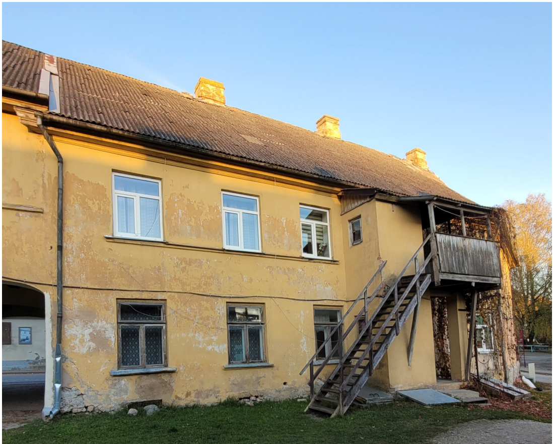
Riigas_8_88130020128001_fasade3 Skats uz ēku no rietumiem. Mūra piebūve – 1960.gadi. Koka piebūve un kāpnes 20.gs. beigas.
