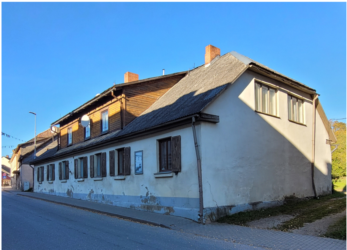
Riigas_7_88130010064001_fasade2 Skats uz ēku no dienvidiem. Koka vairogi – slēgu butaforija.
