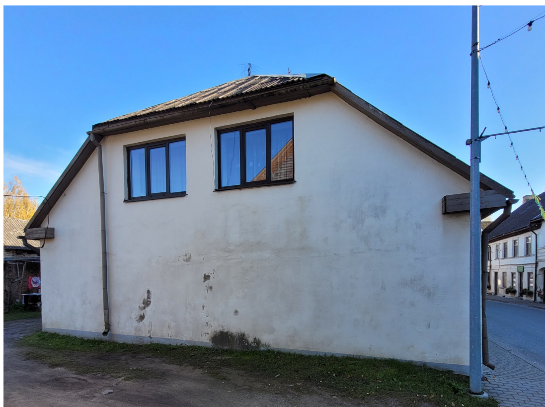
Riigas_7_88130010064001_fasade4 Skats uz ēku no ziemeļrietumiem. 1960.gados paplatinātas logailas.
