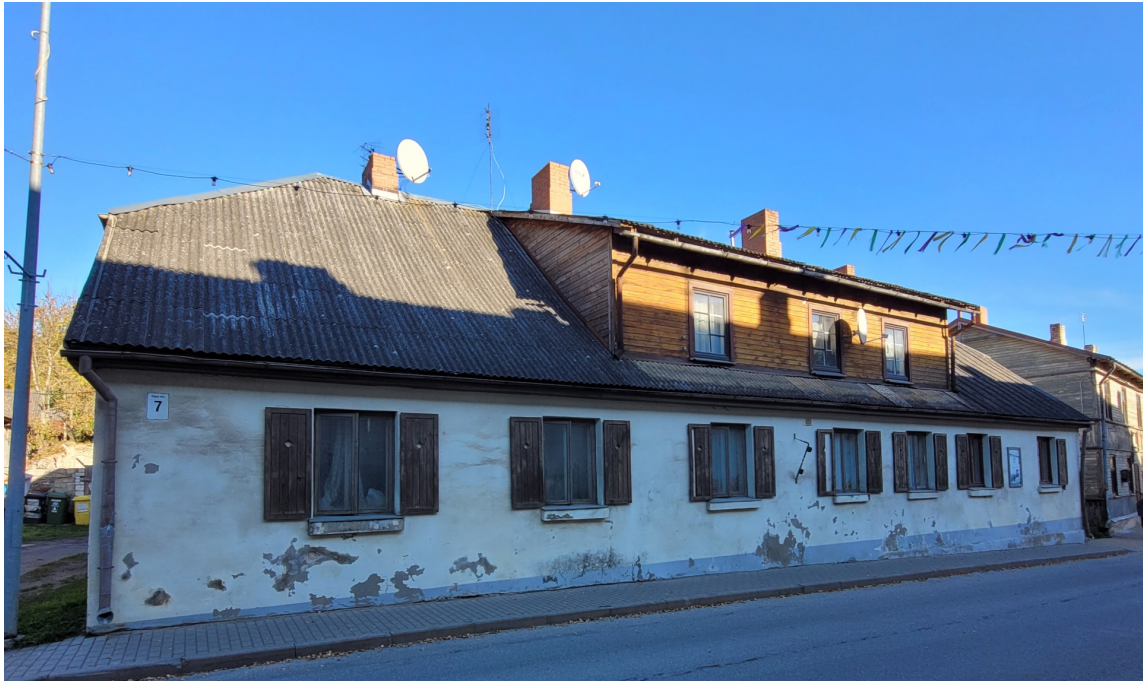
Riigas_7_88130010064001_fasade1 Skats uz ēku no dienvidrietumiem. Jumta izbūve – 1960.gadi. Koka vairogi – slēgu butaforija.
