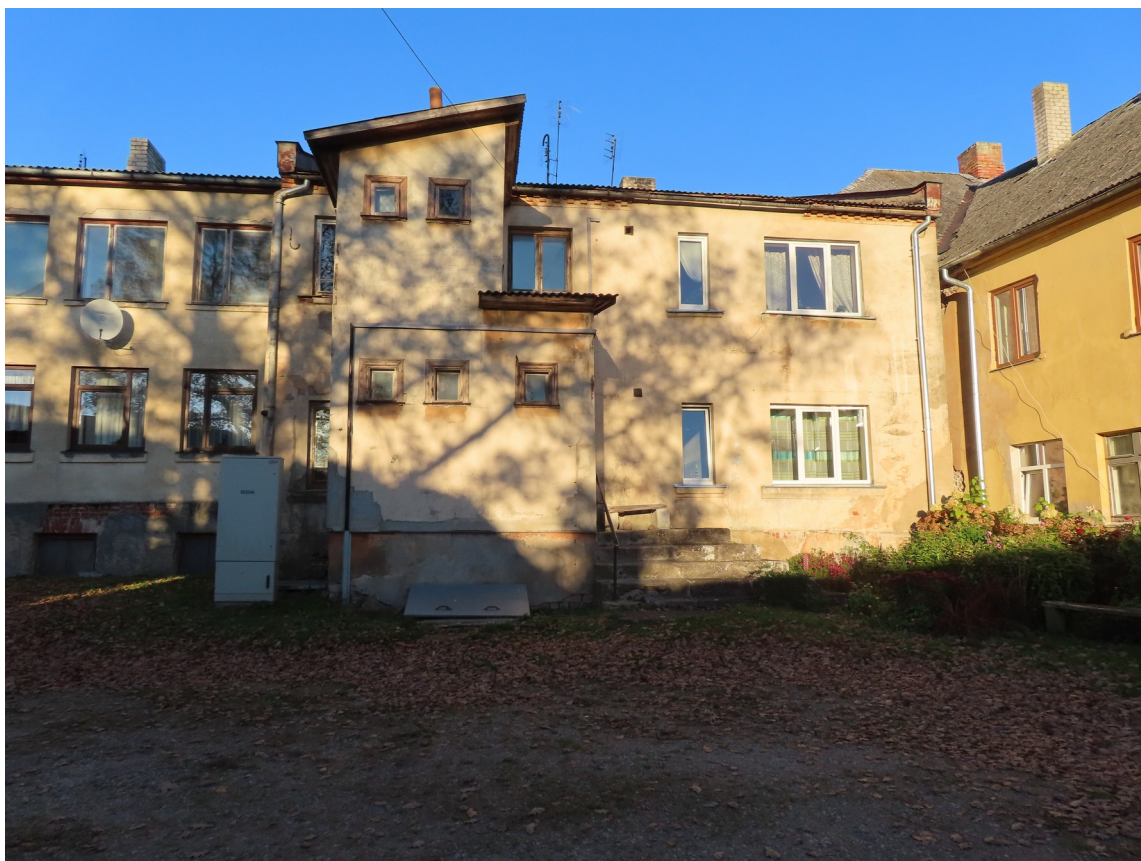
Riigas_4_6_88130020150002_fasade2 Skats uz ēku no dienvidrietumiem. Piebūve – 1960.gadi.
