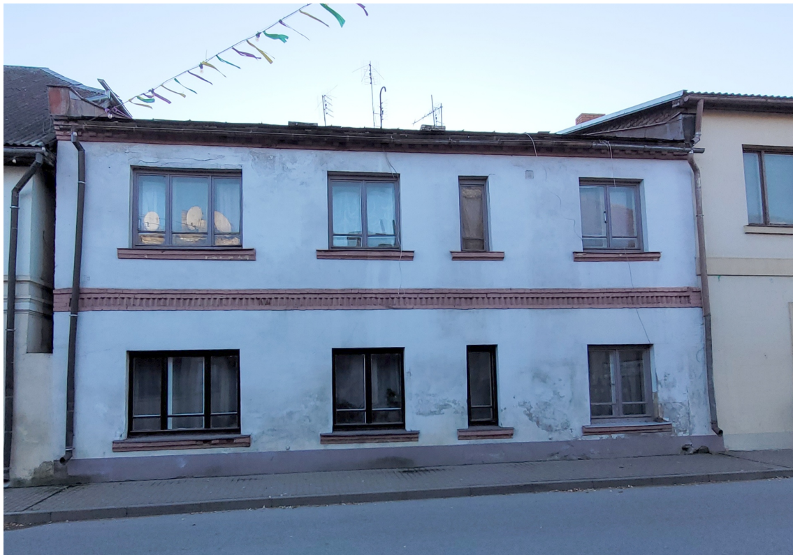
Riigas_4_6_88130020150002_fasāde1 Skats uz ēku no ziemeļaustrumiem.
