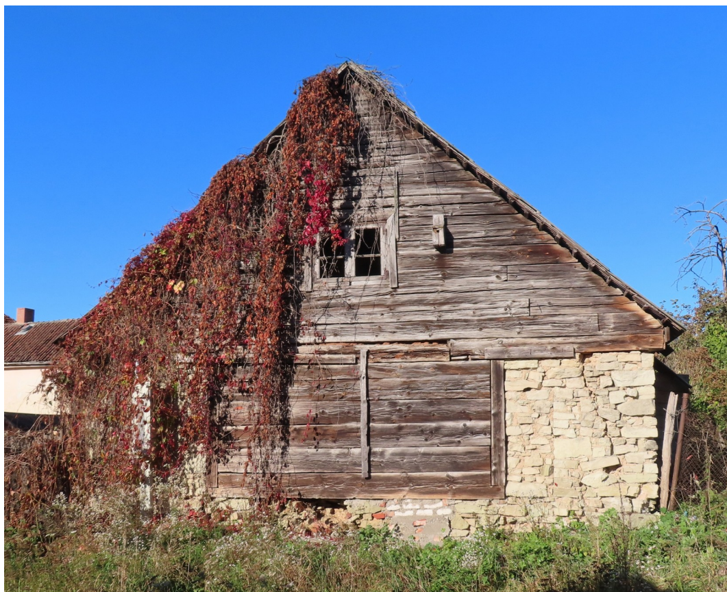
Riigas_3_5A_88130010060001_002_fasade3 Skats uz ēku no dienvidaustrumiem.
