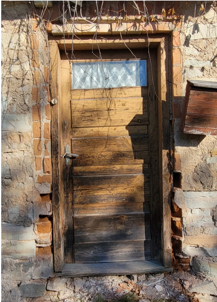
Riigas_3_5A_88130010060001 _002_durvis1 Samazināta durvjaila ar 1960.gadu durvīm.
