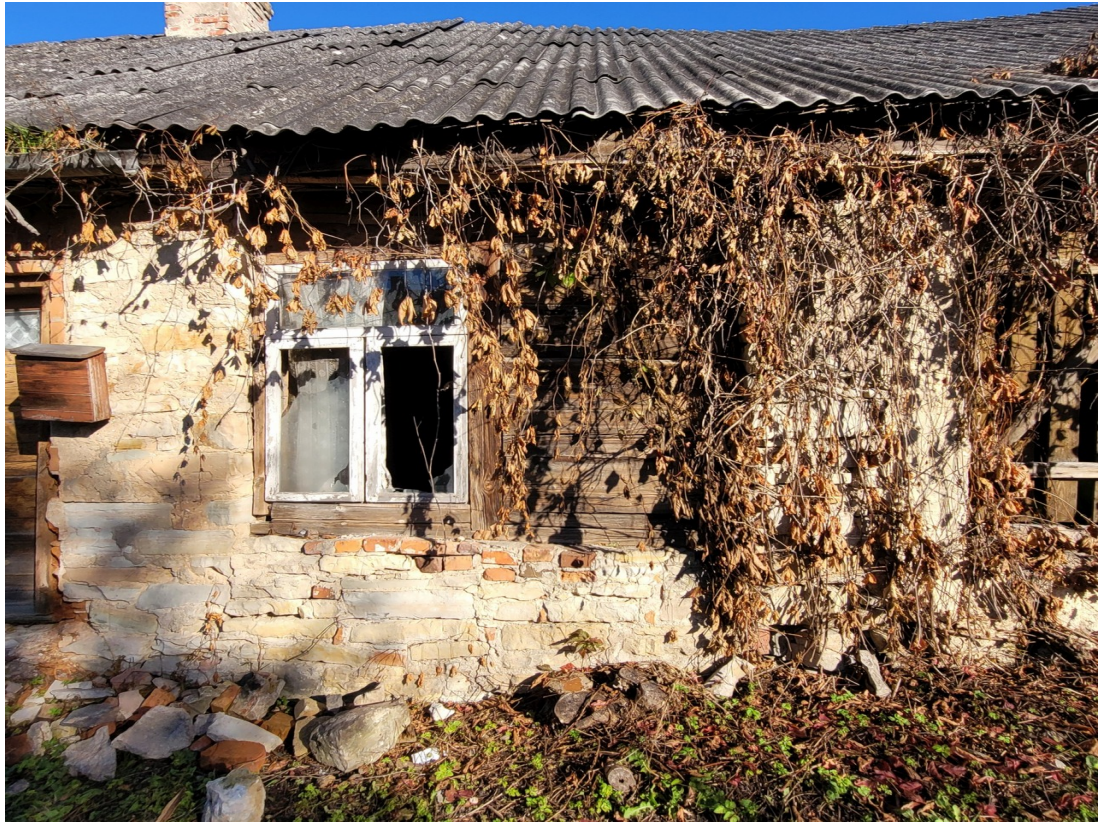
Riigas_3_5A_88130010060001_002_fasade5 Skats uz dienvidrietumu fasādes vidusdaļu. Logš sekundārs, 20.gs. 2.puse.
