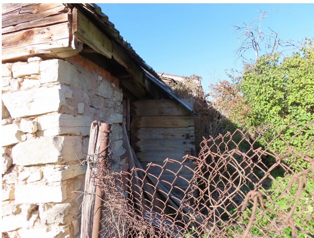
Riigas_3_5A_88130010060001_002_fasade4 Skats ziemeļaustrumu fasādi no austrumiem. Saglabājušās sākotnējās durvis.
