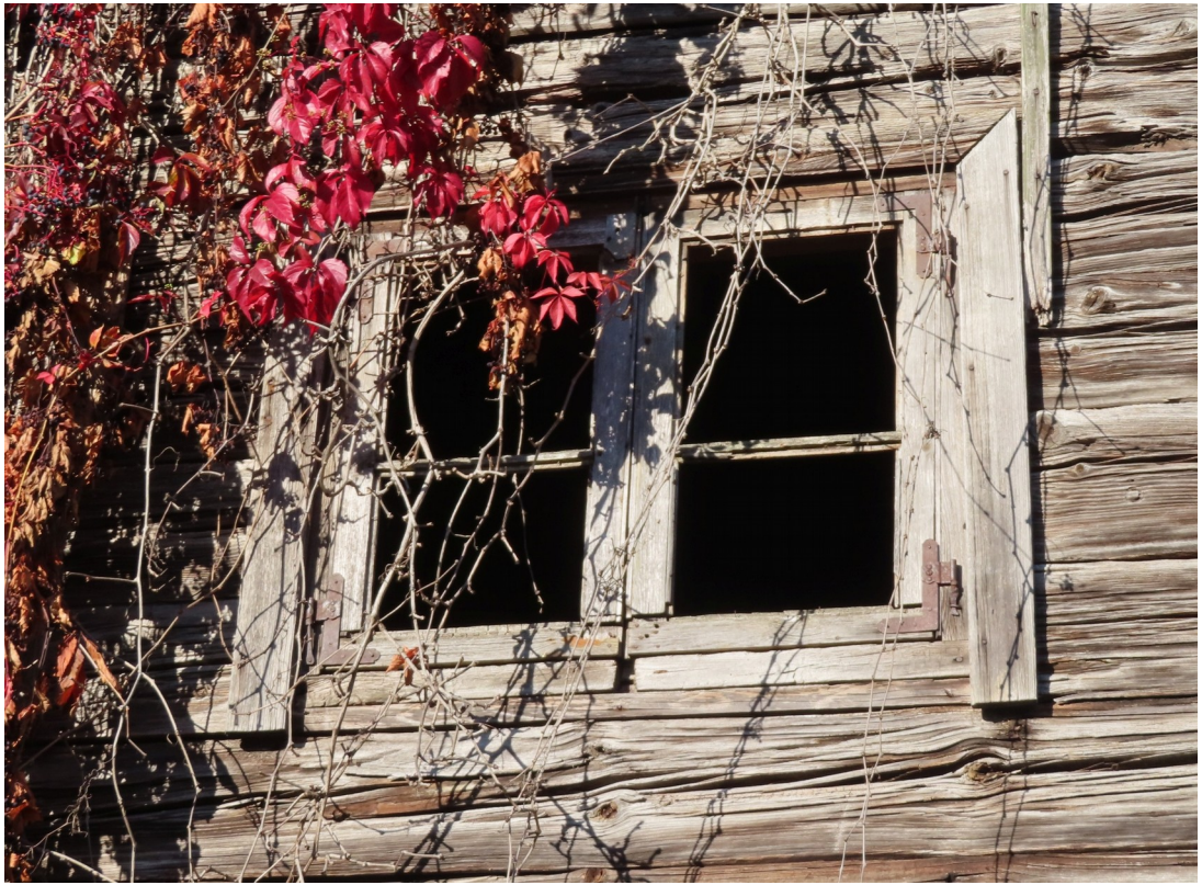
Riigas_3_5A_88130010060001_002_logs1 Sākotnējs logs ar aprīkojumu. 19.gs. beigas – 20.gs. sākums.
