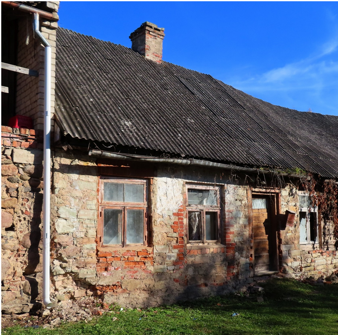
Riigas_3_5A_88130010060001_002_fasade2 Skats uz ēku no rietumiem. Logi un durvis iebūvēti 1960.gados.
