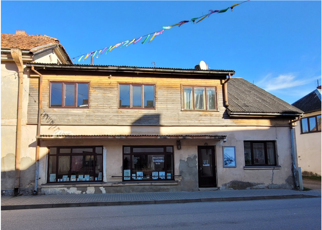
Riigas_3_5_88130010004002_fasade1 Skats uz ēku no dienvidrietumiem. Ēkas arhitektoniskais veidols – 1960.gadi.
