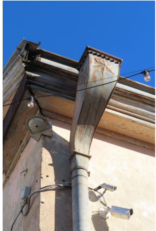
Riigas_3_5_88130010004001_detala1 Saglabājusies 20.gs. sākuma savācējkrāba (pēc 1910.gada).
