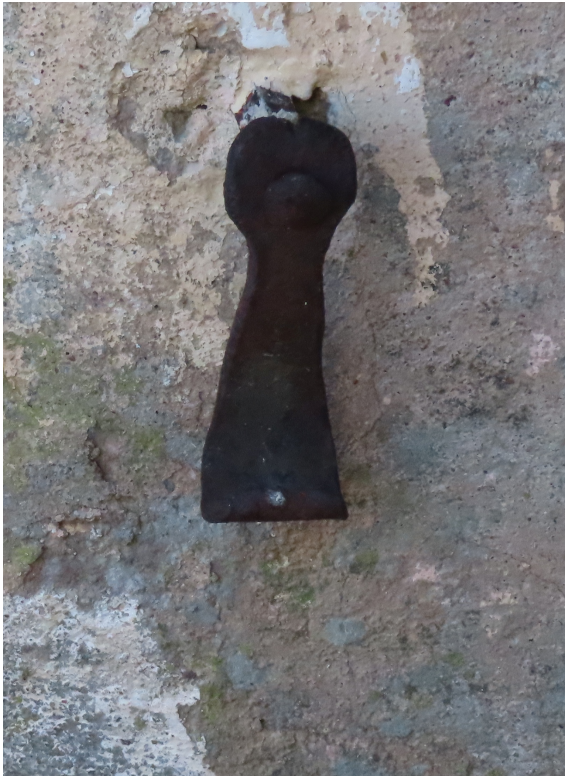
Riigas_3_5_88130010004001_slegis1 Sākotnējs slēģa atvērta stāvokļa fiksators.
