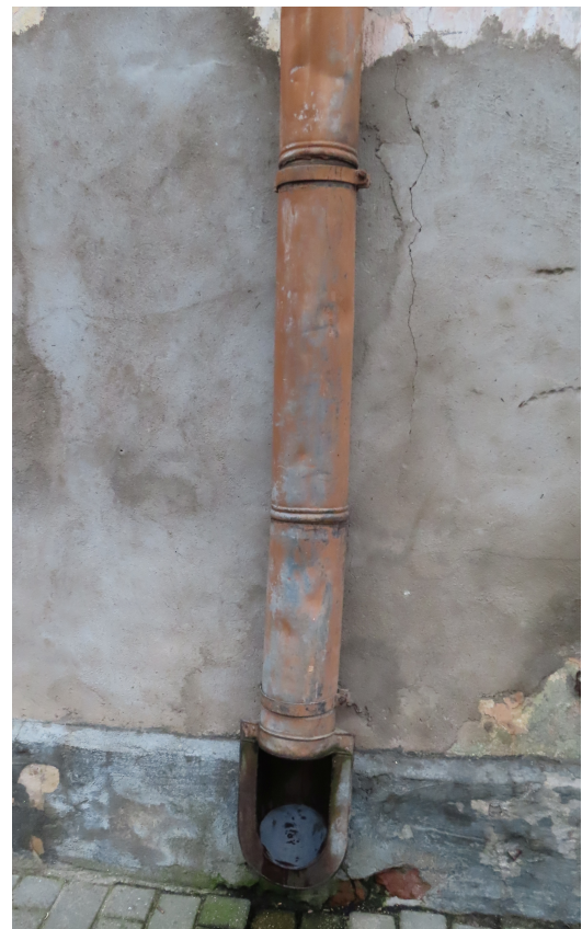
Riigas_3_5_88130010004001_detala2 20.gs. sākuma notekcaurules apakšējā daļa (pēc 1910.gada).
