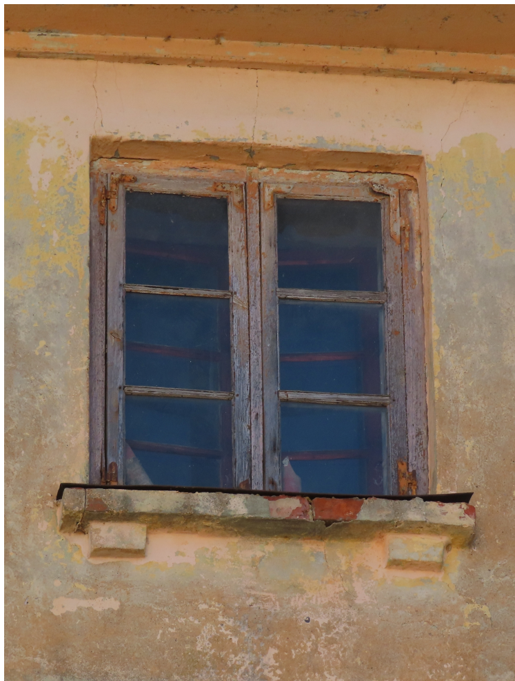
Riigas_3_5_88130010004001_logs1 Sākotnējs logs ziemeļrietumu fasādē. Saglabājies aprīkojums
