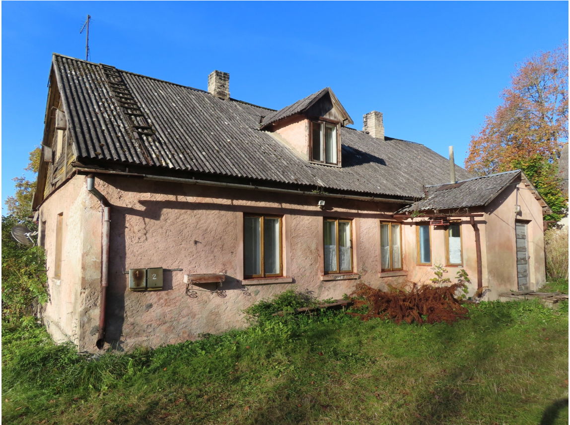
Pilskalna_12_88130040059001_fasade3 Skats uz ēku no ziemeļaustrumiem. Jumta izbūve – 1920.gadi. Piebūve - (1960.gadi) vēsturiskā koka lieveņa vietā. 1960.gados mainīts ailojums.
