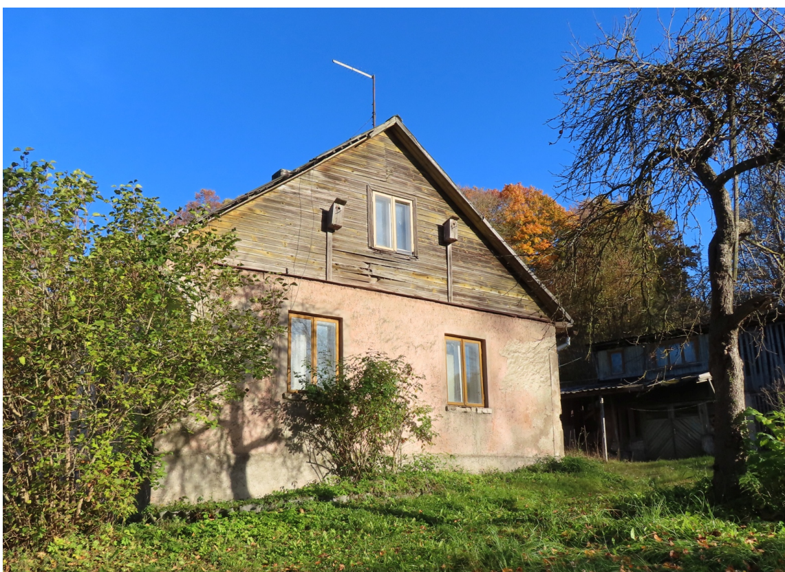
Pilskalna_12_88130040059001_fasade2 Skats uz ēku no dienvidaustrumiem. Zelminim 1960.gadu dēļu apšuvums.
