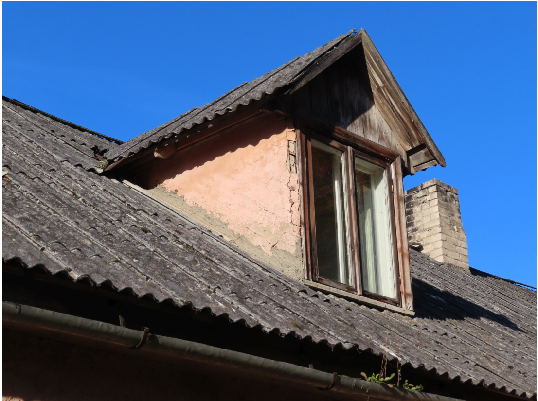
Pilskalna_12_88130040059001_fragments1 1920.gadu jumta loga izbūve ēkas austrumu fasādē. Logs – 1960.gadi.
