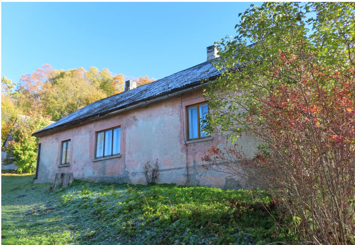
Pilskalna_12_88130040059001_fasade1 Skats uz ēku no dienvidrietumiem.
