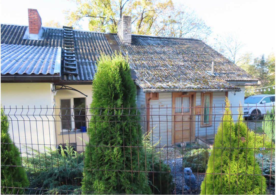
Pilskalna_9_88130040062001_fasade3 Skats uz ēku no ziemeļaustrumiem. Piebūve ar dēļu apšuvumu -20.gs. 60.gadi.
