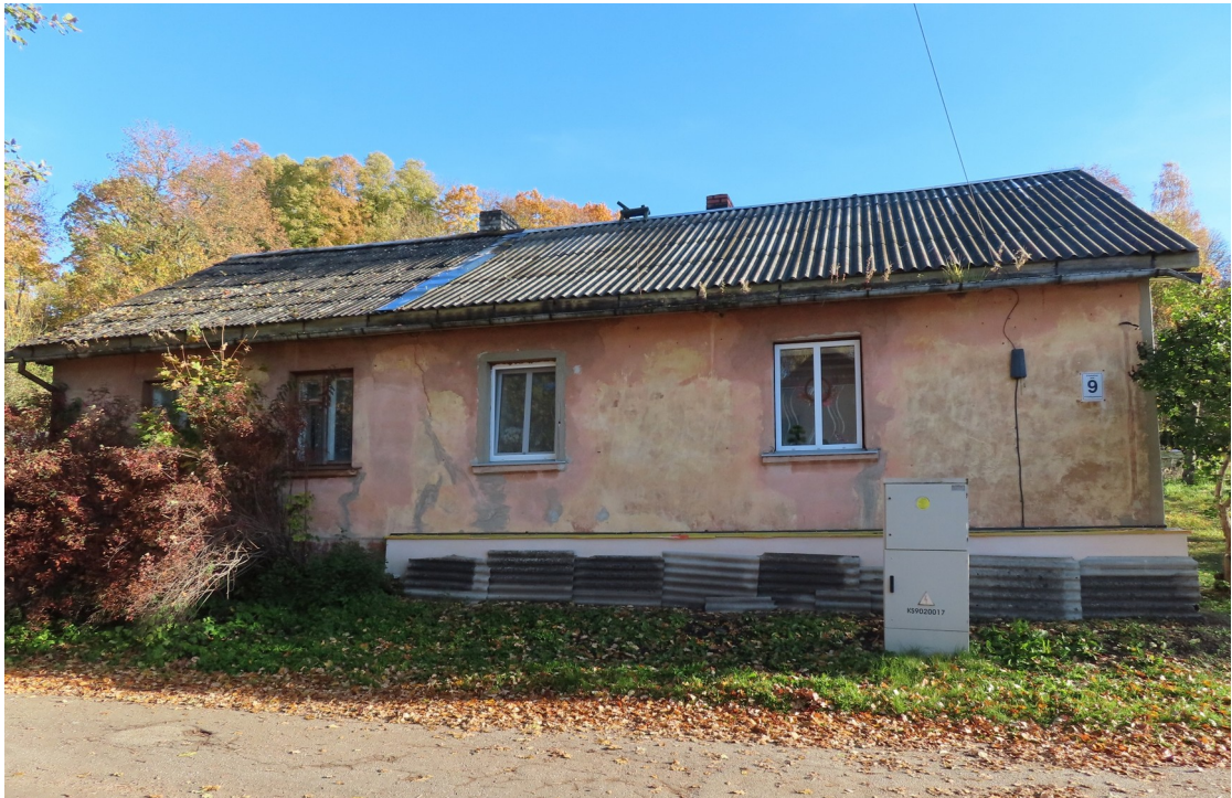
Pilskalna_9_88130040062001_fasade1 Skats uz ēku no dienvidrietumiem.
