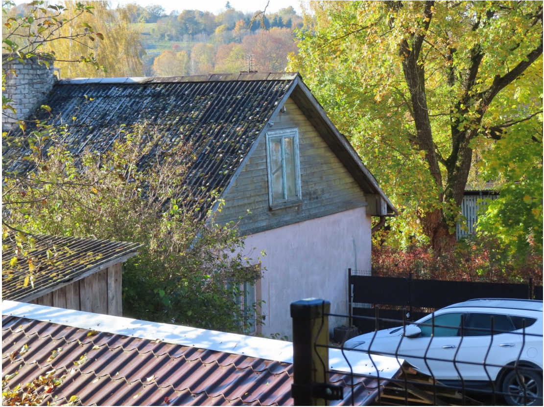
Pilskalna_9_88130040062001_fasade5 Skats uz ēku no zemeļiem.
